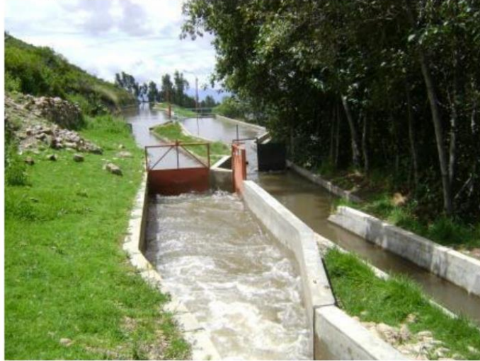
Figura n.º 5: Canal conducción - Cámara de Carga y Desarenador
