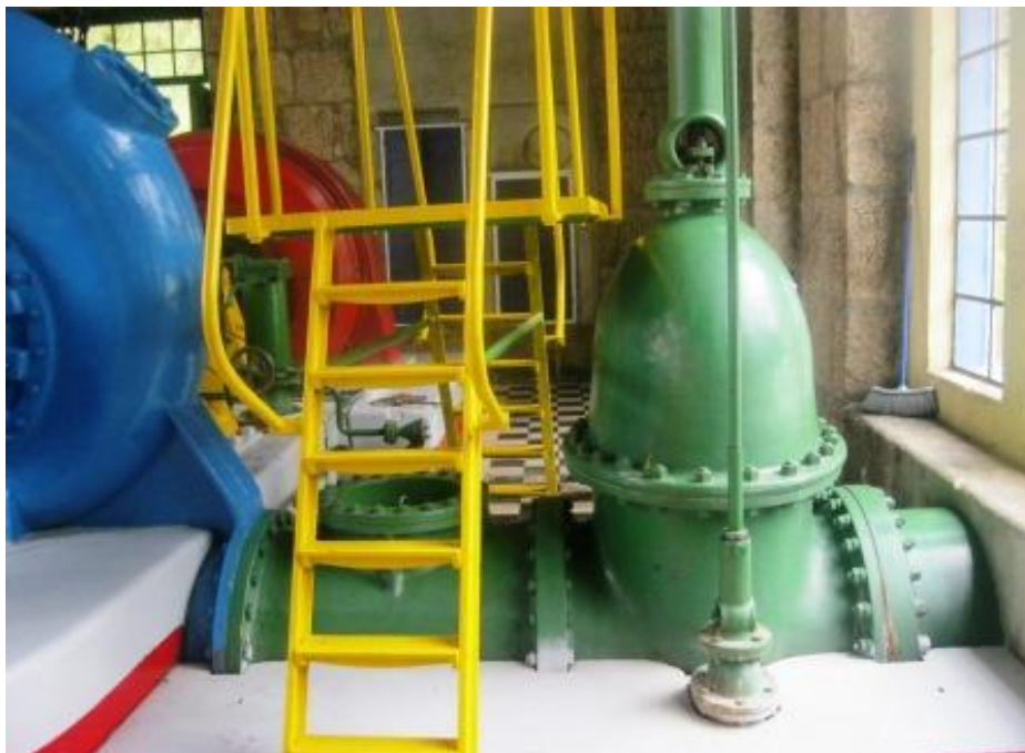
Generador – Turbina – Válvula tipo compuerta con volante mecánico
