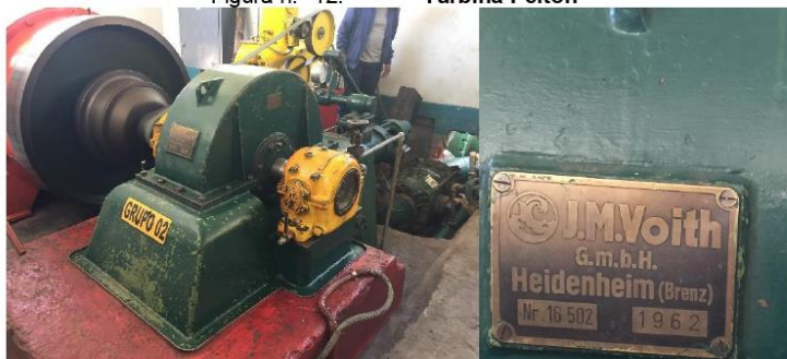
Figura n.º 12: Turbina Pelton
