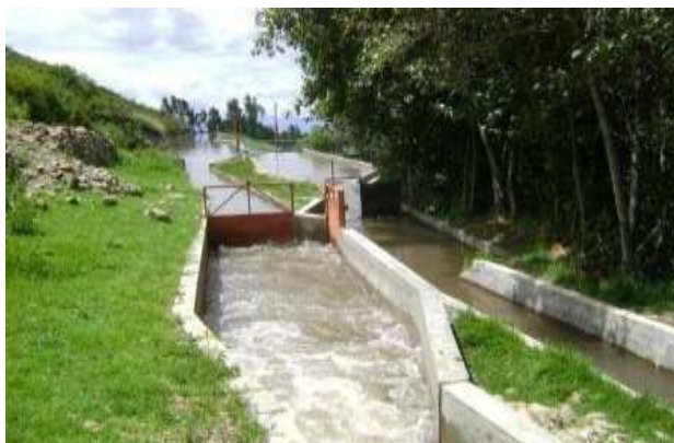
Canal conducción - Cámara de Carga y Desarenador
