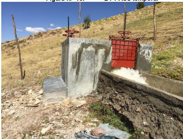
Figura n.º 15: BY PASS temporal
