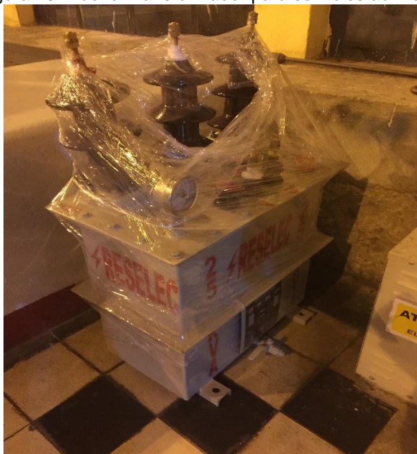
Figura 20: Nuevo Transformador para servicios auxiliares
