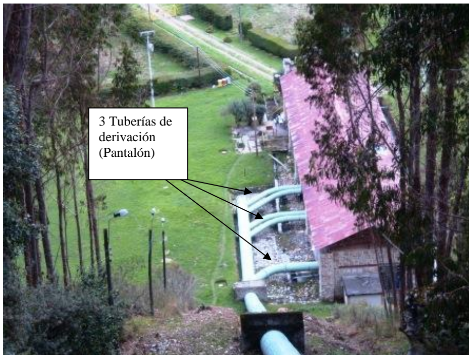
Tubería Forzada principal y tres derivaciones de ingreso (Pantalones)
