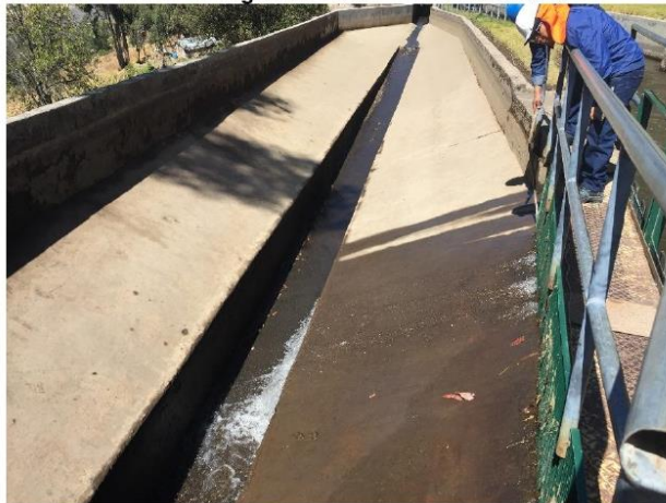
Figura n.º 18: Desarenador
