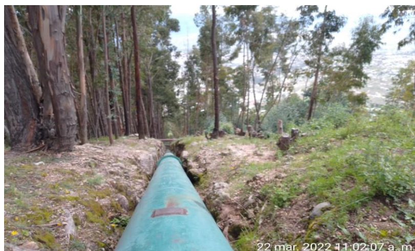
Figura 3: Tubería de Presión
