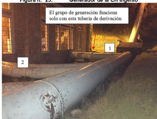
Figura n.º 25: Generador de la CH Ingenio
