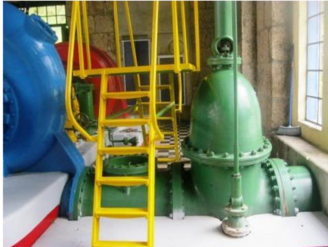
Figura n.º 10: Generador – Turbina – Válvula tipo compuerta con volante mecánico
