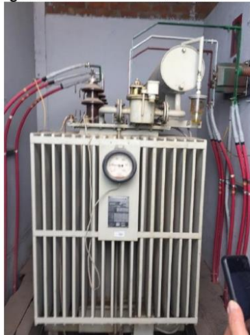
Figura n.º 21: Transformador
