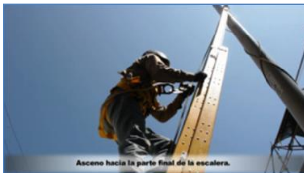
Fotografía 02. Uso del freno de cuerda en el ascenso y descenso
