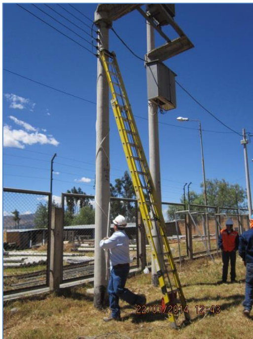
Fotografía 01. Inmovilización de escalera de extensión.
