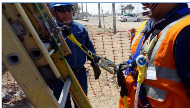
Fotografía 02. Uso del freno de cuerda en el ascenso y descenso
