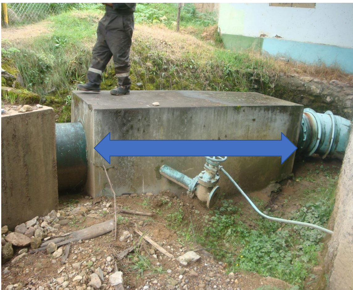
Foto N° 02: Tramo donde se aprecia el anclaje a demolerse y cambio de tubería, se nota el codo De ingreso a la turbina a cambiarse con las mismas características.
