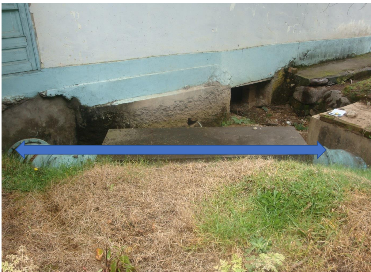
Foto N° 04: vista del tramo total (9 m.) de la tubería de presión ingreso a la turbina a ser cambiado.
