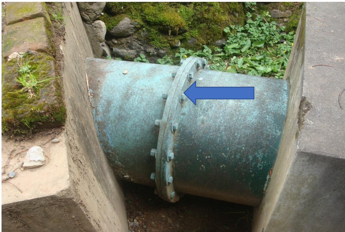
Foto N° 01: Unión embridada donde se inicia en cambio de tubería de ingreso a la turbina.
