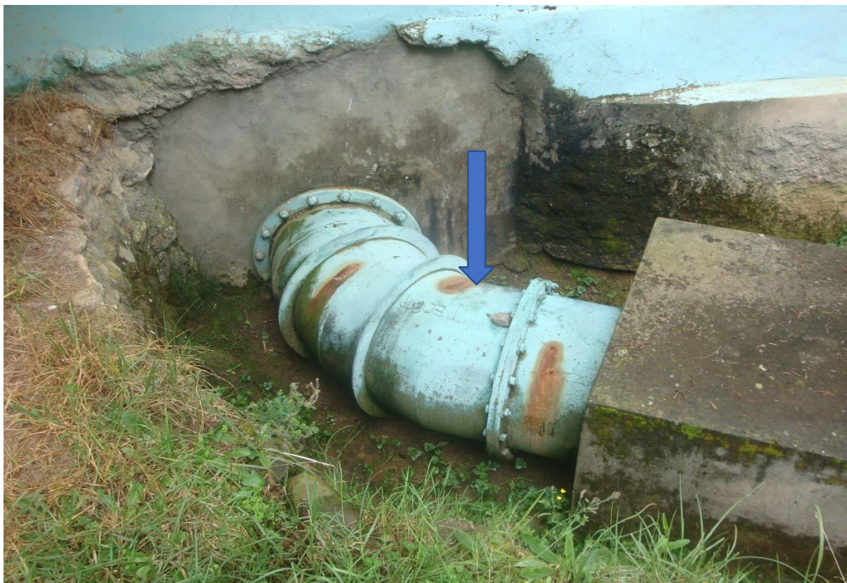
Foto N° 03: Codo de la tubería de presión, ingreso a la turbina a ser cambiado.
