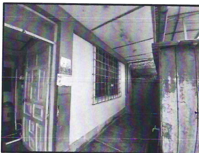
FOTO 04 – (17-03-2023) Se observa en la imagen el cielorraso en pésimo estado debido a las filtraciones de agua de lluvia por el deteriorado estado del techo de calamina.
