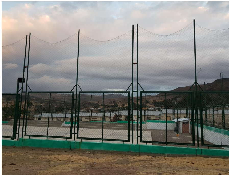
FOTO N° 17: VISTA DEL PERFILES DE ACERO, MALLA OLÍMPICA Y MALLA RASHELL DEL CERCO PERIMÉTRICO.
