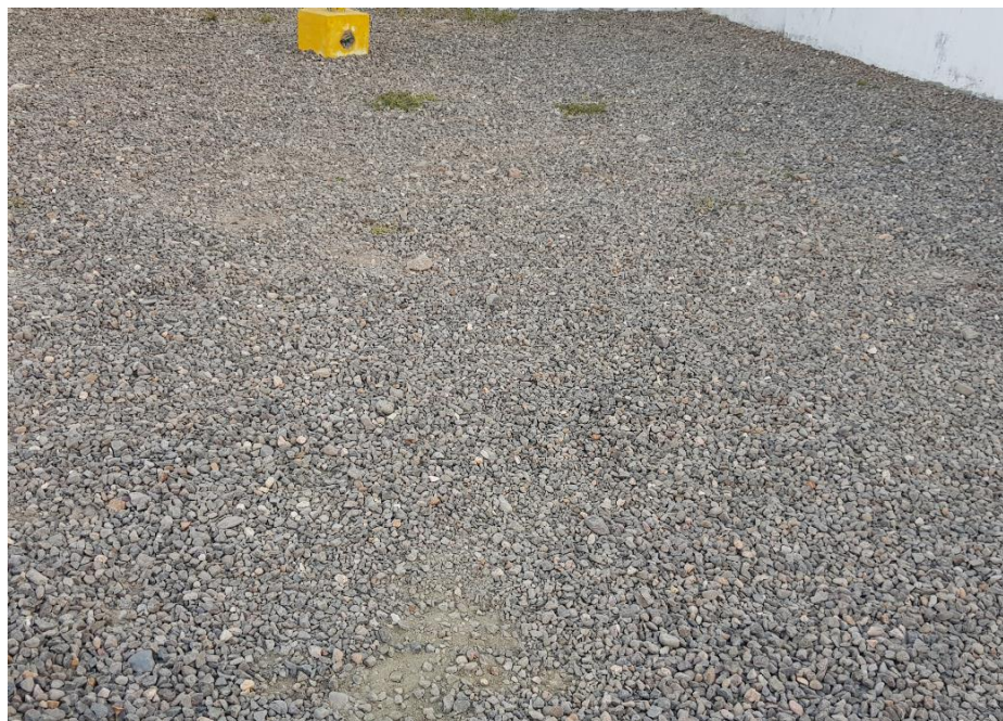
FOTO N° 8: VISTA DE GRAVA DE 1/2" SOBRE PISO DE TIERRA.
