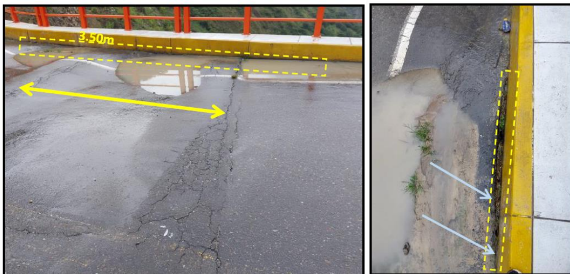
Figura 02. Falla corrugación - grietas
