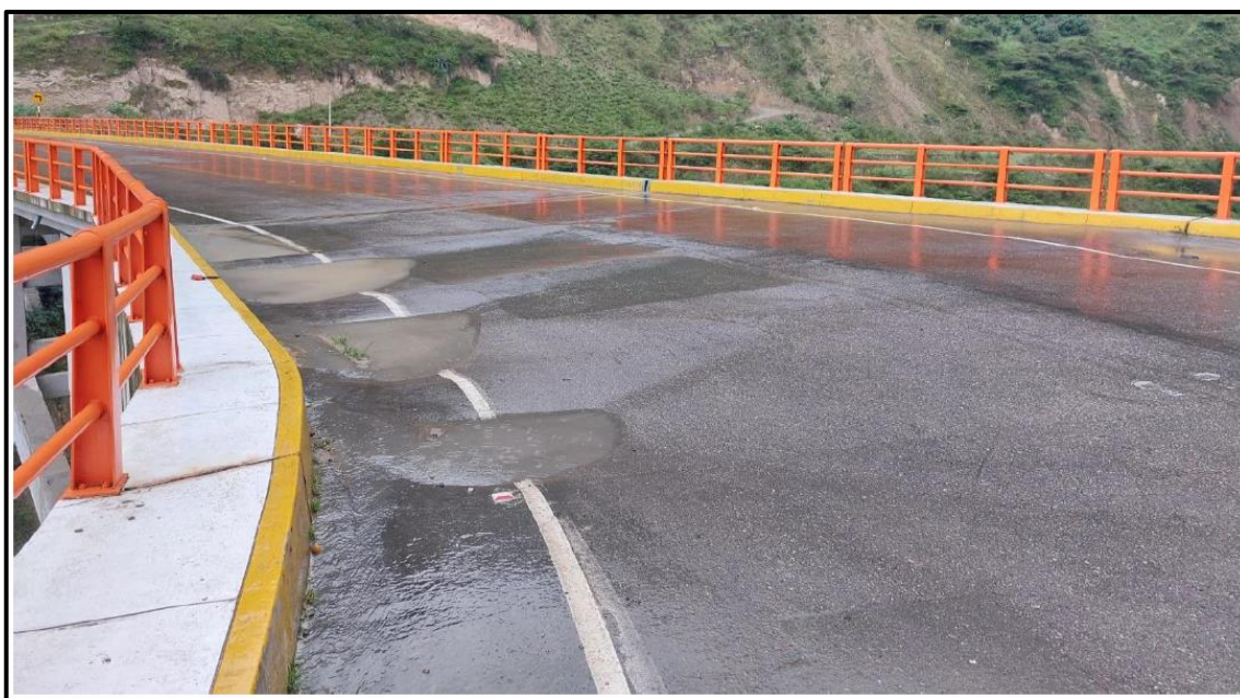
Figura 3. Empozamiento de agua.
