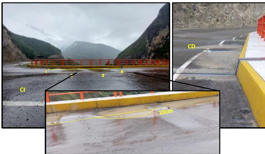
Figura 01. Falla corrugación
