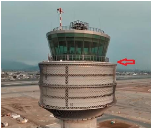
Foto 1: Posición de la baranda del fanal en relación con el techo de la TWR
