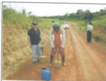
Foto 02: Compactación de Bachas (Decheo), en un Mantenimiento Rutinario.
