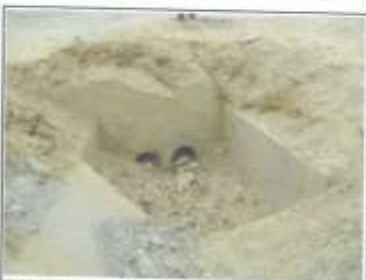
Foto 04: Ingreso de alcantarilla de desfogaje en inicio de tramo, dos tuberías Ø 8" cada una. Cabezal de ingreso en malas condiciones y obstruido.
