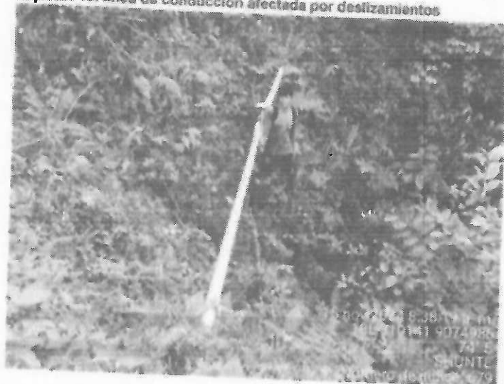
IMAGEN 13: línea de conducción afectada por deslizamientos
