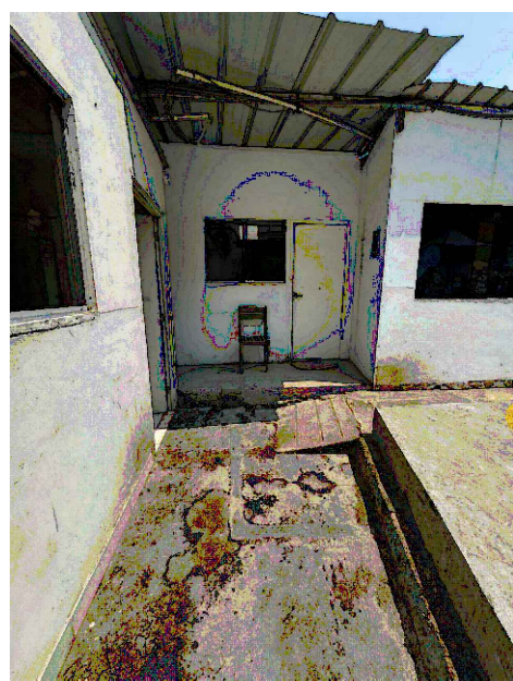
PLATAFORMA -0.30 M: ACUMULACION DE AGUA DE LLUVIA POR ESTAR EN NIVEL BAJO.
