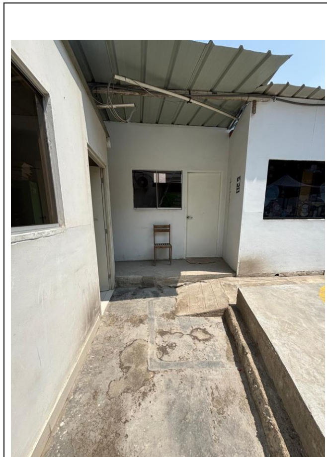
Foto 6. Se observa que en la plataforma -30 se encuentran los pisos en mal estado, además se acumula agua de lluvia por lo que filtra al espacio de odontología.
