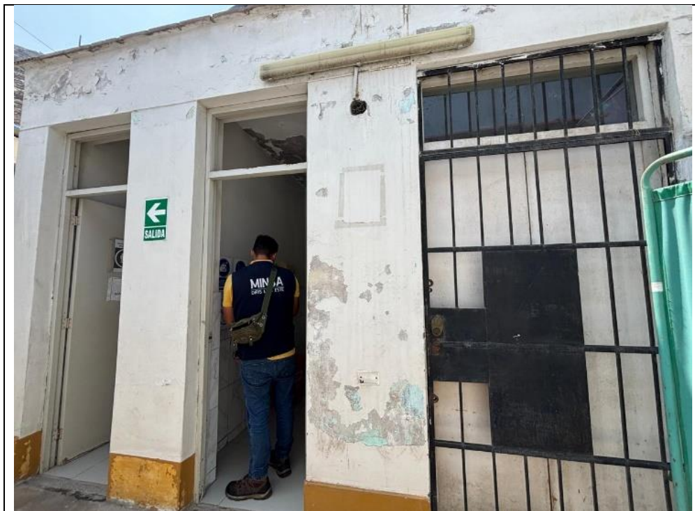
Foto 3. Se visualiza el módulo de servicios higiénicos, con la pintura en malas condiciones.
