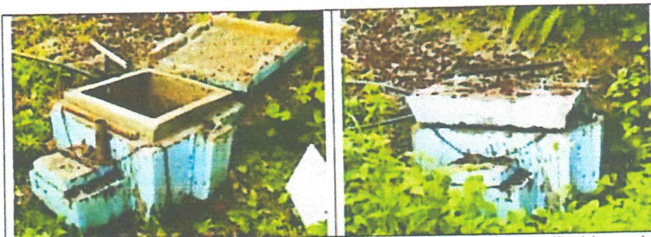
FIG N°13. Captación existente con deterioro en sus estructuras, agrietamiento y erosión del concreto, originando que el caudal se pierda por filtraciones de agua.
