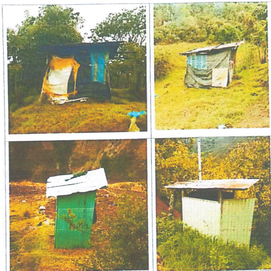
FIG N°16. Letrinas construidas de manera rustica por los pobladores, se encuentran en mal estado, sin ningún tipo de mantenimiento, las letrinas de hoyo seco han sobrepasado su capacidad. Urge su mejoramiento.
