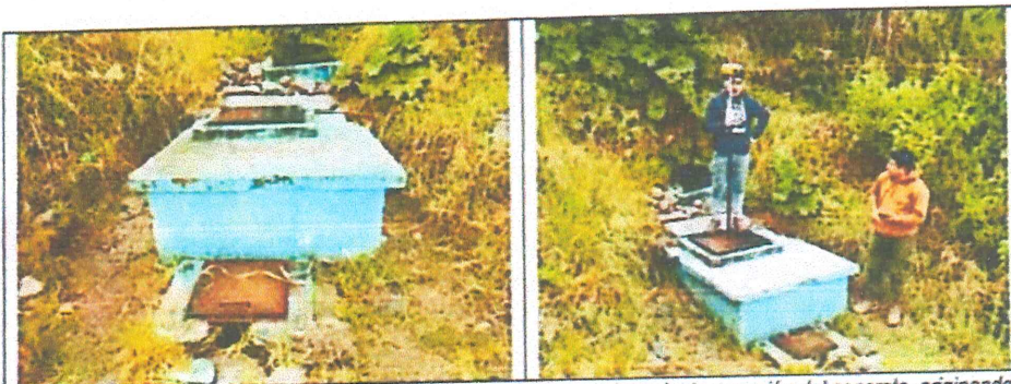
FIG N°09. Captación existente con deterioro en sus estructuras, agrietamiento y erosión del concreto, originando que el caudal se pierda por filtraciones de agua.
