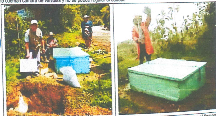
FIG N°07. Cámaras rompe presión en mal estado con tapas oxidadas y paredes erosionadas por el tiempo. Urge su mejoramiento.
