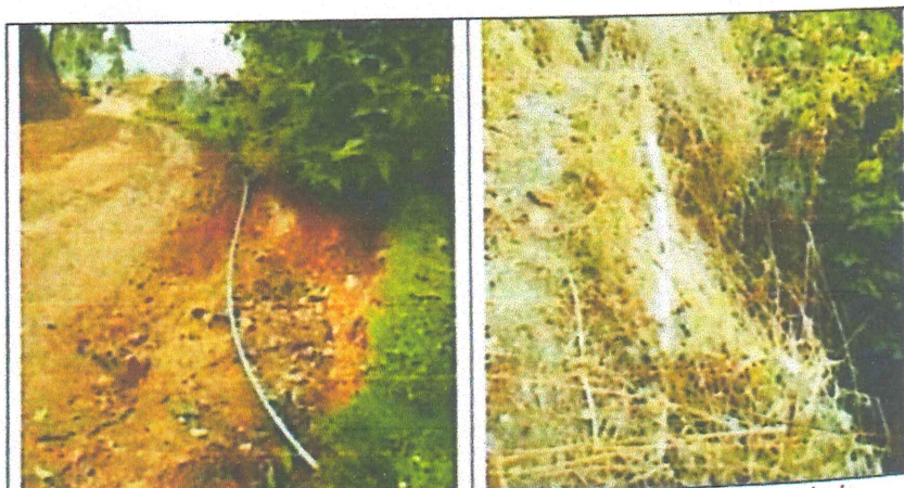
FIG N°10. Línea de conducción y red de distribución con tubería expuesta y rotura de tubería ocasionando que el caudal se pierda. Por tal motivo urge su mejoramiento.
