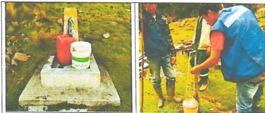
FIG N°08. Pilotas y conexiones domiciliarias en mal estado, descubiertas, rotas, con las llaves en mal estado. El agua no puede ser controlada, perjudicando para los pobladores.
