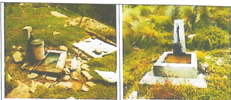
FIG N°12. Piletas y conexiones domiciliarias en mal estado, descubiertas, rotas, con las llaves en mal estado. El agua no puede ser controlada, perjudicando para los pobladores.
