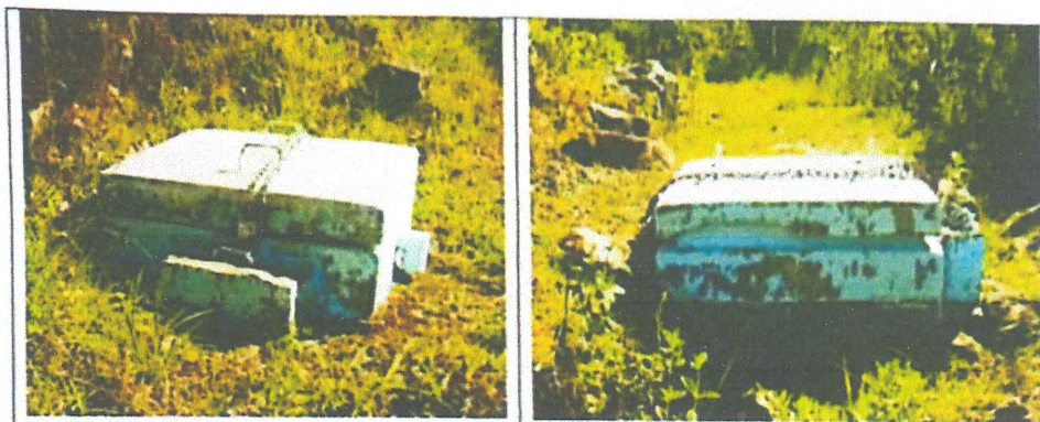
FIG N°16. Cámaras rompe presión en mal estado con tapas oxidadas y paredes erosionadas por el tiempo. Urge su mejoramiento.
