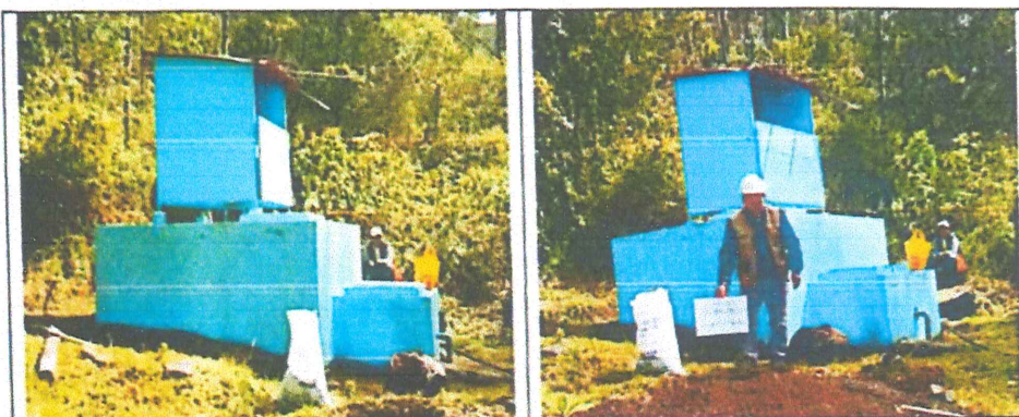
FIG N°06. Reservorio rectangular existente con deterioro en sus estructuras, presentando agrietamiento y erosión del concreto. Urge su mejoramiento.
