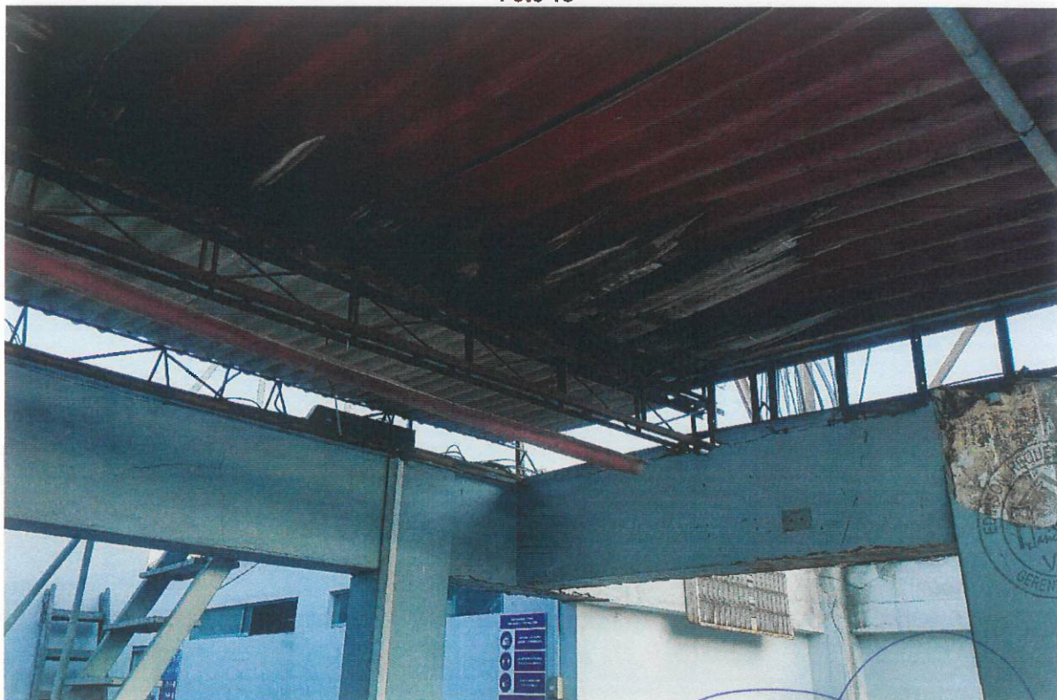
Techo ligero elaborado provisionalmente con maderas y metal.
