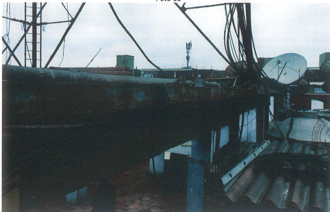
Exposición de cableado estructurado
