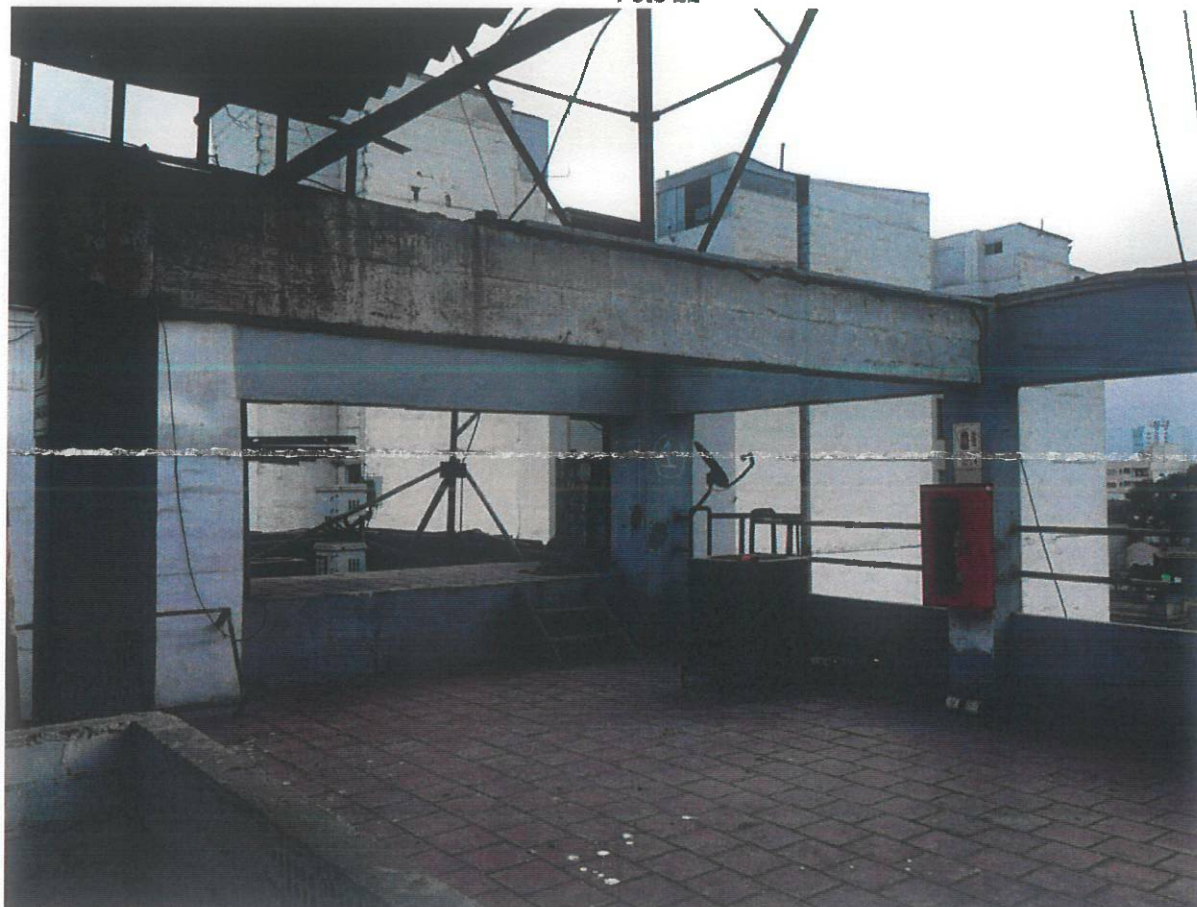
Desprendimiento de tarrajeo en caras laterales de viga
