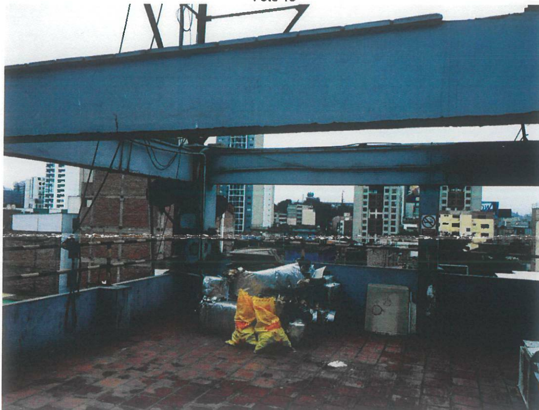
Verificación de cornisas deterioradas sobre vigas de concreto armado
