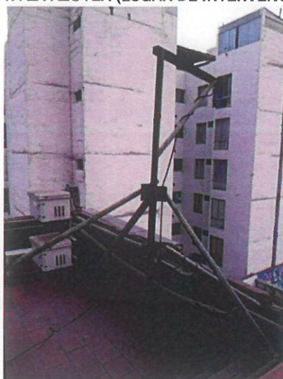
Grafico N° 14 UBICACIÓN DEL TECLE PARA EL TRANSPORTE DE MATERIALES Y HERRAMIENTAS DESDE EL PRIMER PISO HASTA LA AZOTEA (LUGAR DE INTERVENCION)
