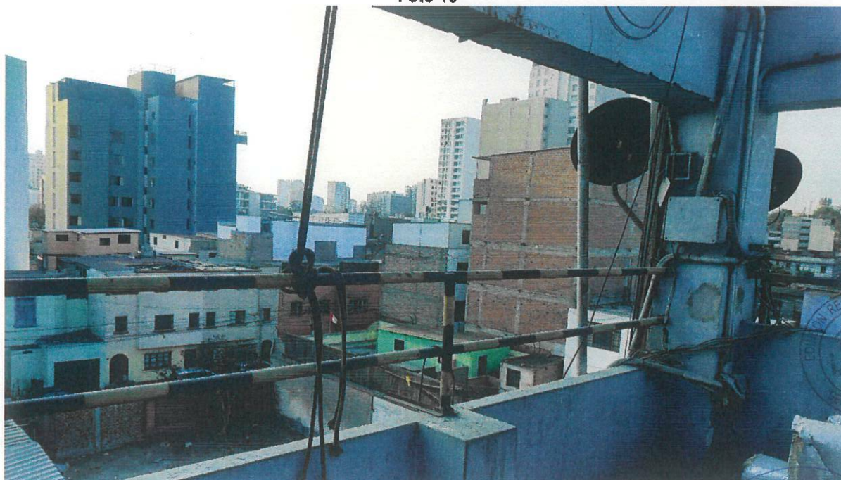
Pasamanos deteriorados que deberán ser cortados para ejecutar los trabajos.
