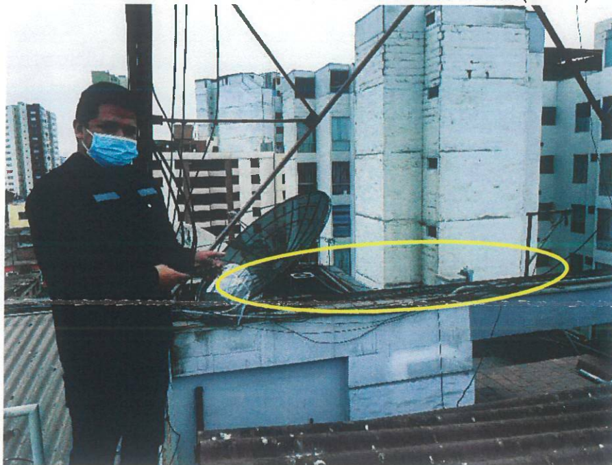
Grafico N° 09 IDENTIFICACION DE CABLES APOYADOS EN COLUMNA (CE-01)
