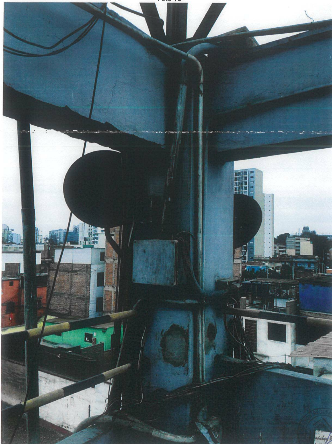
Exposición de cableado y cajas de pase
