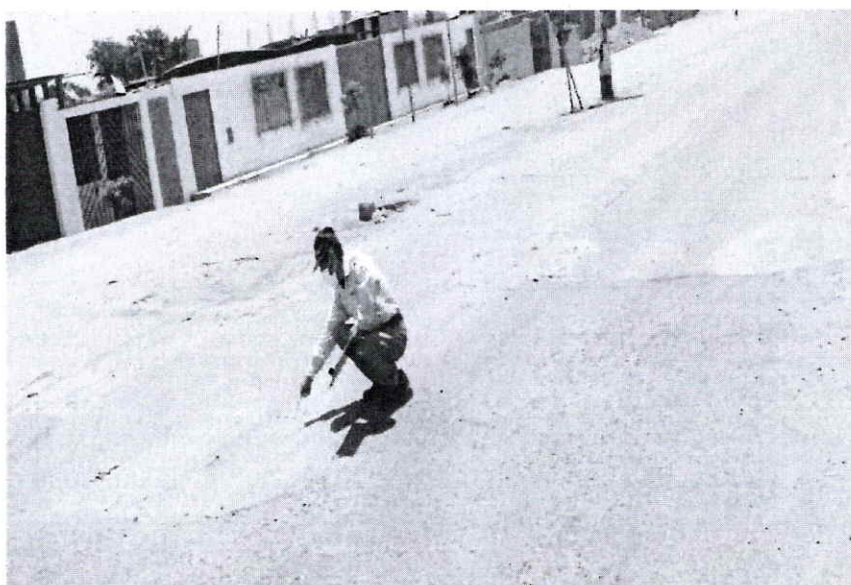
FOTO N° 12: KM.3+200 SE APRECIA PAVIMENTO ASFALTICO CON BACHES.
