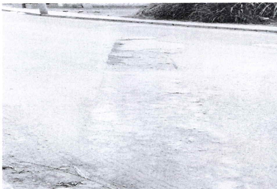
FOTO N° 16: KM. 08+365 SE APRECIA CARPETA ASFÁLTICA DETERIORADO REQUIERE TRABAJOS DE PARCHADO.
