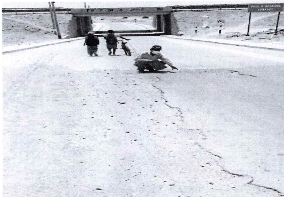
FOTO N° 15: KM. 04+300 SE APRECIA DETERIORO DE LA CALZADA NECESITA EL PARCHADO ASFALTICO.
