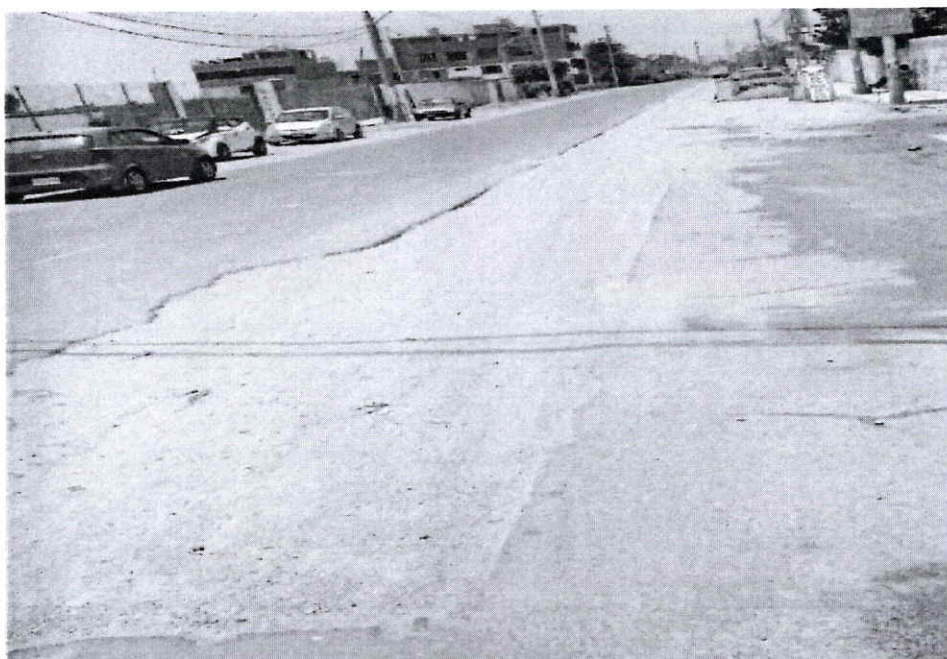
FOTO N° 05: KM.00+360 SE APRECIA CORTE LONGITUDINAL DEL PAVIMENTO ASFÁLTICO.
