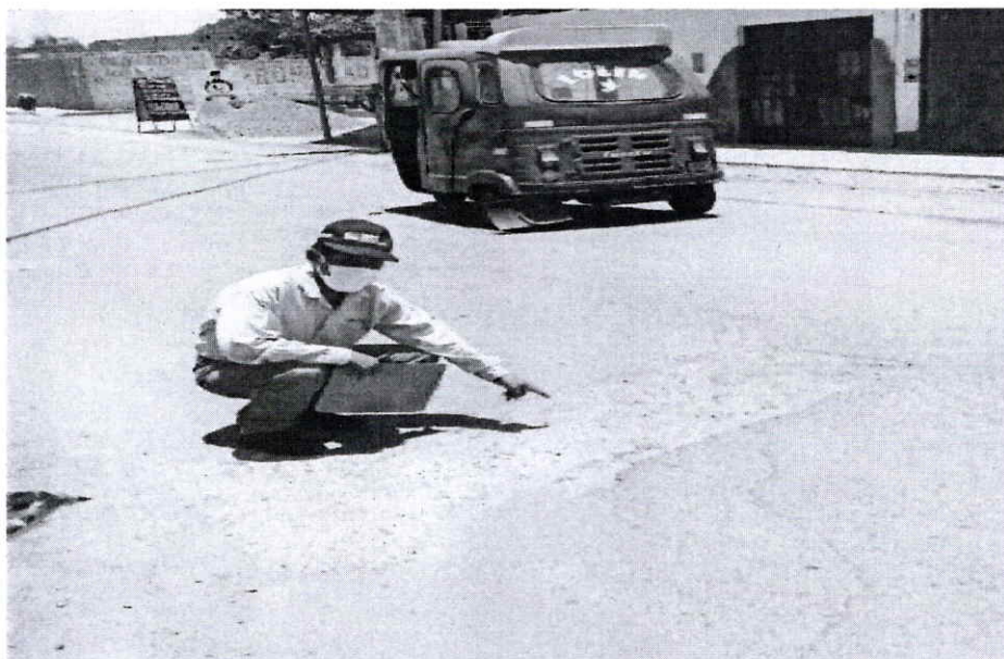
FOTO N° 06: KM. 0+902 SE APRECIA PAVIMENTO ASFÁLTICO DETERIORADO SE REQUIERE REALIZAR TRABAJOS DE LA PARCHADO SUPERFICIAL EN CALZADA.
