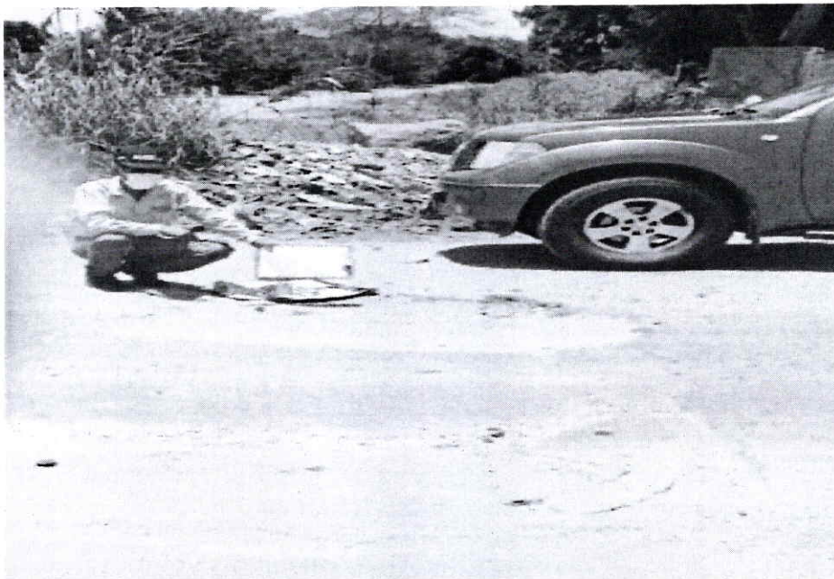
FOTO N° 13: KM. 03+325 BACHES PROFUNDOS EN SUPERFICIE ASFÁLTICA.
