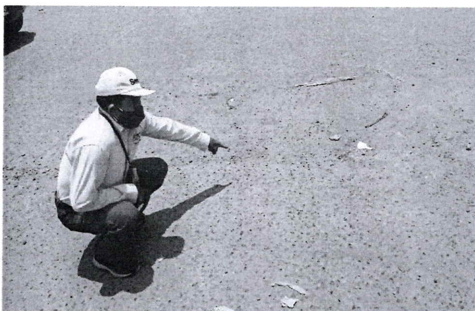
FOTO N° 20: KM. 13+380 PUNTO FINAL CARRETERA DEPARTAMENTAL IC-102 PAVIMENTO ASFALTICO DETERIORADO REQUIERE PARCHADO ASFALTICO
