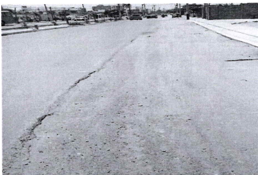
FOTO N° 08: KM. 1+815 TRAMO EN MALAS CONDICIONES NECESITA PARCHADO SUPERFICIAL EN CALZADA.
