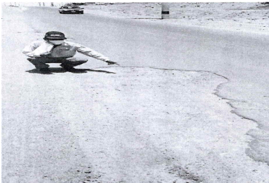
FOTO N° 14: KM. 04+150 SE APRECIA SUPERFICIE ASFÁLTICA DAÑADA NECESITA EFECTUAR EL PARCHADO ASFALTICO.
