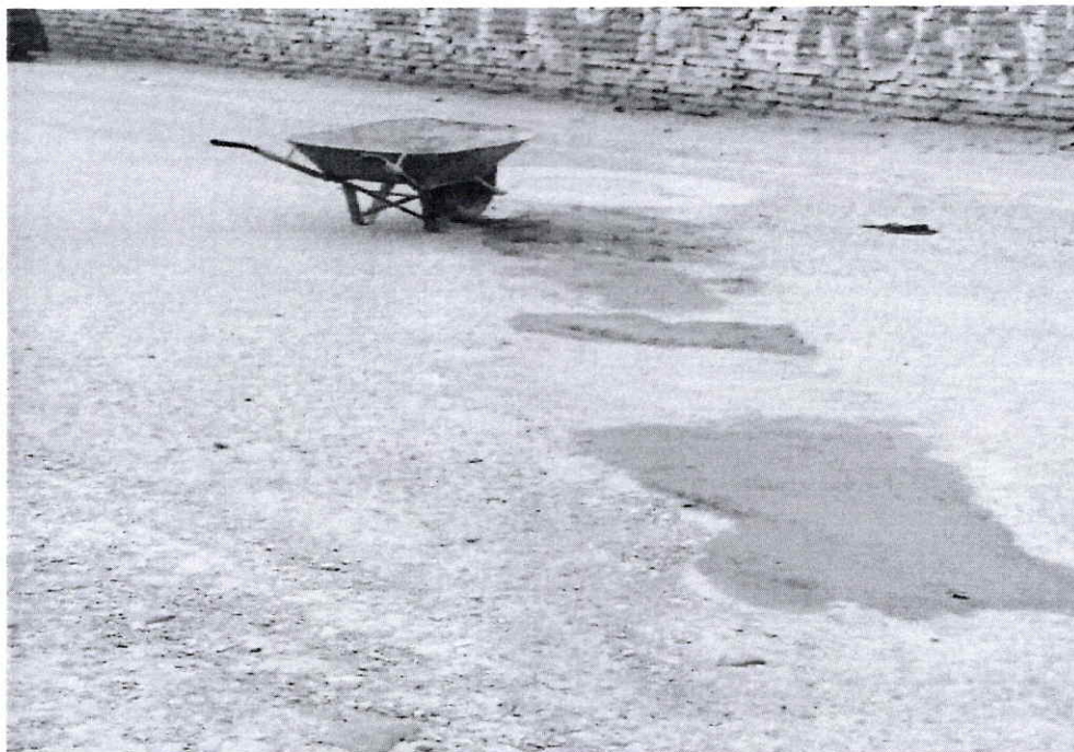
FOTO N° 17: KM. 09+420 SE APRECIA CORTE TRANSVERSAL DEL PAVIMENTO NECESITA EL PARCHADO DE LA VIA.
