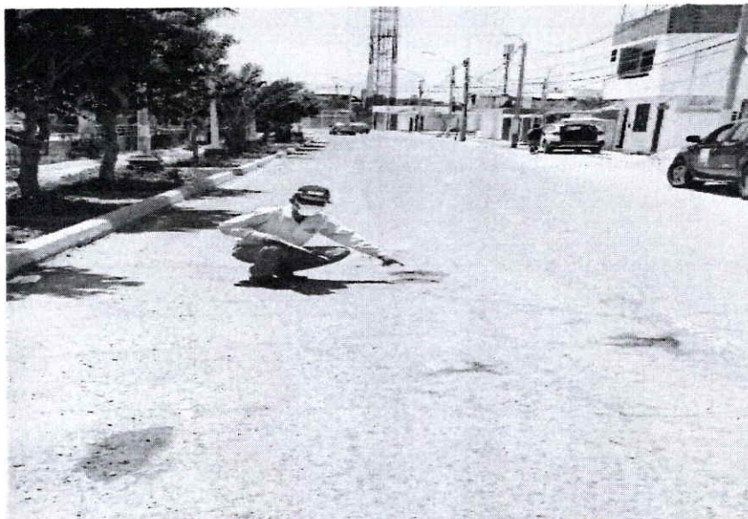
FOTO N° 09: KM. 2+240 SE APRECIA DETERIORO DE SUPERFICIE DE ASFALTO NECESITA EL PARCHADO ASFALTICO.
