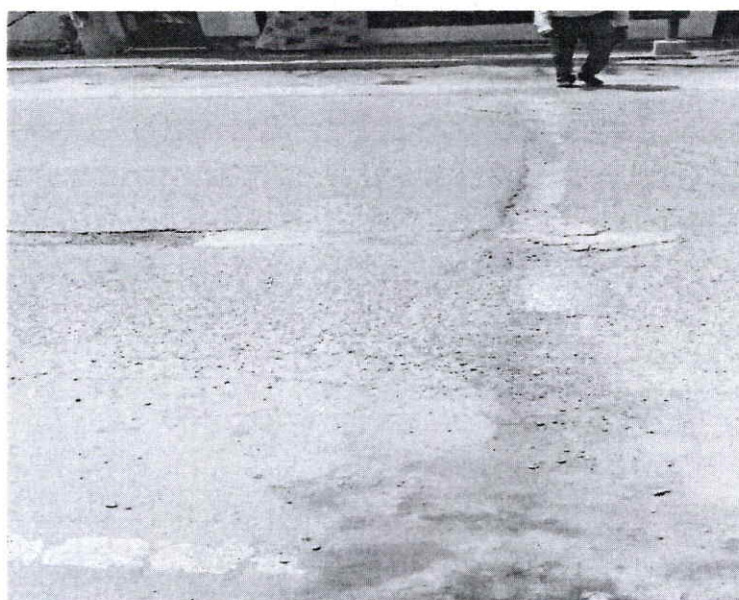
FOTO N° 02: KM. 0+120 DETERIORO DE PAVIMENTO ASFÁLTICO SE REQUIERE TRABAJOS DE PARCHADO SUPERFICIAL EN CALZADA.
