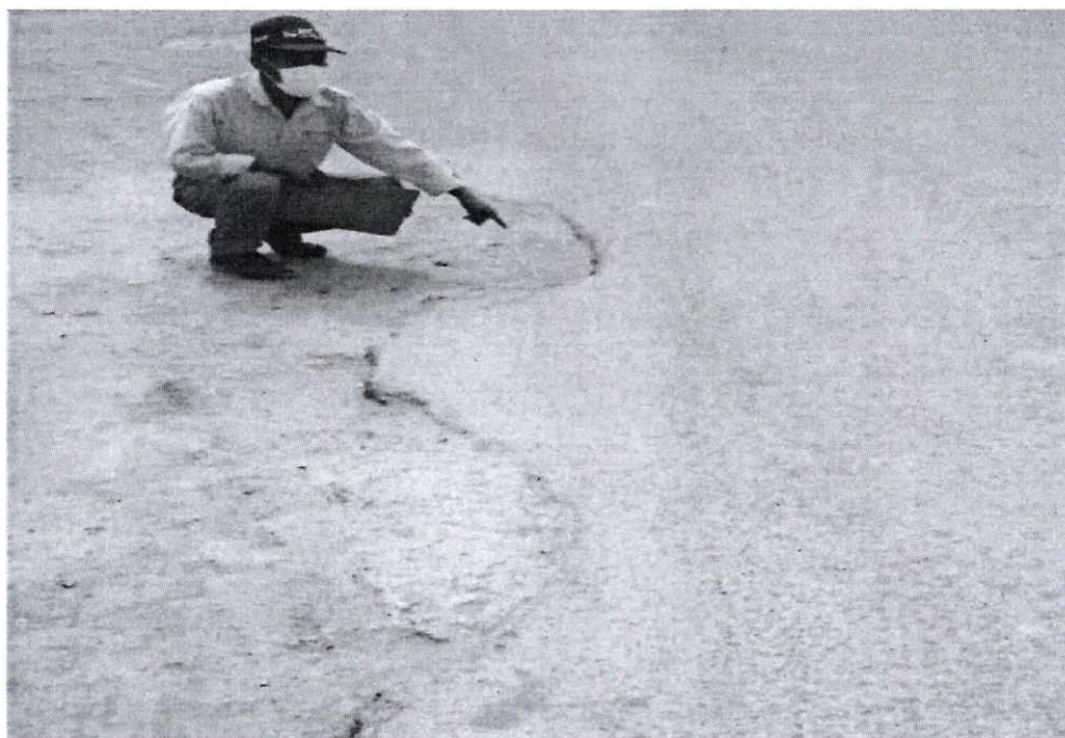
FOTO N° 18: KM. 10+300 BORDE DE LA CALZADA ASFÁLTICA DETERIORADA EFECTUAR EL PARCHADO.
