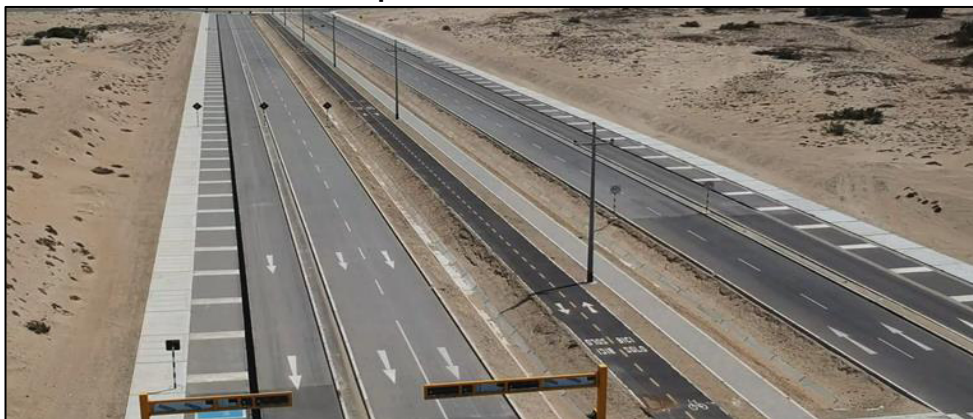
Fotografía N° 2: Vista panorámica de las cunetas de drenaje pluvial, en sentido paralelo a las vías
