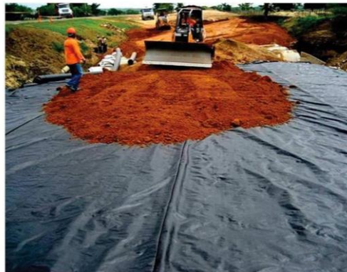
B. APLICACIÓN GEOTEXTIL NO TEJIDO DE POLIÉSTER CLASE 2
