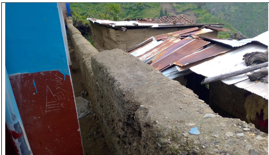
Foto N°09: Vista del cerco perimétrico (tramo de material de adobe).
