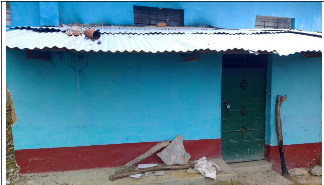
Foto N°10: Vista de la pared de la cocina de material de adobe.
