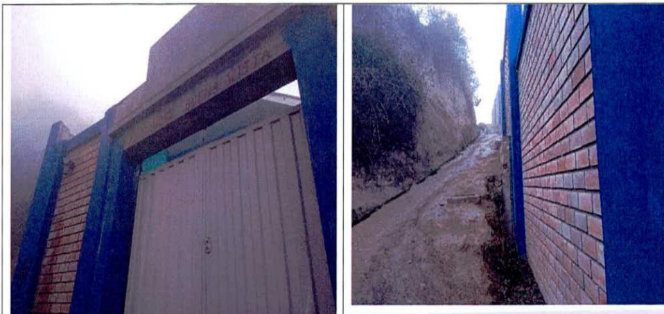
Foto N°07: Vista del cerco perimétrico (tramo de ladrillo confinado).
