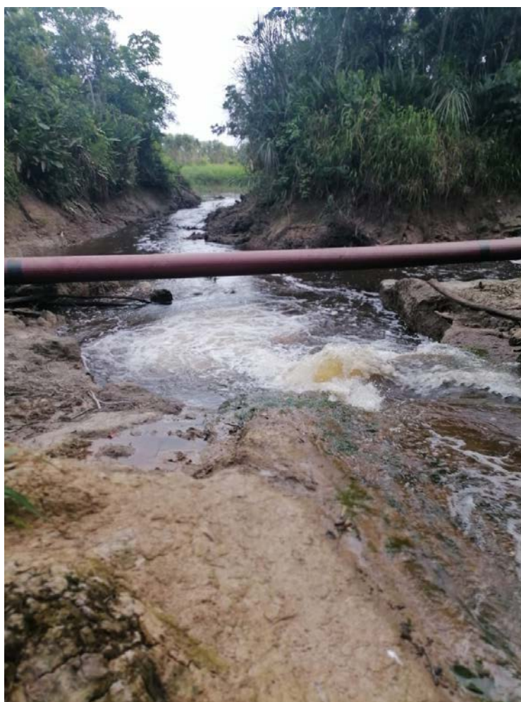
Foto N° 1.5- Determinación del estado de la tubería al 20.12.2022, luego del descenso de las aguas del río Marañón y del Canal de Flotación. El flujo de agua que se observa, corresponde al de la Qda que cruza perpendicularmente el canal de flotación y la tubería, para desembocar en el río Marañón.
