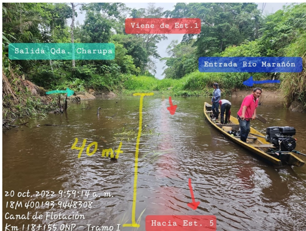
Foto N° 1.1- Sector socavado donde la tubería ha quedado expuesta 36m. Obsérvese la tubería sumergida por el alto nivel de las aguas en el canal de flotación, no obstante estar en el periodo de estiaje. Vista hacia la Estación 1, con abundante presencia de vegetación en canal de flotación, producto de la sedimentación de un tramo de aprox. 200 m. (Fecha 20.10.2022)
