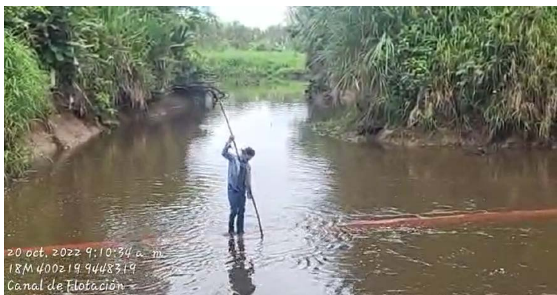
Foto 1.4 – Obsérvese el canal de salida de las aguas del canal de flotación hacia la margen izquierda del río Marañón. Cuando el río Marañón crece, por el mismo lugar ingresan sus aguas, represando las del canal de flotación. (Fecha 20.10.2022)
