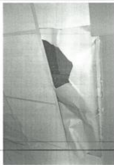
Reposición de baldosas de falso cielo raso las cuales están dañadas y en otros casos inexistentes.
