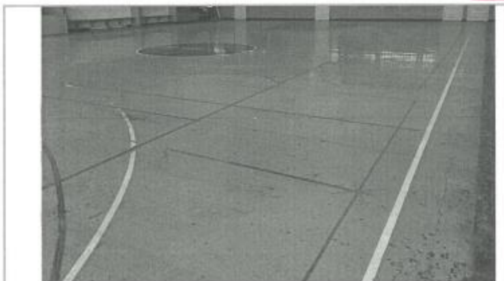
Reposición de piso deportivo existente, los cuales se encuentran deteriorados con superficie dañada.
