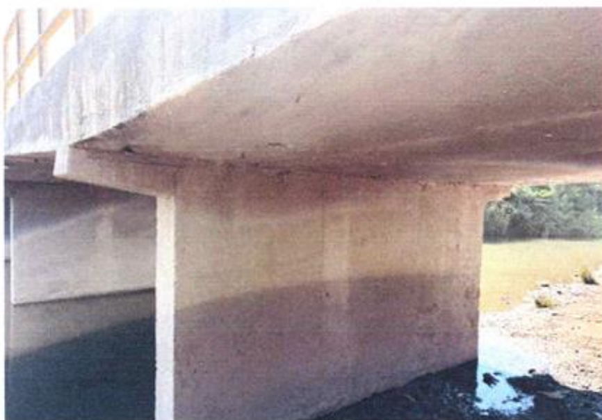
Imagen N°02.- Tiene una antigüedad de aproximadamente más de 30 años, por las condiciones actuales de deterioro e inseguridad de tránsito se requiere la intervención inmediata de renovación del puente.
