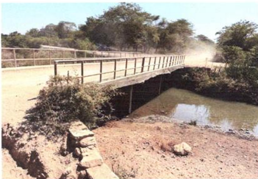
Imagen N°02.- Tiene una antigüedad de aproximadamente más de 30 años, por las condiciones actuales de deterioro e inseguridad de tránsito se requiere la intervención inmediata de renovación del puente.
