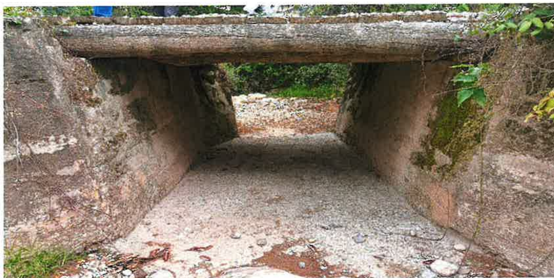
Foto 38: Alcantarilla de concreto con tableros de madera, progresiva 06+590
