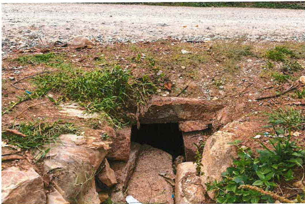
Foto 13: Pase de agua de tierra, progresiva 01+960
