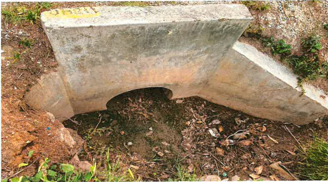
Foto 12: Alcantarilla de TMC 24", progresiva 01+840
