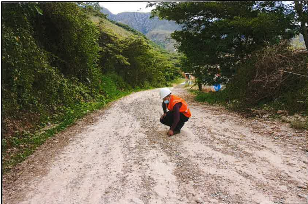
Foto 07: Ahuellamiento y erosión en el KM 04+000 (hacia adelante)
