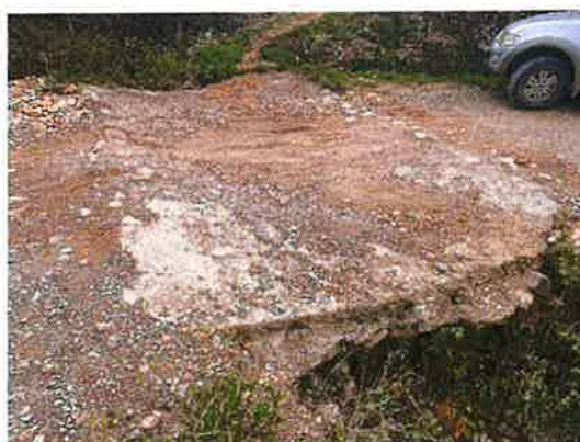
Foto 39: Baden de concreto en mal estado reconstruir, progresiva 06+745
