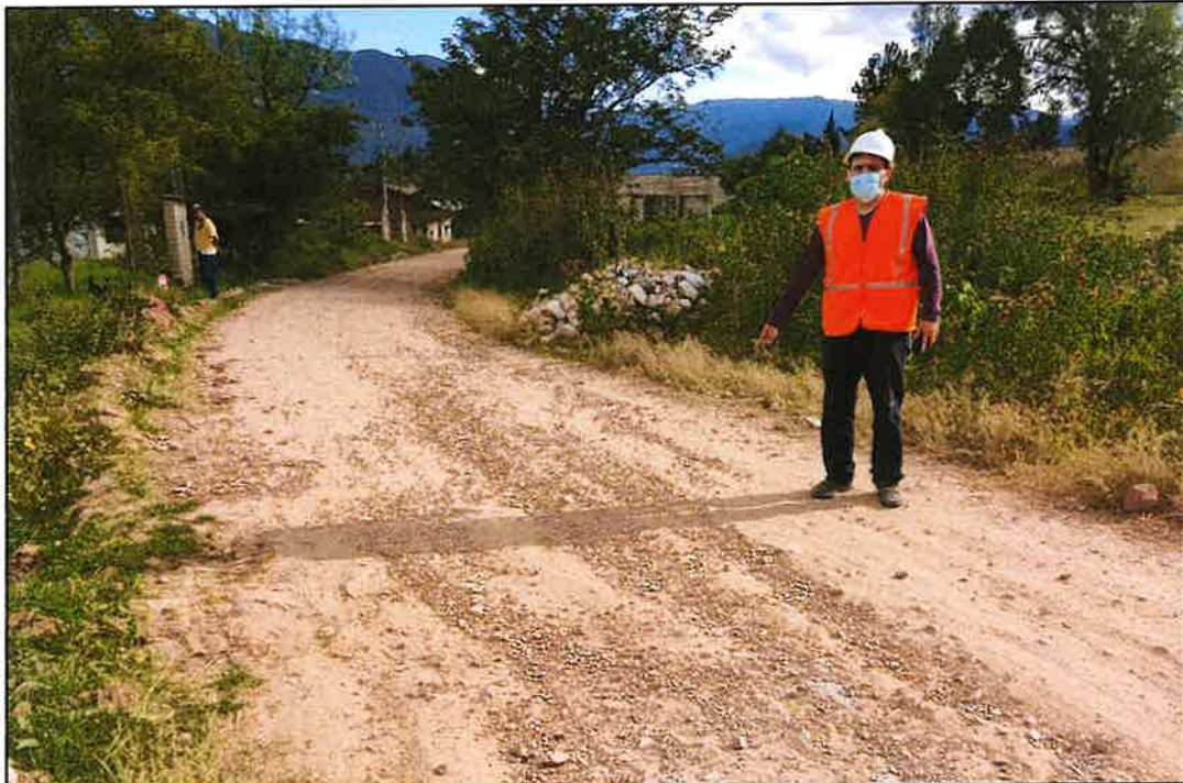
Foto 01: Ahuellamiento y erosión en el KM 01+000 (hacia adelante).
