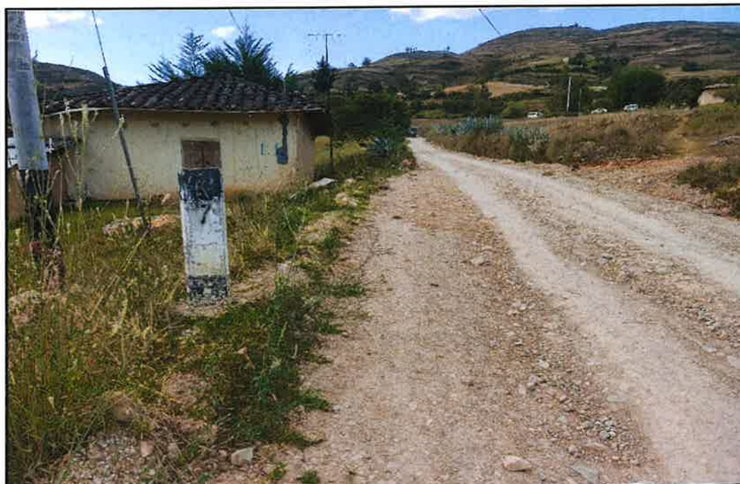
Foto 13: Capa de afirmado muy fina en el KM 07+000 (hacia delante)
