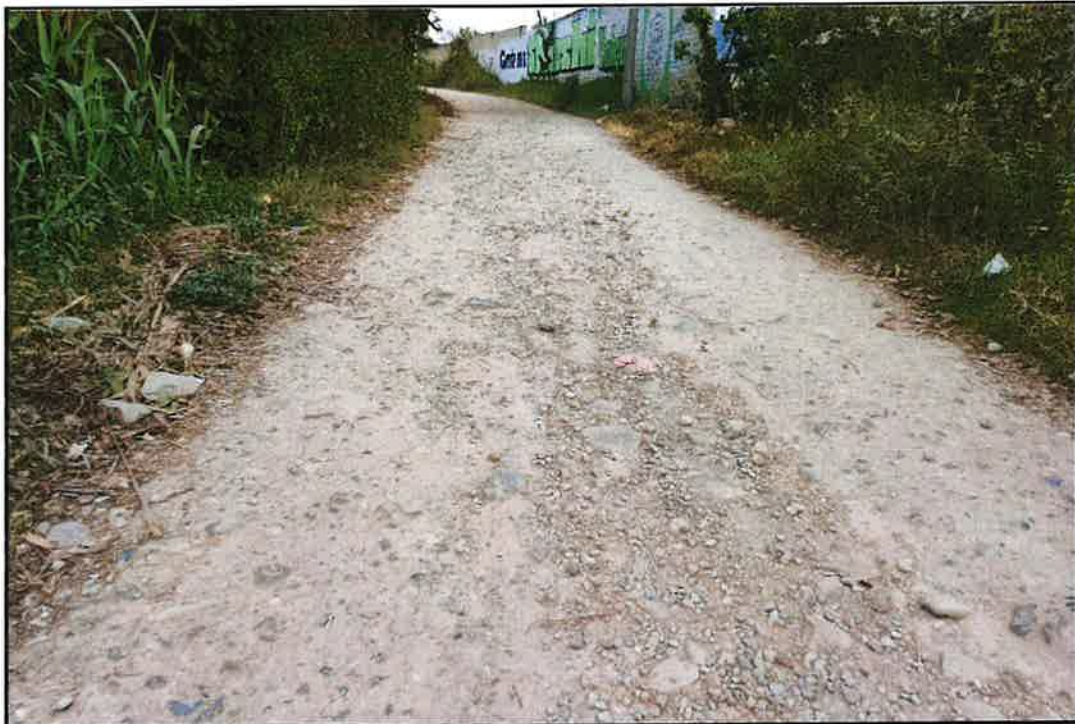
Foto 09: Ahuellamiento y erosión en el KM 05+000 (hacia adelante)
