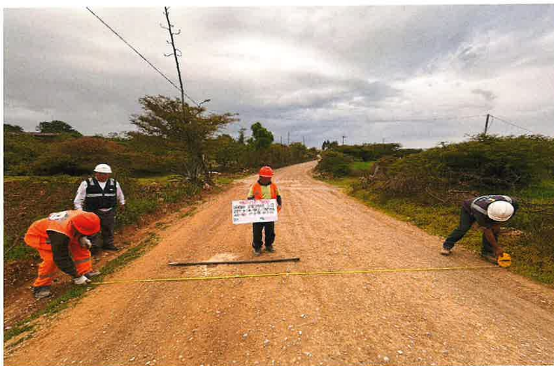
Foto 20: Medidas en la superficie de rodadura, progresiva 04+750
