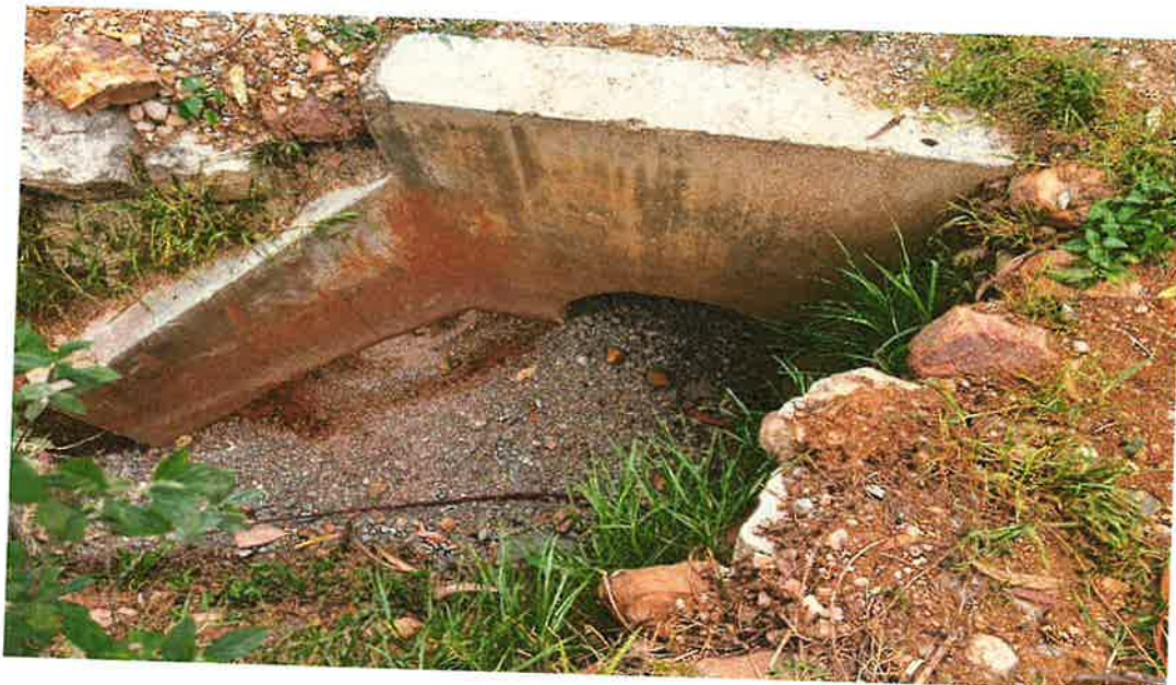
Foto 14: Alcantarilla de TMC 24", progresiva 02+185
