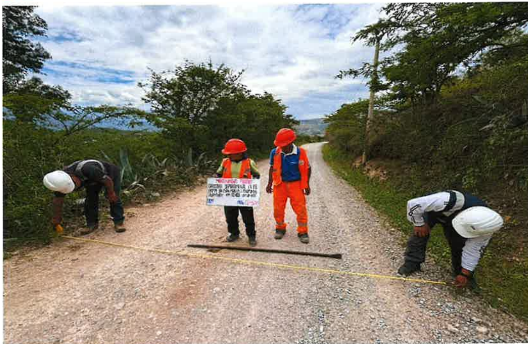
Foto 11: Medidas en la superficie de rodadura, progresiva 02+500
