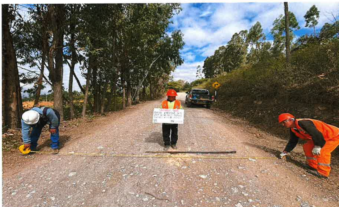
Foto 23: Medidas en la superficie de rodadura, progresiva 05+500
