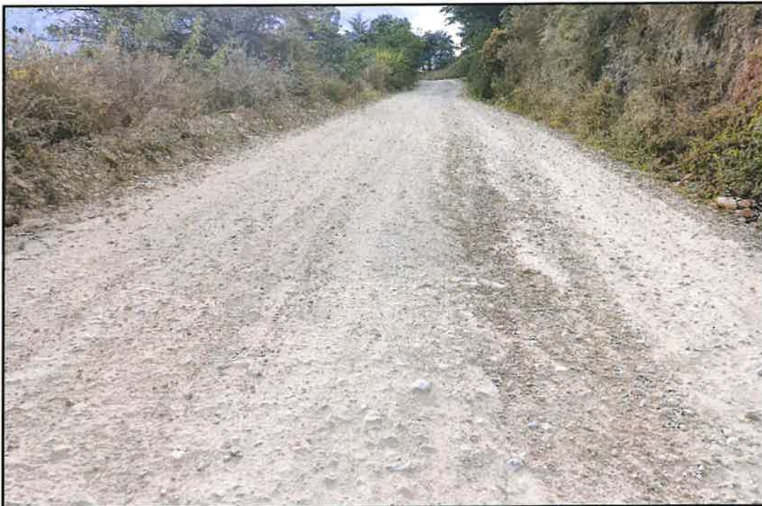
Foto 08: Ahuellamiento y erosión en el KM 04+000 (hacia atrás)
