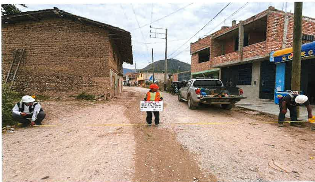
Foto N° 3: Medidas en la superficie de rodadura, progresiva 00+500
