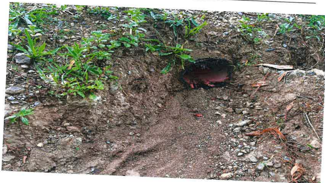
Foto 24: Pase de agua con tubo de PVC 6", progresiva 04+170
