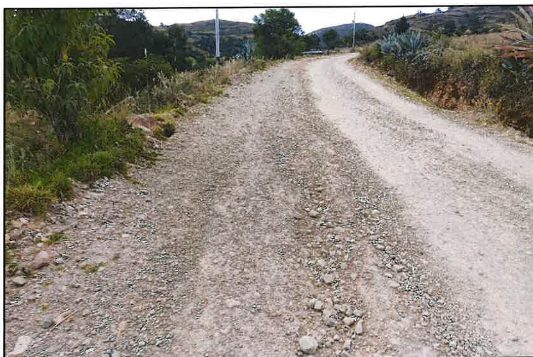
Foto 14: Capa de afirmado muy fina en el KM 07+000 (hacia atrás)
