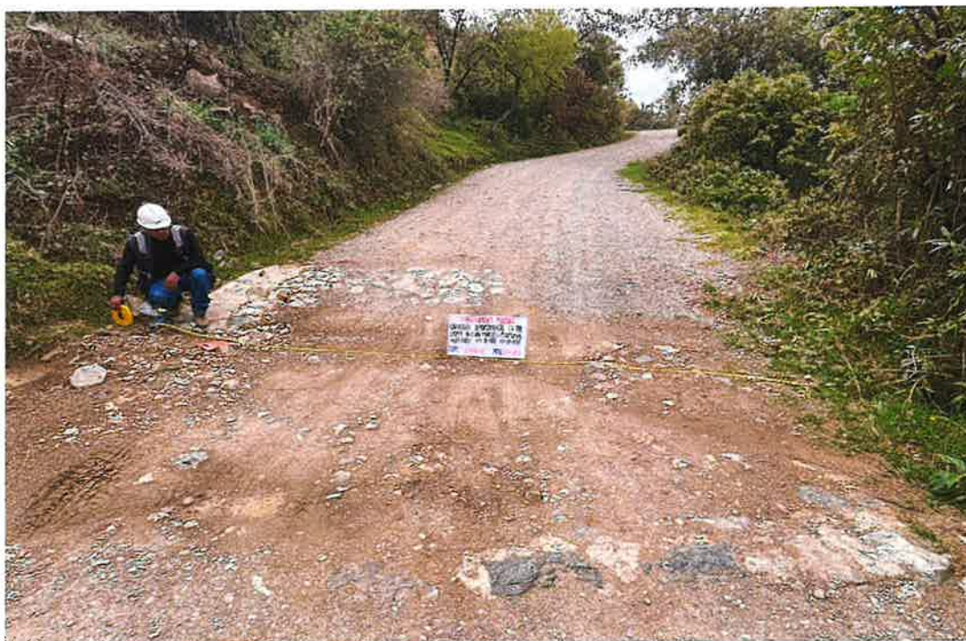
Foto 43: Baden de concreto en mal estado para reparación, progresiva 07+705
