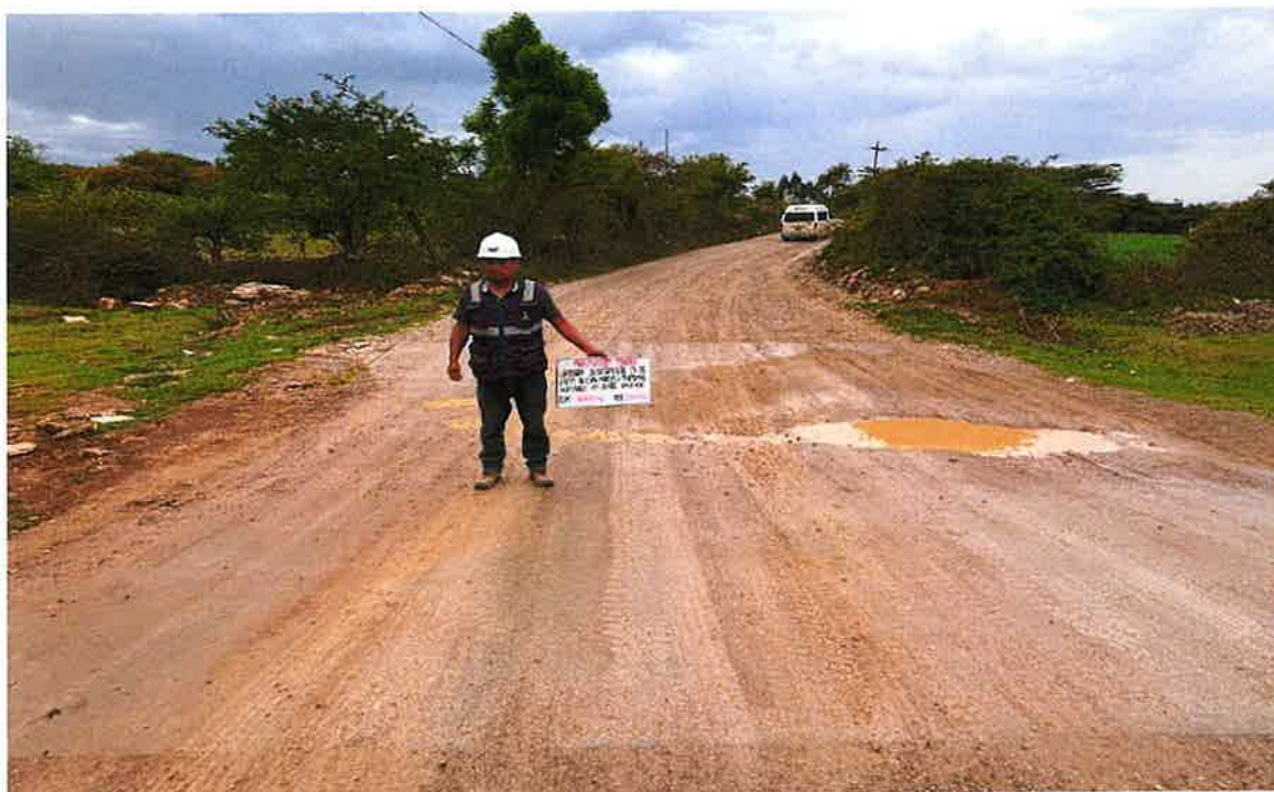
Foto 26: Baden de concreto en mal estado para reconstruir, progresiva 04+740
