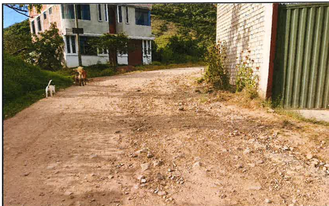
Foto 03: Ahuellamiento y erosión en el KM 02+000 (hacia delante)
