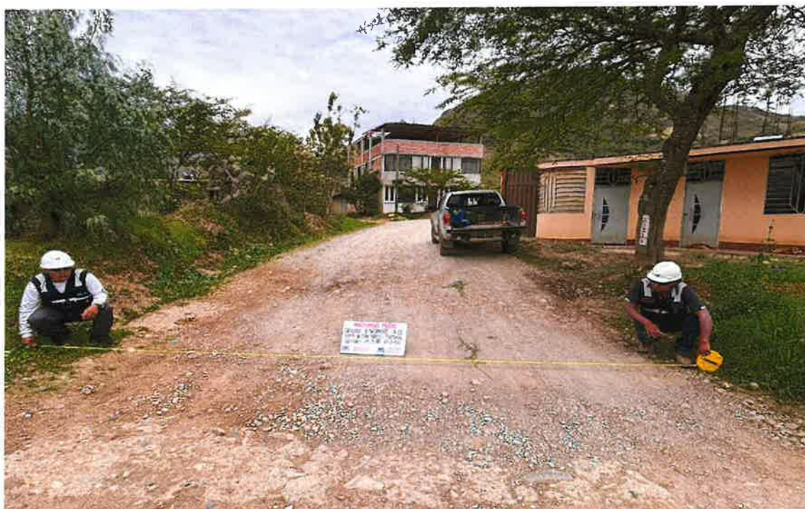
Foto 6: Baden de concreto en mal estado, para reconstruir, progresiva 01+210
