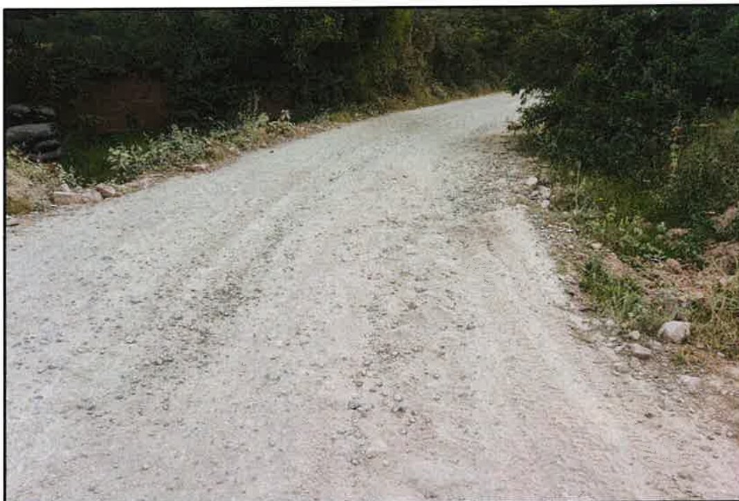
Foto 11: Ahuellamiento en el KM 06+000 (hacia delante).
