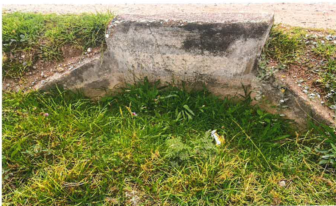
Foto 37: Alcantarilla TMC DE 24", progresiva 06+470
