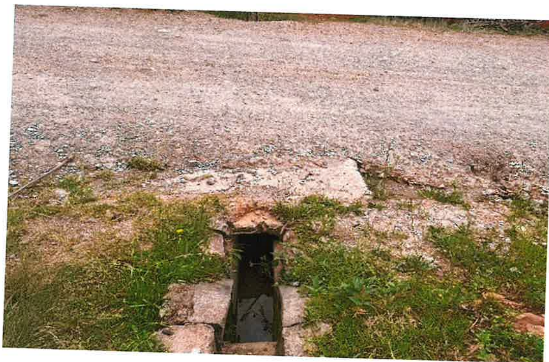
Foto 15: Pase de agua de concreto, progresiva 02+240
