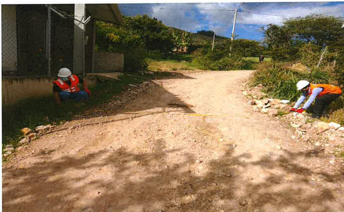
Foto N°3: Ahuellamiento y Erosiones, Progresiva 01+510 a la 02+890.
