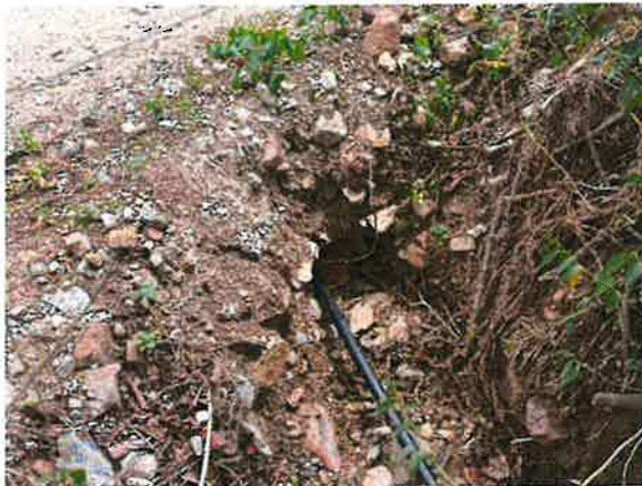
Foto 8: Pase de agua, tubo de PVC 6", progresiva 01+490
