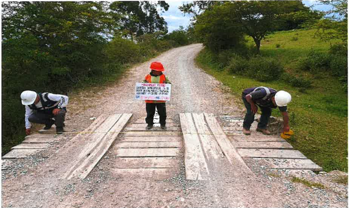
Foto 18: Alcantarilla de concreto y tablero de madera, progresiva 02+860
