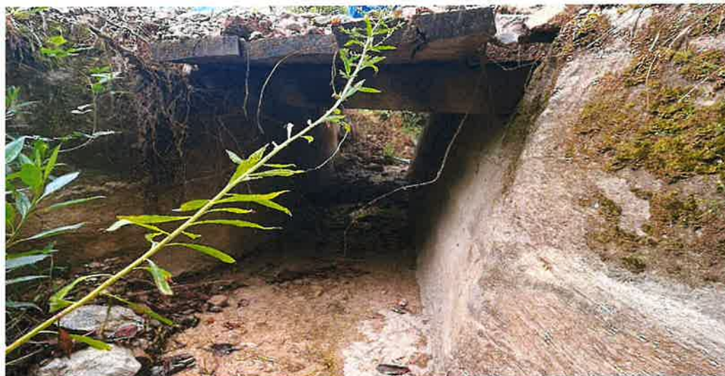
Foto 40: Alcantarilla de concreto con plataforma de madera, progresiva 07+445
