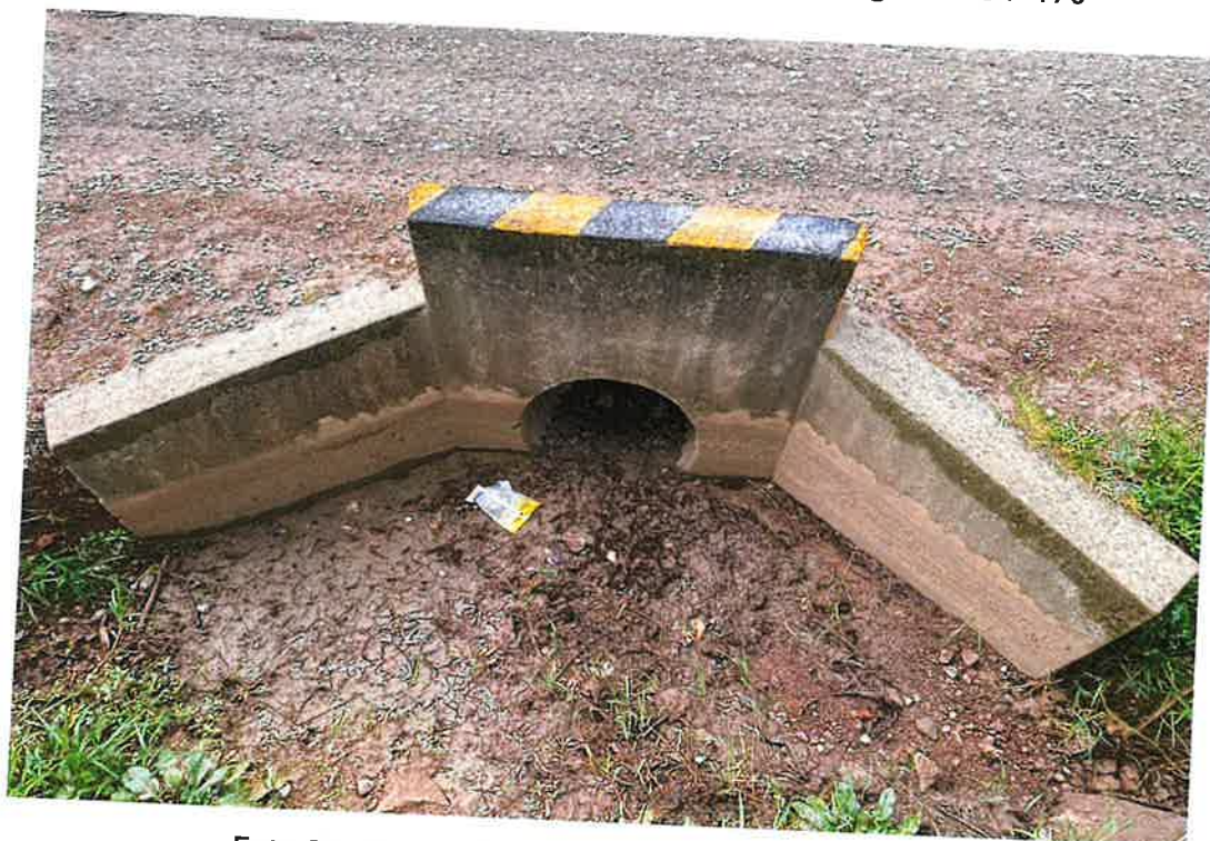
Foto 25: Alcantarilla de TMC 24", progresiva 04+505
