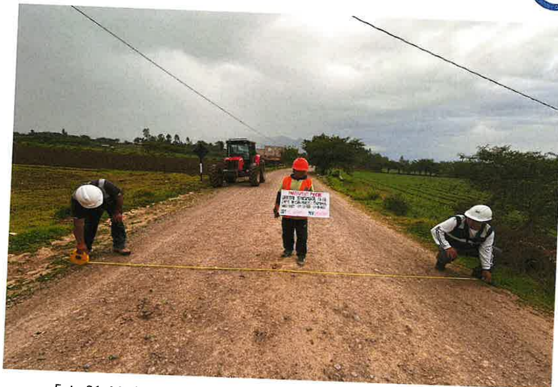
Foto 21: Medidas en la superficie de rodadura, progresiva 05+000-hito
