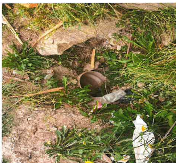
Foto 4: Pase de agua, tubo de PVC 12" progresiva 00+725
