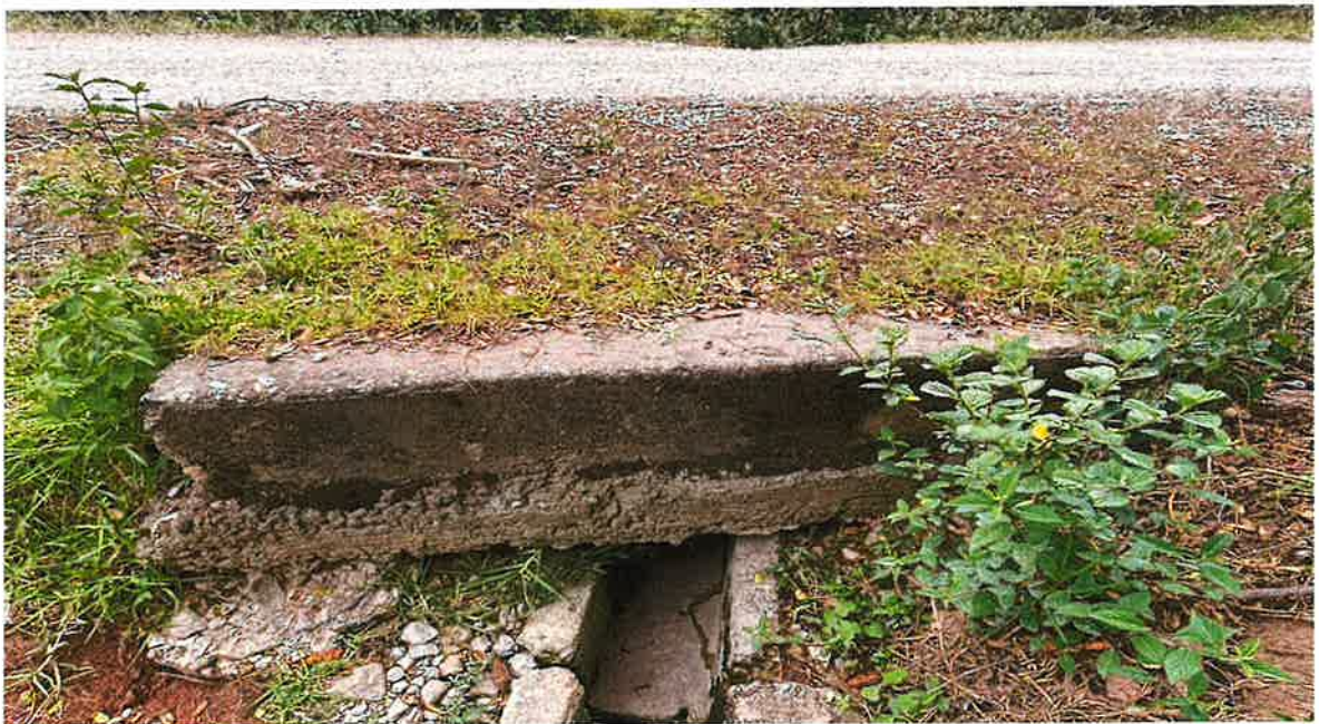
Foto 19: Pase de agua de concreto, progresiva 02+985
