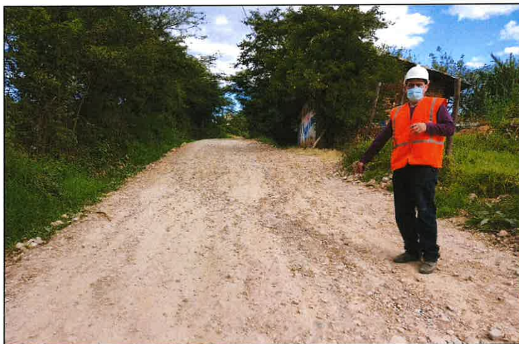
Foto 05: Ahuellamiento y erosión en el KM 03+000 (hacia adelante)
