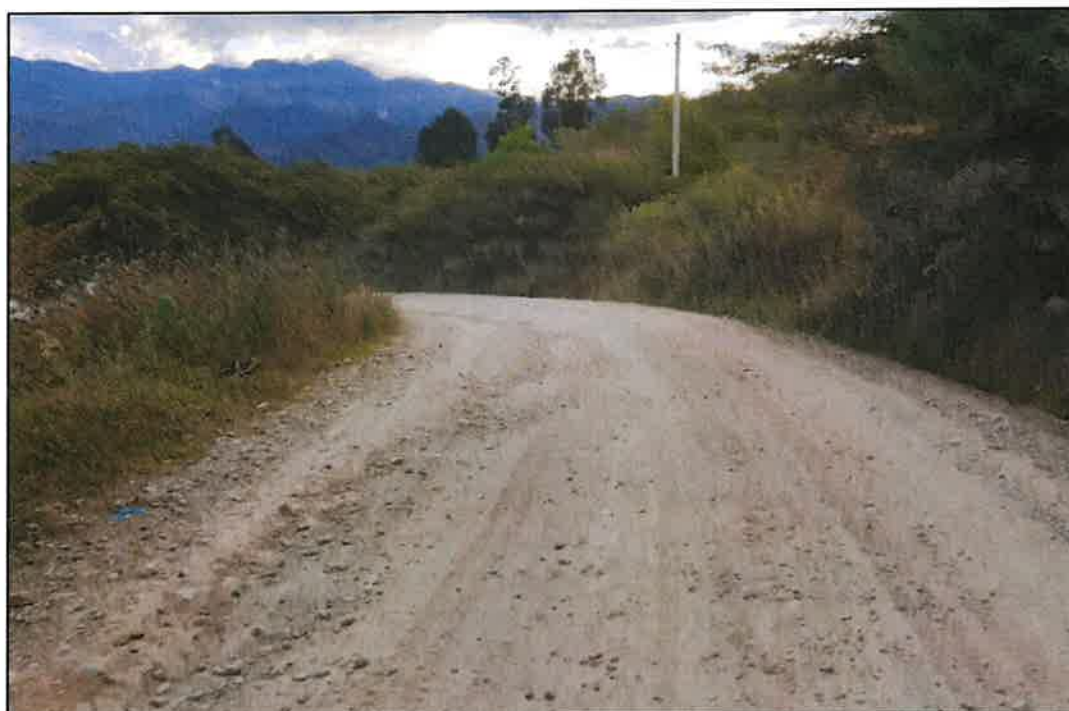
Foto 06: Ahuellamiento y erosión en el KM 03+000 (hacia atrás)
