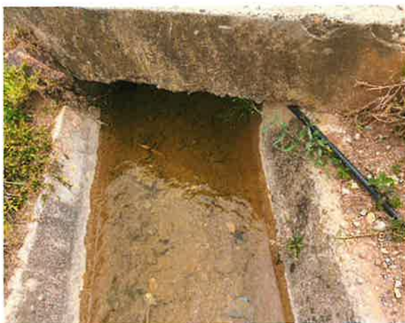
Foto 5: Alcantarilla, Canal trapezoidal, progresiva 01+200
