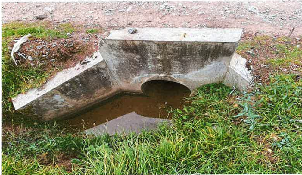
Foto 32: Alcantarilla de TMC 24", progresiva 05+970
