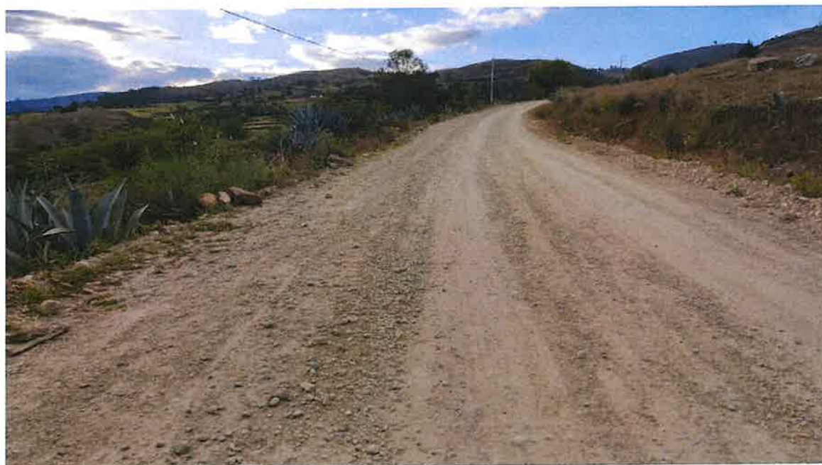
Foto N°10: Ahuellamiento, Progresiva 05+900 a la 06+500.
