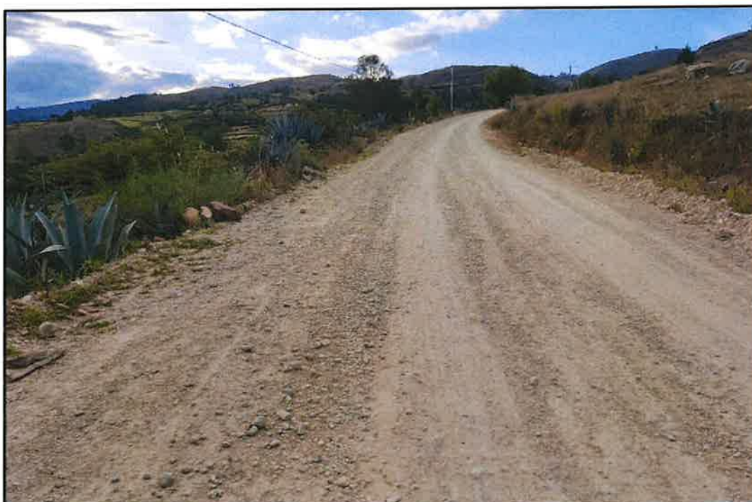
Foto 12: Ahuellamiento en el KM 06+000 (hacia atrás)
