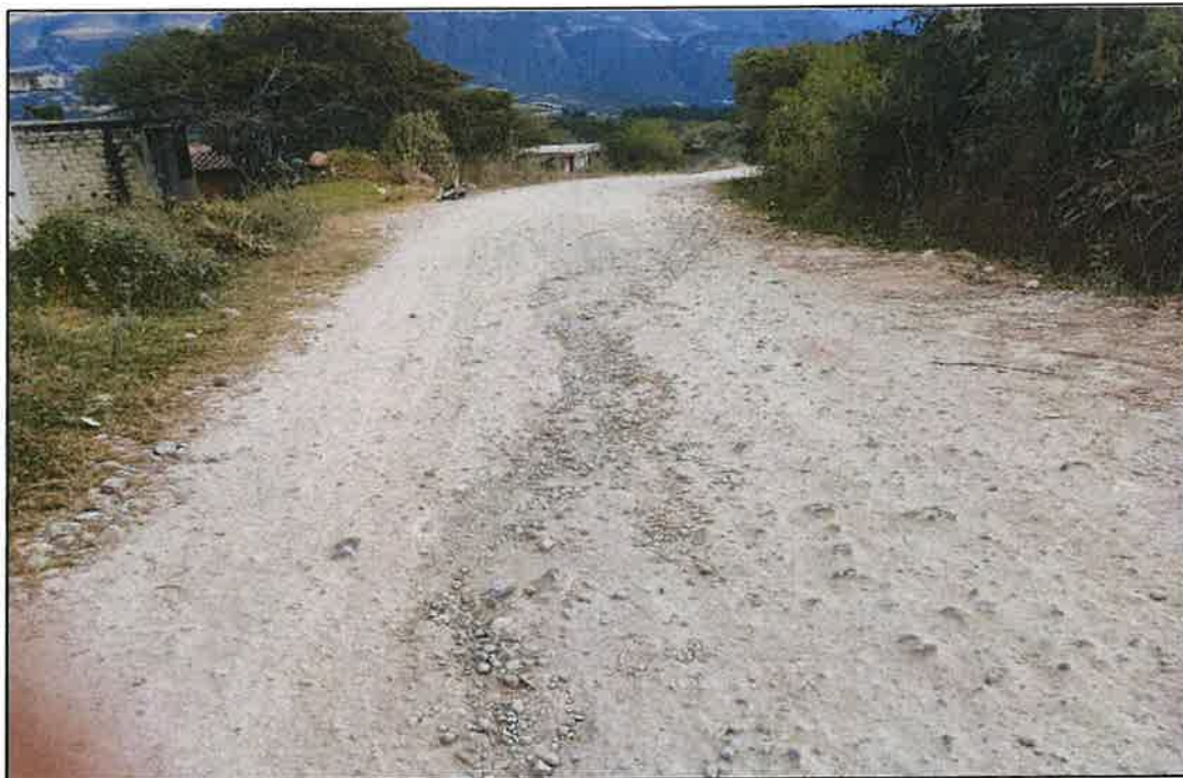
Foto 10: Ahuellamiento y erosión en el KM 05+000(hacia atrás)
