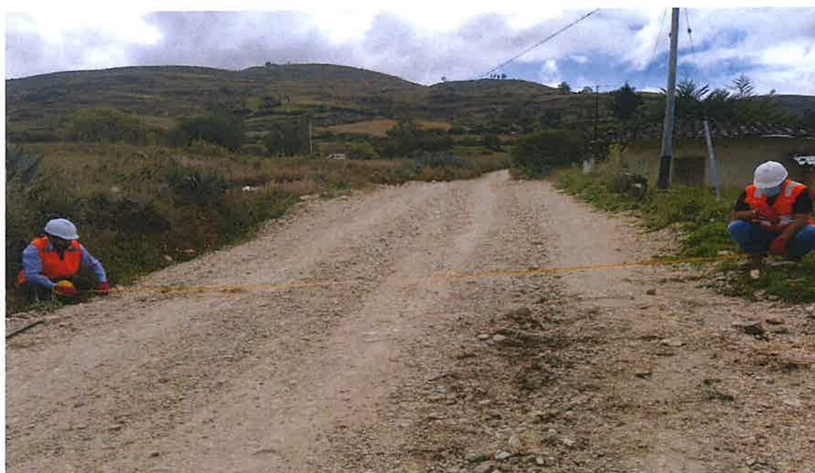
Foto N°6: Ahuellamiento, Progresiva 03+250 a la 04+370.
