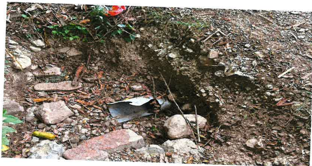
Foto 10: Pase de agua, tubo de PVC 6", progresiva 01+715
