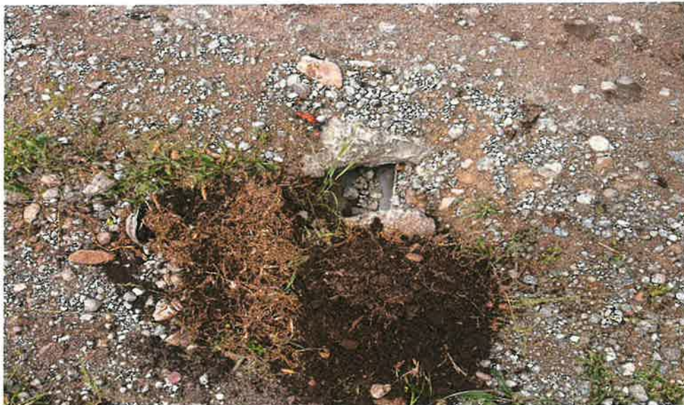
Foto 33: Pase de agua tubo de PVC 8", progresiva 06+140
