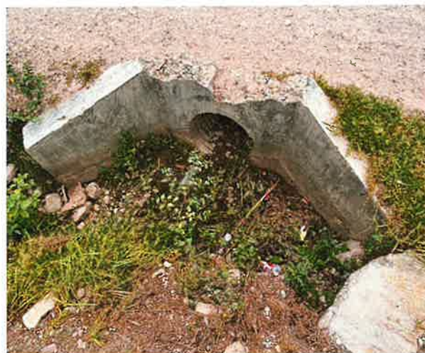
Foto 3: Alcantarilla de TMC 24", progresiva 00+680
