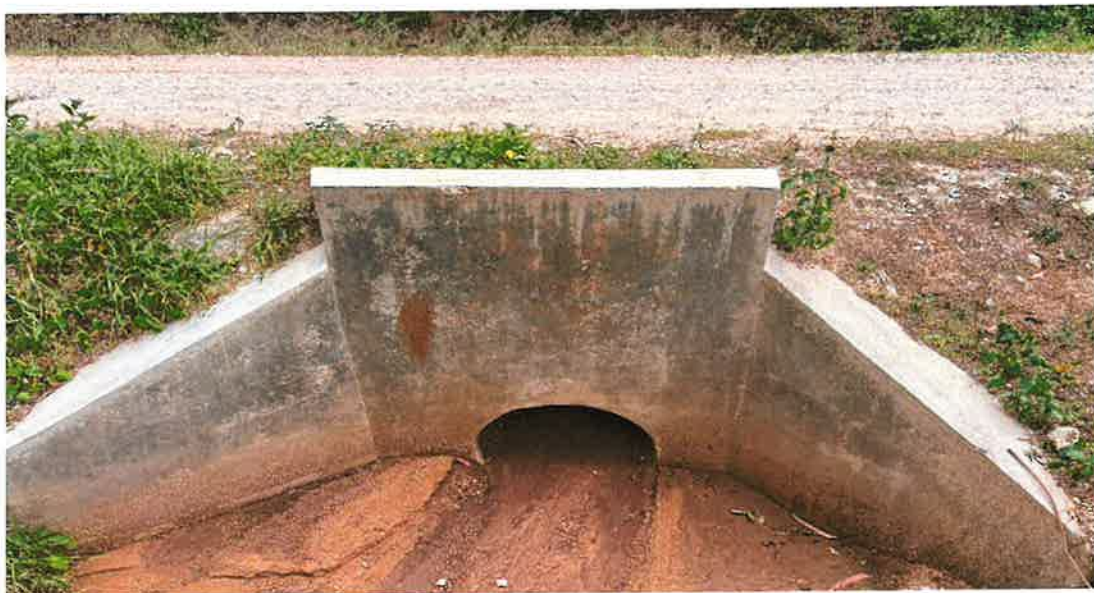
Foto 17: Alcantarilla de TMC 24", progresiva 02+700
