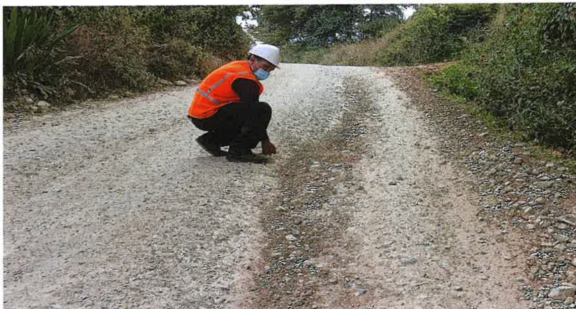
Foto N°5: Ahuellamiento, Progresiva 03+010 a la 03+250.
