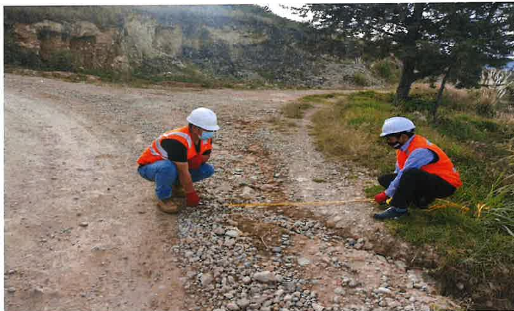
Foto N°1: Ahuellamiento y Erosiones, Progresiva 00+000 a la 01+500.
