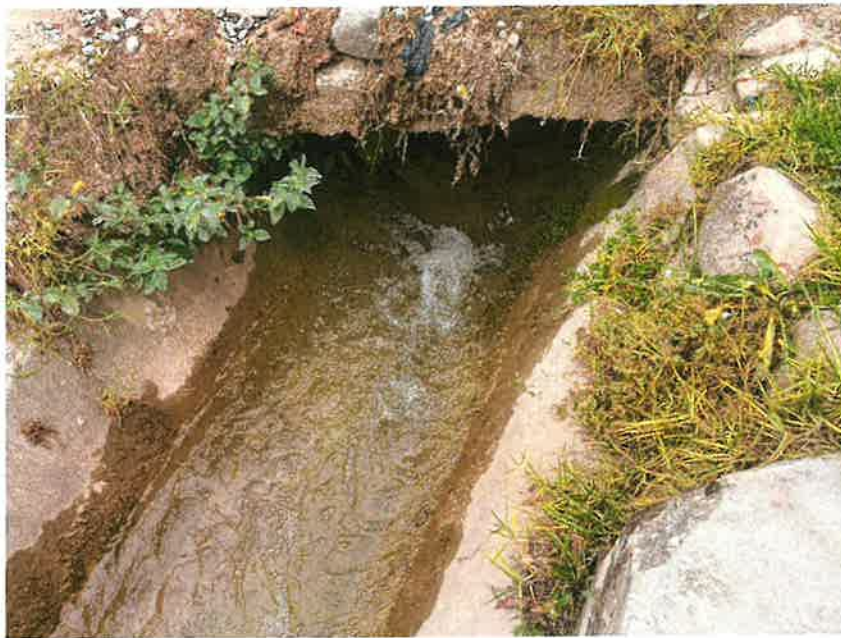
Foto N° 2: Alcantarilla-canal trapezoidal de concreto, progresiva 00+390
