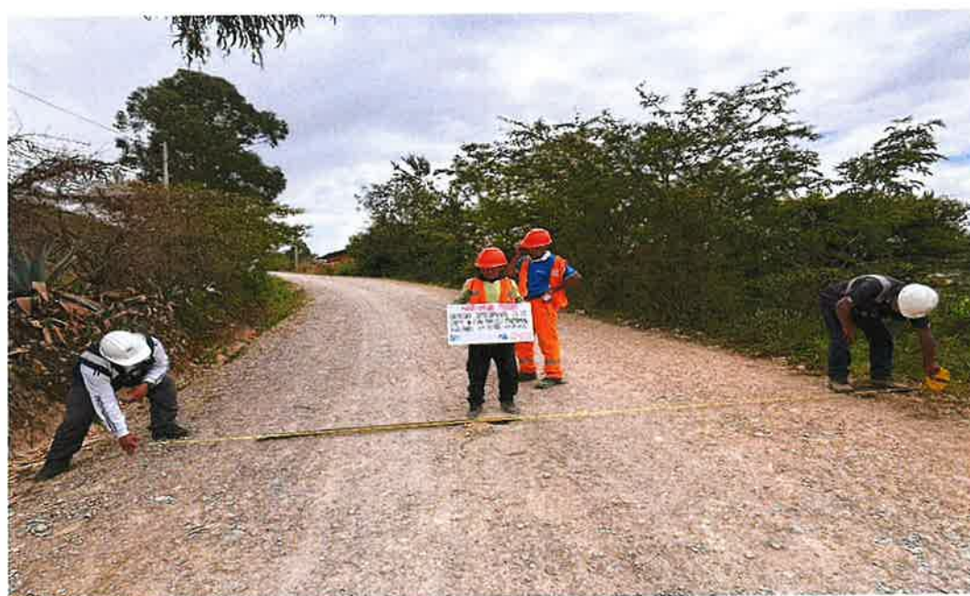
Foto 9: Medidas en la superficie de rodadura, progresiva 02+250
