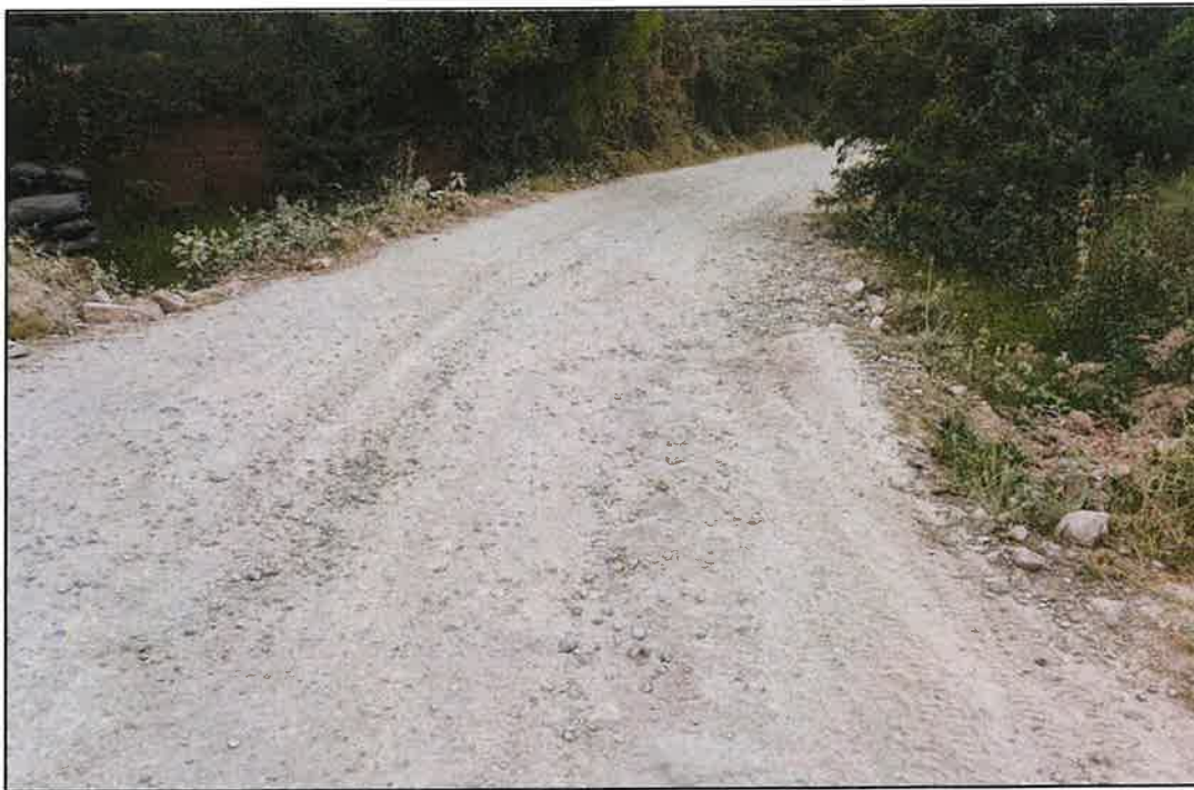
Foto 02: Ahuellamiento y erosión en el KM 01+000 (hacia atrás).
