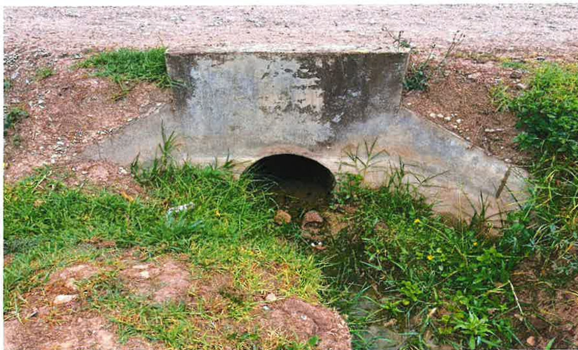
Foto 27: Alcantarilla de TMC 24", progresiva 04+910
