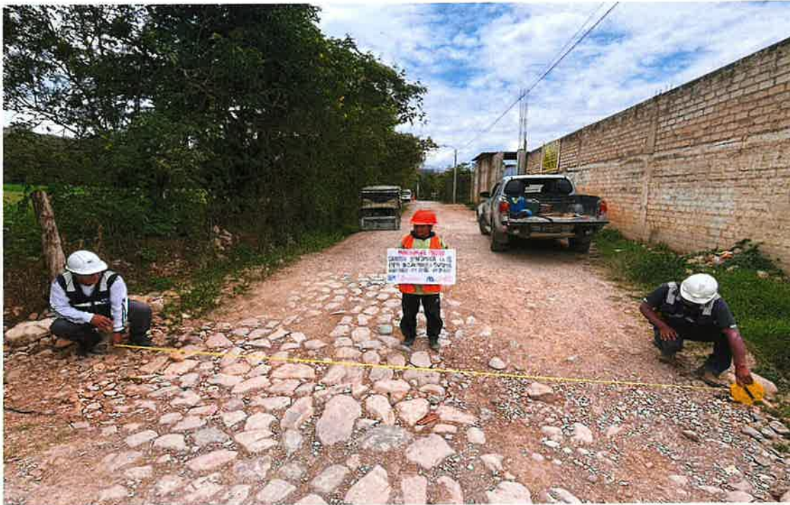
Foto 9: Baden de piedra en mal estado para reconstruir, progresiva 01+615
