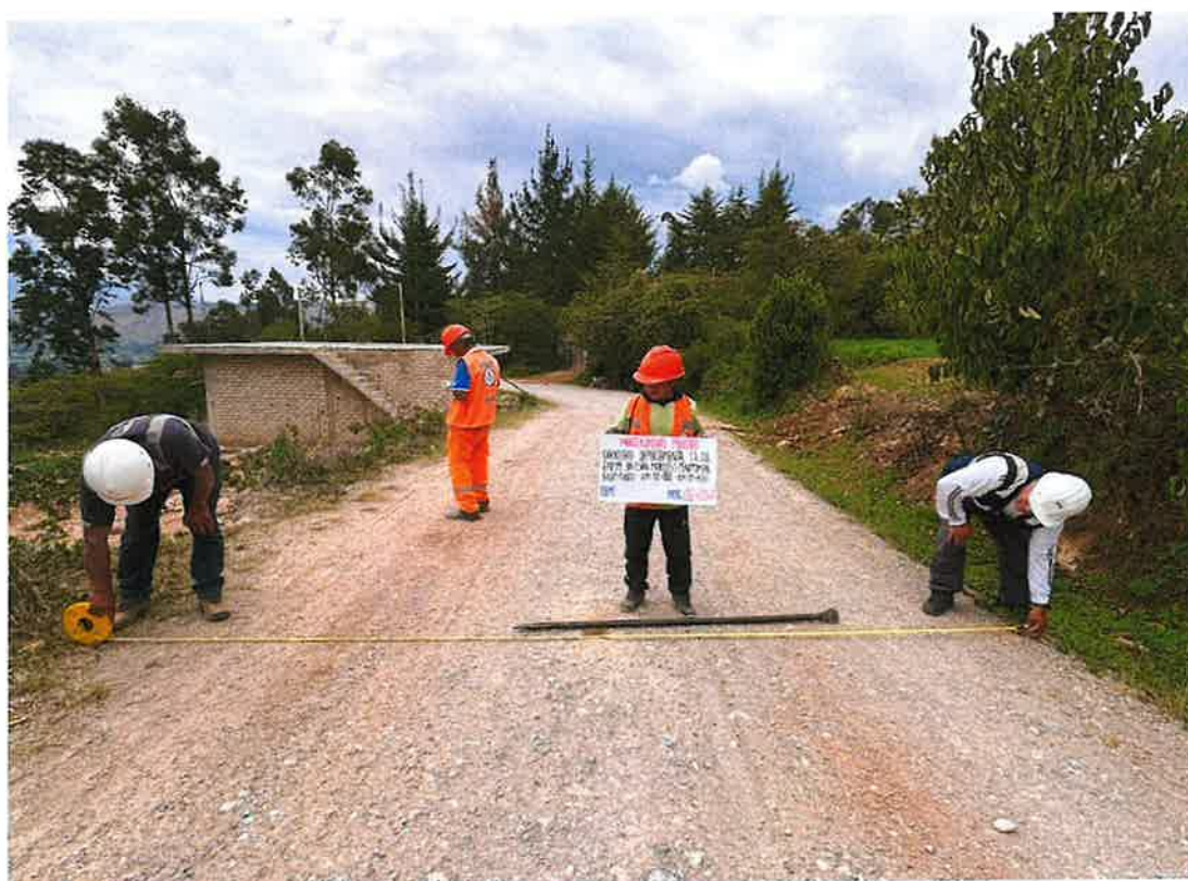
Foto 12: Medidas en la superficie de rodadura, progresiva 02+750
