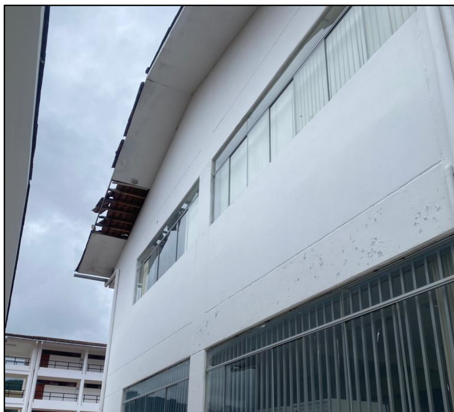
Imagen 01. Se observa en esta imagen la situación actual del área del proyecto el desprendimiento de cobertura.
