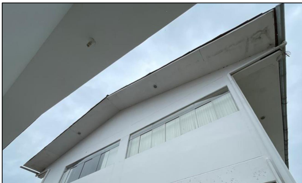
Imagen 02. Se visualiza la humedad bajo cobertura.
