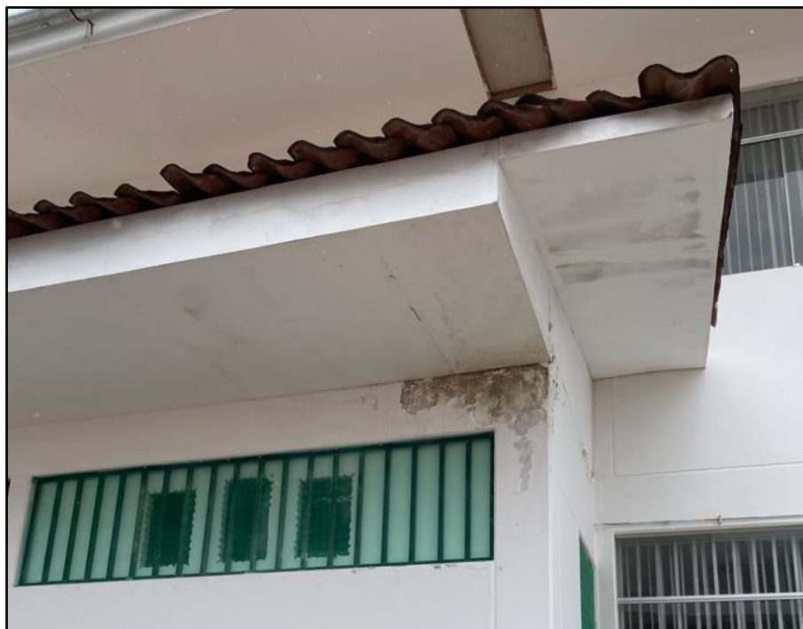
Imagen 03. Humedad en elementos de concreto.
