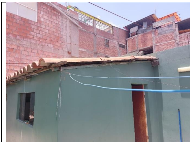
RETIRO DE COBERTURA TEJA Y CAMBIO DE CALAMINON PREPINTADO
