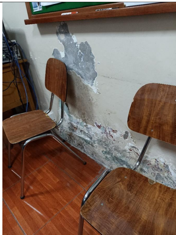
RASQUETEADO, DESMANCHADO, MASILLADO Y LIJADO DE MUROS P/PINTADO
