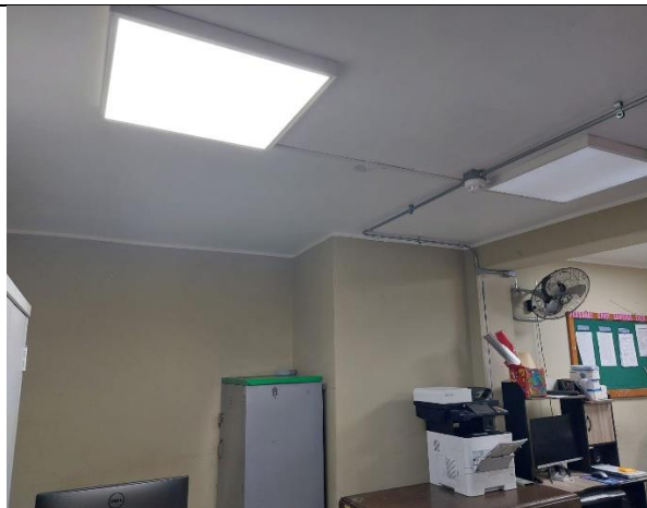
COLOCACIÓN DE LUMINARIA LED 60x60x48W
