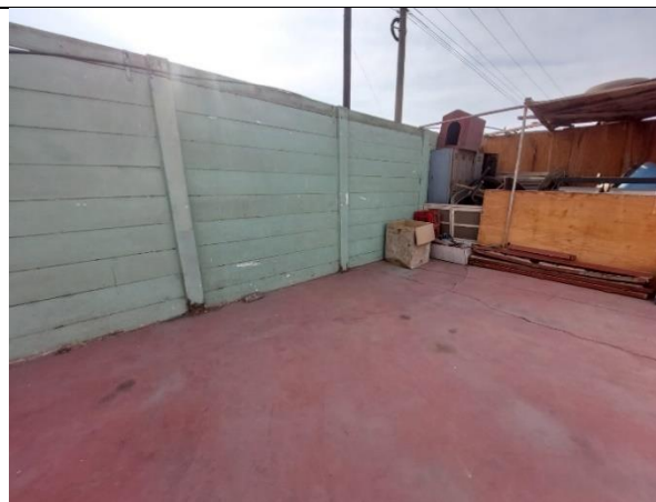
MUROS DE DRYWALL DOS CARAS (FRIBROCEMENTO-YESO) E=12cm
