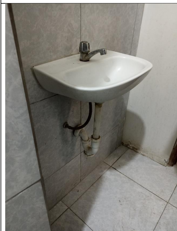
RETIRO Y CAMBIO DE GRIFERIA LAVATORIO - TUBO DE ABASTO - TRAMPA
