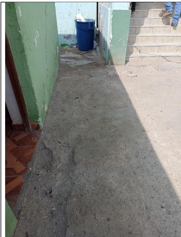
CONCRETO DE PISO PULIDO MEZCLA 1:8 CEMENTO-HORMIGON h=10cm
