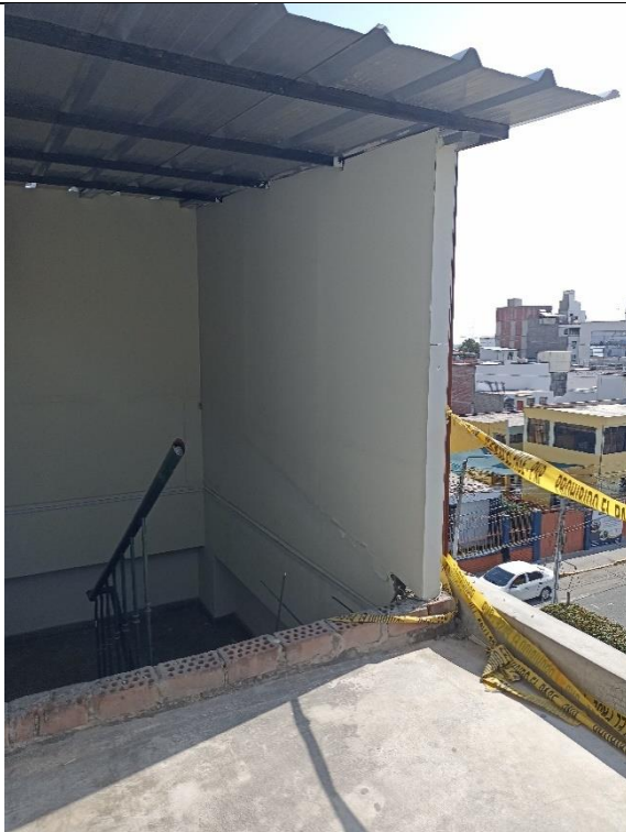
BARANDA METALICA C/TUBO 2" - 1.5" INC/PINTURA ESMALTE
