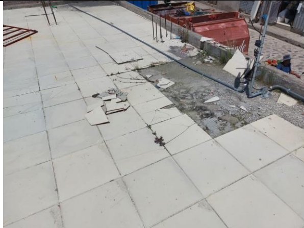
RETIRO DE CERAMICO Y DEMOLICION DE SOBRECARGA
