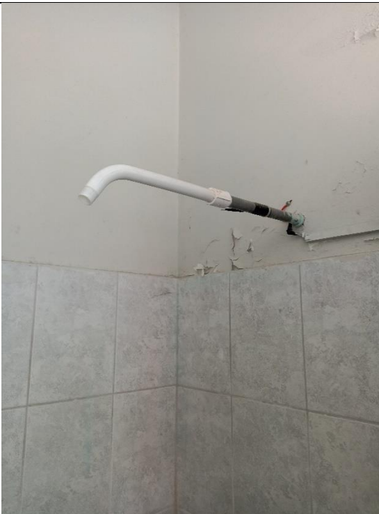
RETIRO DE DUCHA ELECTRICA Y COLOCACIÓN DE RAPIDUCHA
