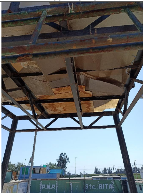
COLOCACIÓN DE FENOLICO DE 18mm DOBLE EN PLATAFORMA
