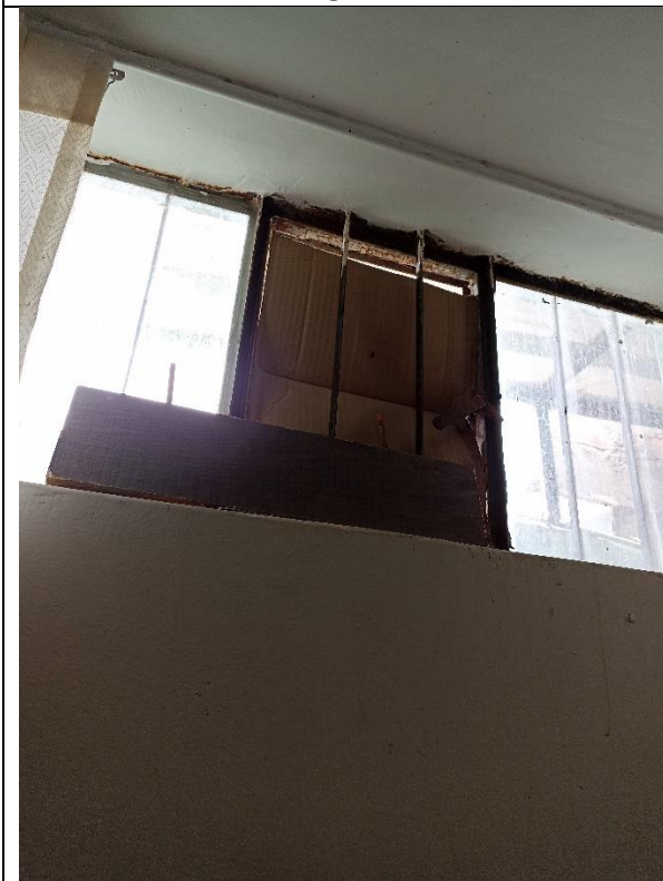
CAMBIO DE VIDRIO CRUDO DE 4mm
