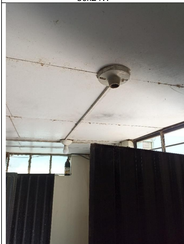
CAMBIO DE LUMINARIA LED CIRC. 30x24W
