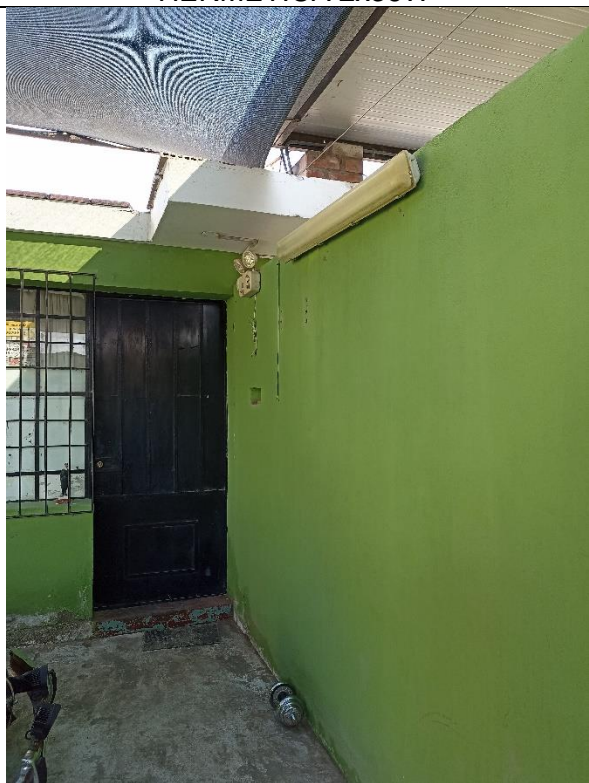
CAMBIO DE LUMINARIA LED HERMETICA 2x36W
