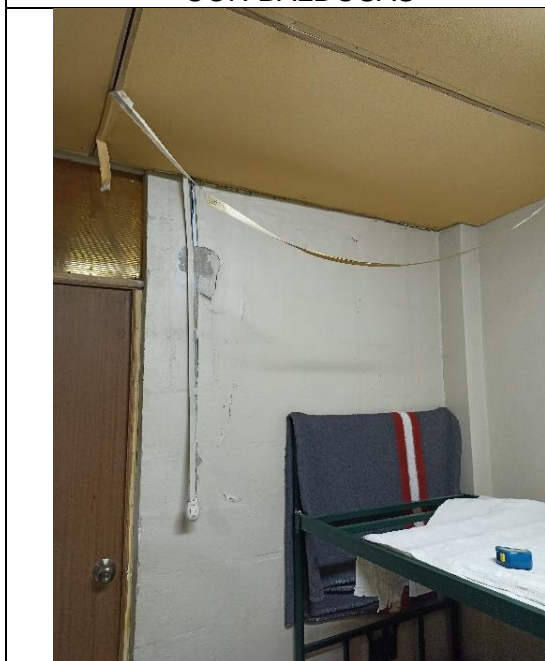
COLOCACIÓN DE CANALETA PVC ADHESIVA
