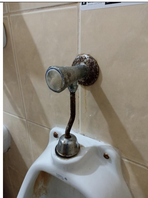
RETIRO Y CAMBIO DE LLAVE TEMPORIZADORA PARA URINARIO
