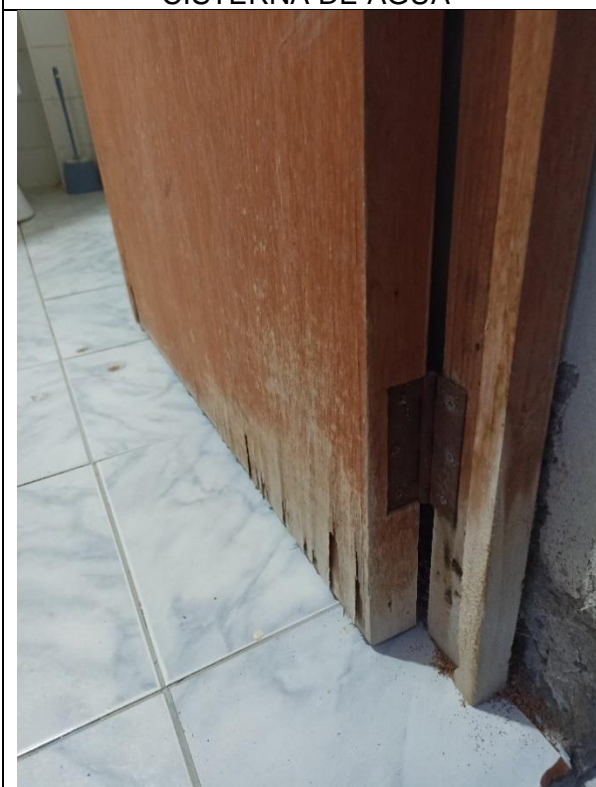
PUERTA CONTRAPLACADA C/MARCO DE MADERA Y REFUERZOS 0.80 x 2.35m INC/CERRADURA TIPO PERILLA
