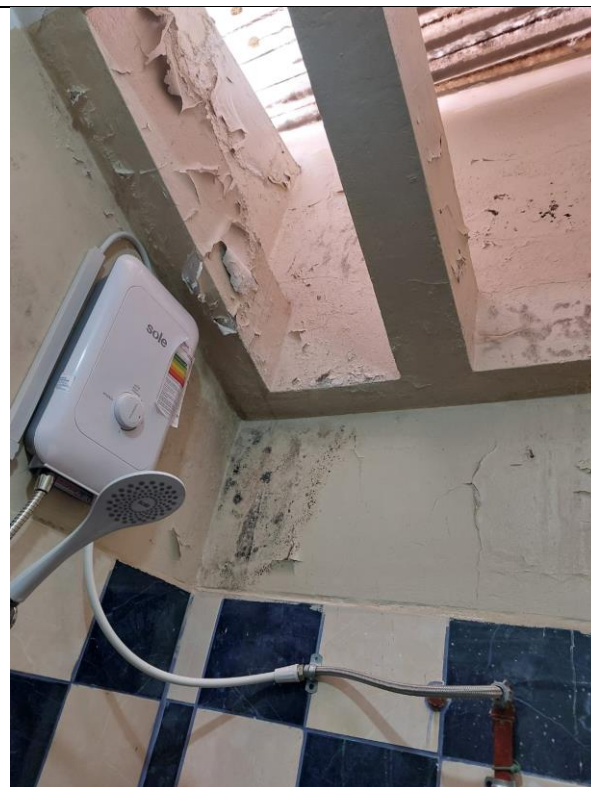
RASQUETEADO, DESMANCHADO, MASILLADO Y LIJADO DE MUROS Y CIELO RASO P/PINTADO
