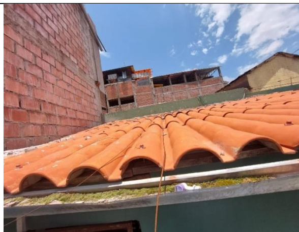
CANALETA ALUZINC 4" x 4" INC/SOPORTERIA METALICA
