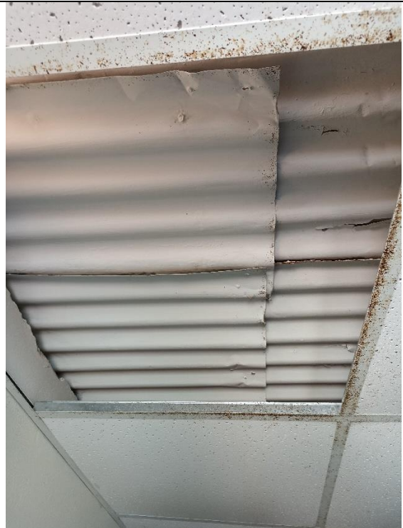
RETIRO DE COBERTURA DE CALAMINA FIBROCEMENTO
