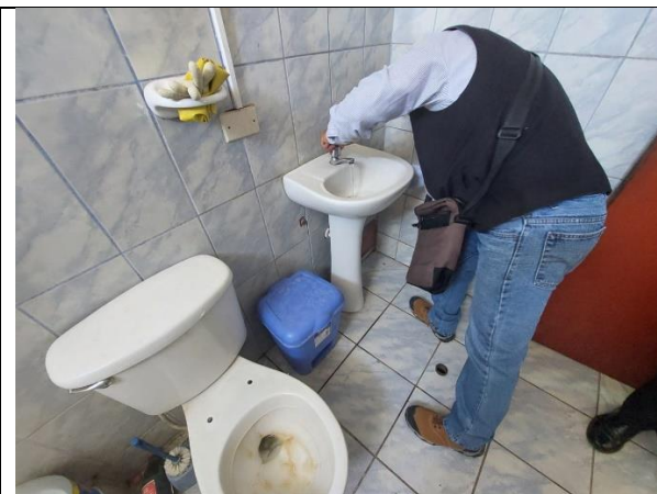
RETIRO Y CAMBIO DE GRIFERIA LAVATORIO - TUBO DE ABASTO - TRAMPA P
