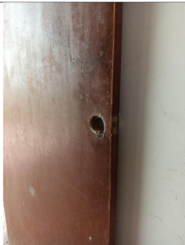
CAMBIO DE HOJA CONTRAPLACADA DE MADERA INC/BISAGRA 0.85x2.05m
