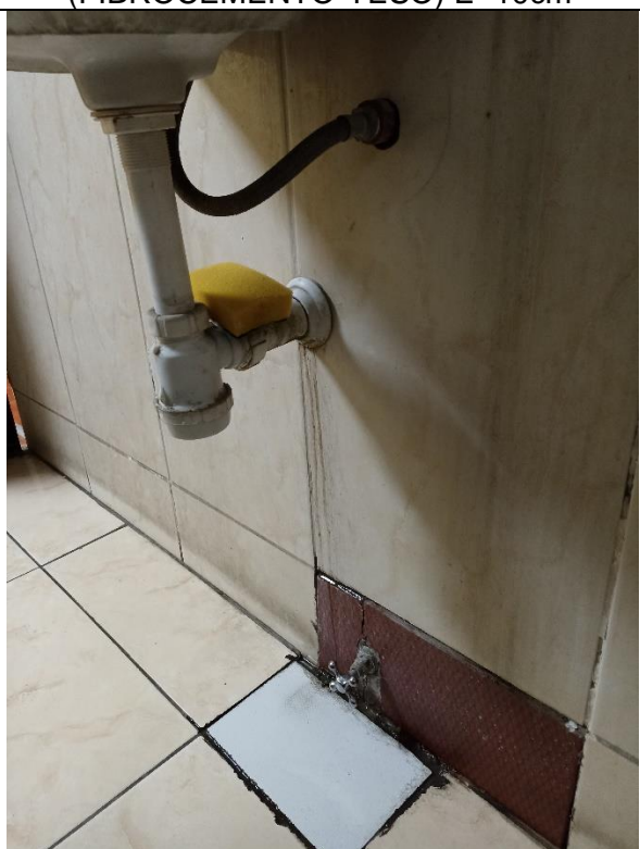
CORTE DE MURO, RETIRO Y REPOSICION DE CERAMICO PARA TUBERIA-VALVULAS DE PASO
