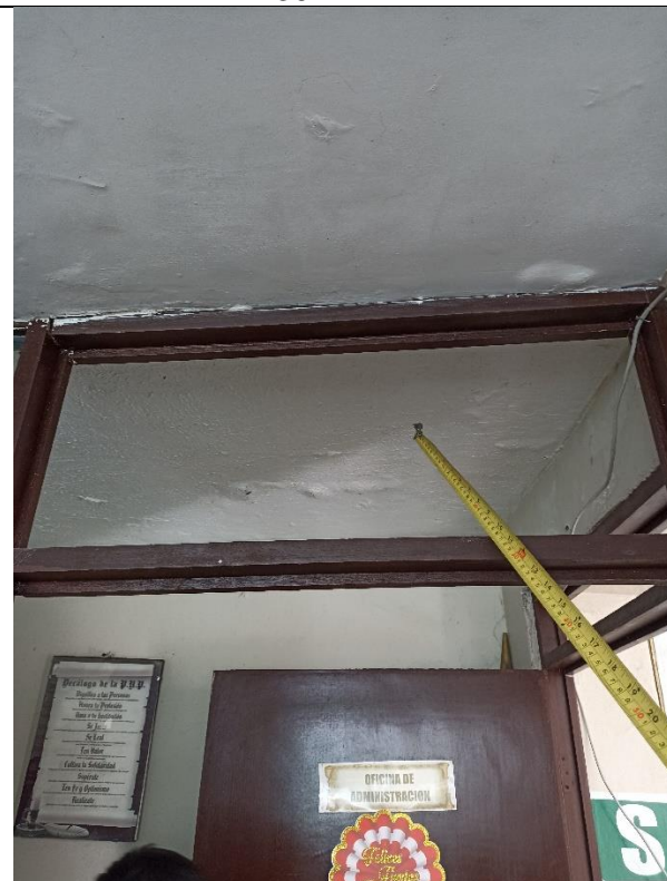
CAMBIO DE VIDRIO CRUDO DE 4mm
