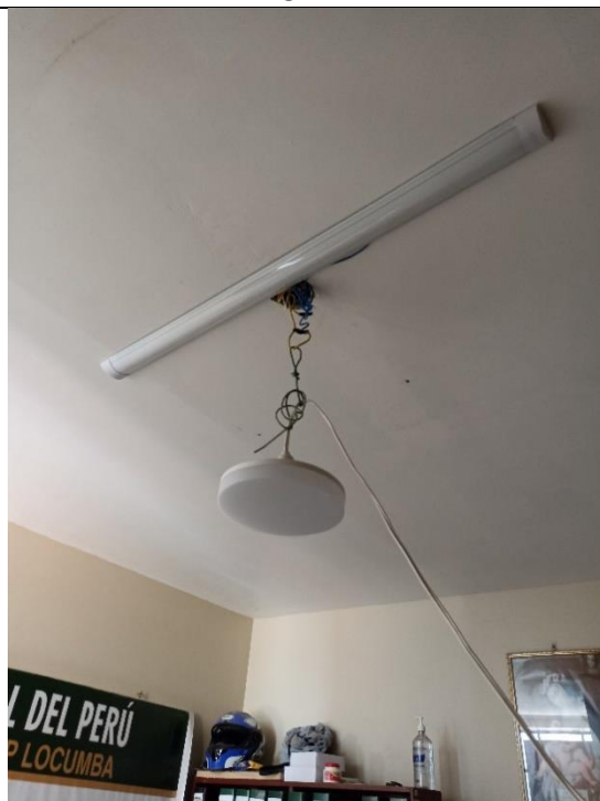
COLOCACIÓN DE LUMINARIA LED
