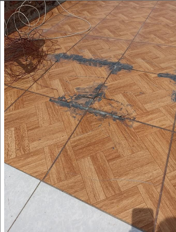
RETIRO DE CERAMICO Y DEMOLICION DE SOBRECARGA h=0.10m
