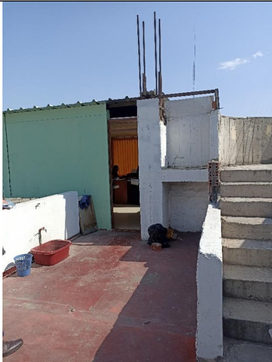
DEMOLICION DE PISO, MURO Y LOSA DE CONCRETO
