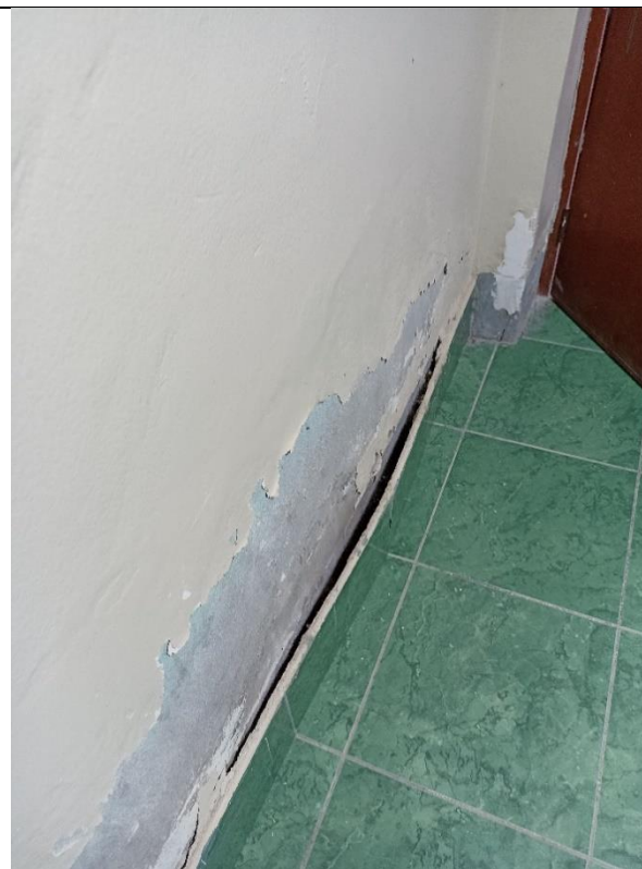
REPOSICION DE ZOCALO DE CERÁMICO h=0.20\text{m} EXISTENTE
