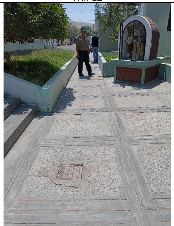
ROTURA DE PISO DE CONCRETO
