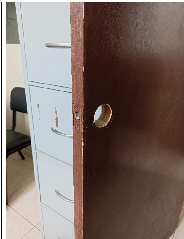
CAMBIO DE CERRADURA TIPO PERILLA
