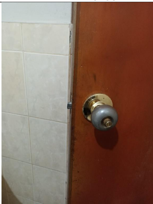
RETIRO Y CAMBIO DE CERRADURA TIPO PERILLA
