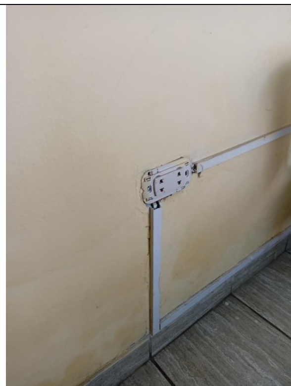
CAMBIO DE TOMACORRIENTE DOBLE
