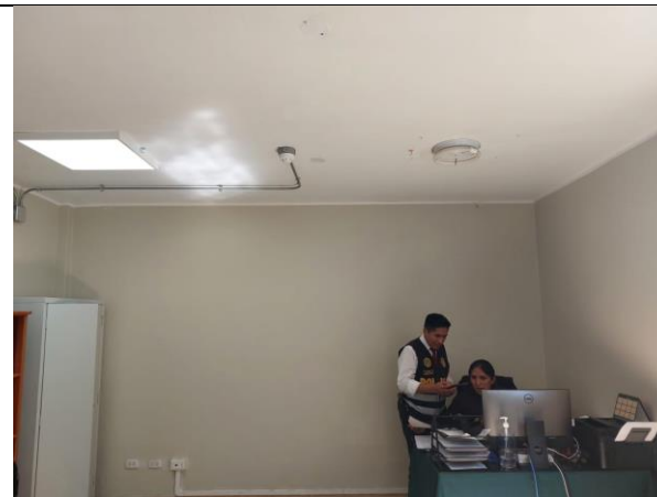
COLOCACIÓN DE LUMINARIA LED 60x60x48W
