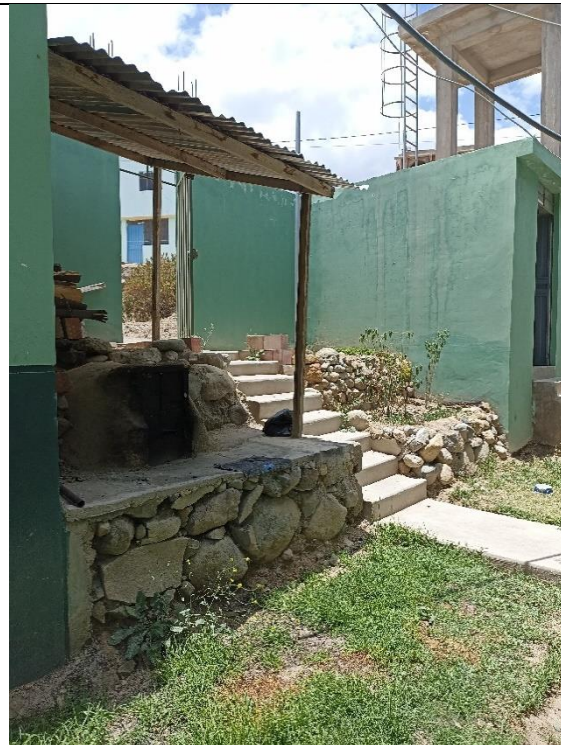
MURO DE CONTENCIÓN DE CONCRETO CICLOPEO
