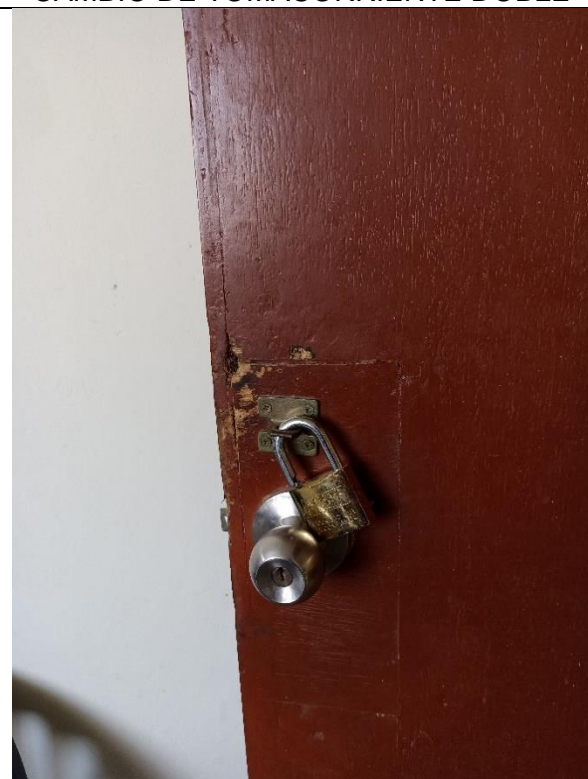
PUERTA CONTRAPLACADA C/MARCO DE MADERA 0.90 x 2.65m INC/VIDRIO - CERRADURA TIPO PERILLA
