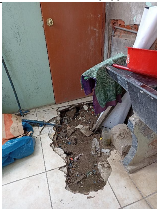
CONCRETO EN FALSO PISO MEZCLA 1:8 CEMENTO-HORMIGON E=15cm
