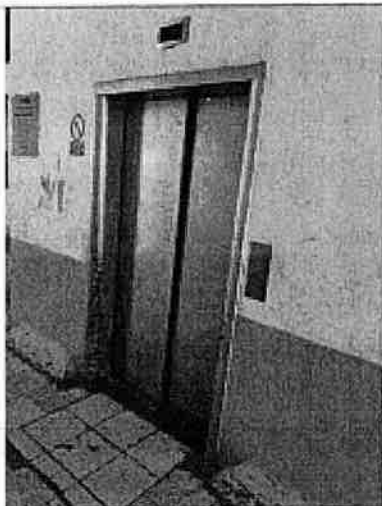
Foto N° 01: Se observa el marco de la puerta en malas condiciones con golpes y abolladuras.
