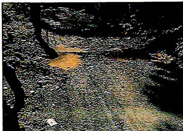
Foto 05: Baches y ahuellamientos
