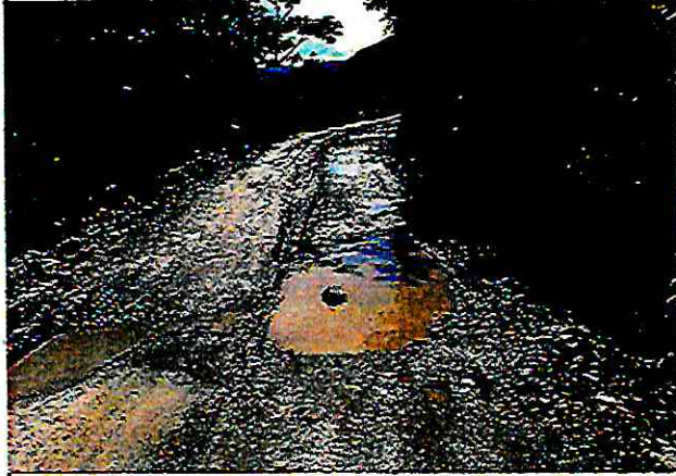
Foto 01: Baches y ahuellamientos
