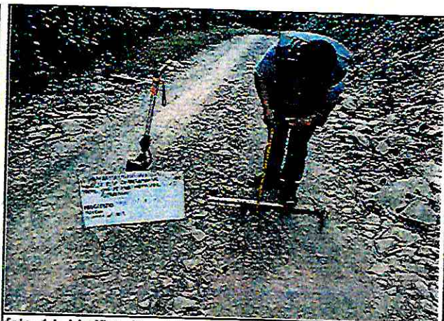
foto 14: Verificación del espesor existente de afirmado E= 0.02 mts
