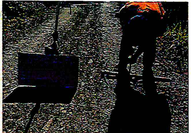
Foto 04: Verificación del espesor existente de afirmado E=0.03 mts
