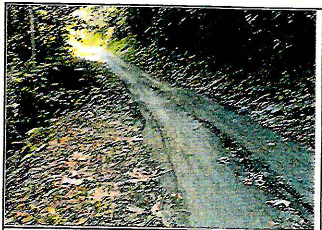
Foto 12: Baches y ahuellamientos
