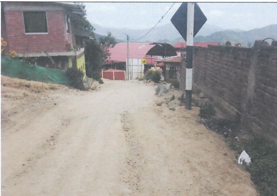
PROGRESIVA: 1+730-1+755. Cuneta obstruida debido a colmatación y malezas.
