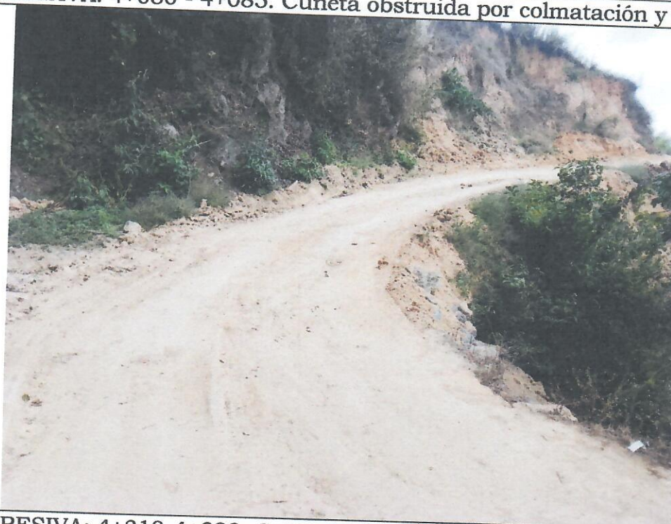
PROGRESIVA: 4+310-4+320. Cuneta obstruida por colmatación y material de derrumbe.
