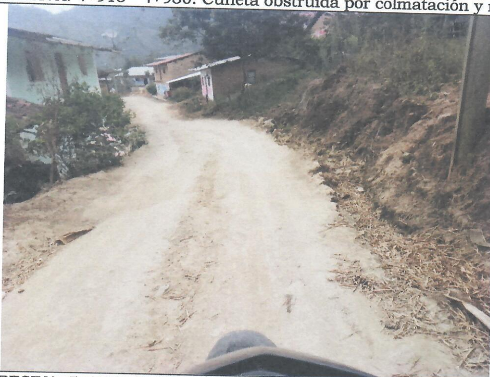
PROGRESIVA: 5+060 - 5+090. Cuneta obstruida por maleza y colmatación.
