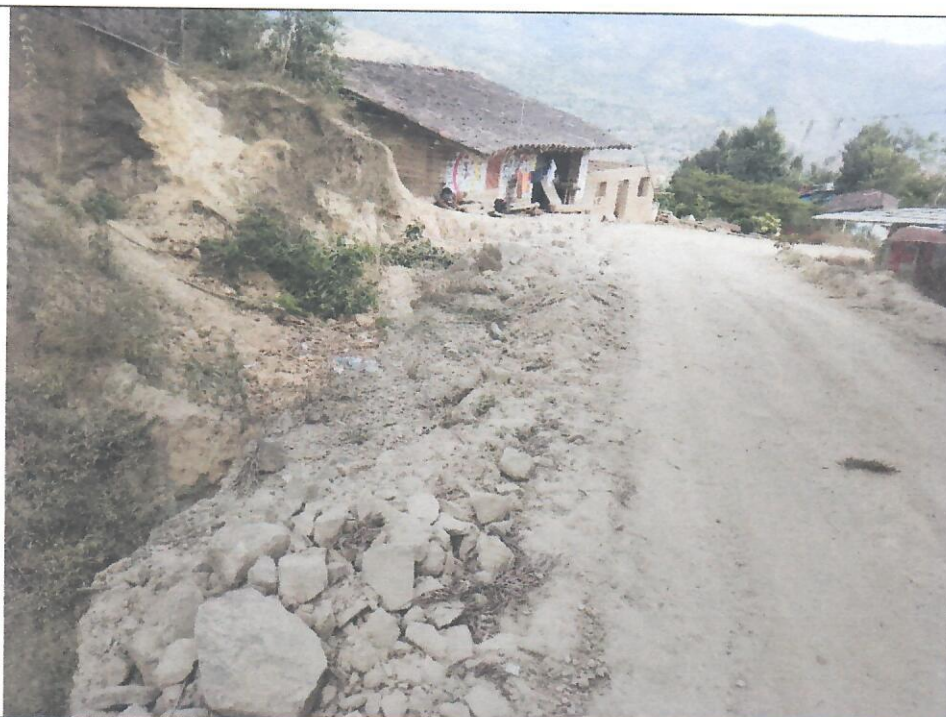
PROGRESIVA: 2+600-2+850. Cuneta obstruida por material de derrumbre y colmatación.
