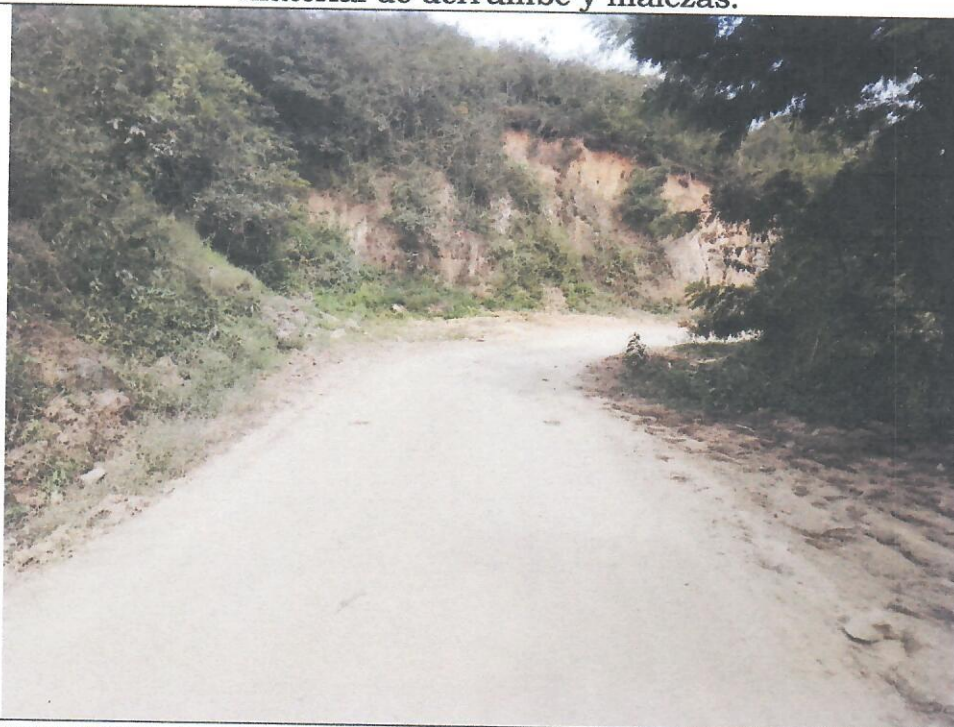
PROGRESIVA: 1+340-1+360. Obstrucción de cuneta por colmatación, material de derrumbe y malezas.
