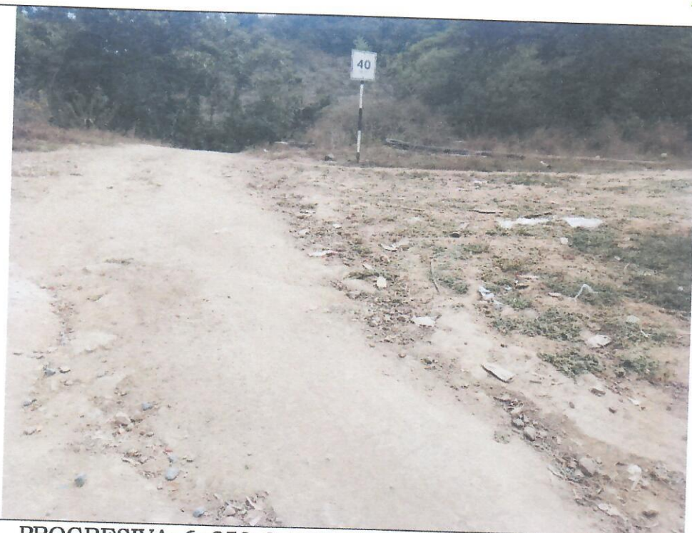
PROGRESIVA: 6+250-6+600. Cuneta obstruida por maleza.
