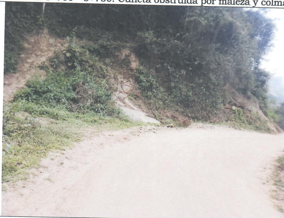
PROGRESIVA: 5+860 - 5+880. Cuneta obstruida por maleza y material de derrumbe.
