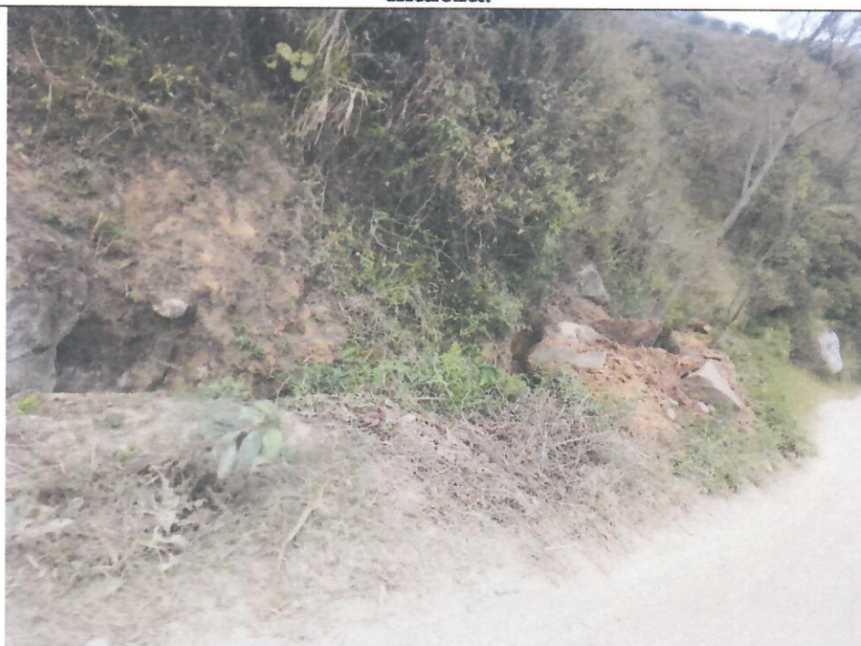
PROGRESIVA: 2+600-2+675. Cuneta obstruida por maleza, material de derrumbe y colmatación.
