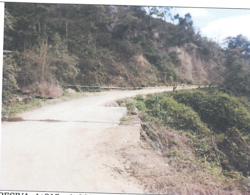
PROGRESIVA: 4+915 - 4+930. Cuneta obstruida por colmatación y maleza.
