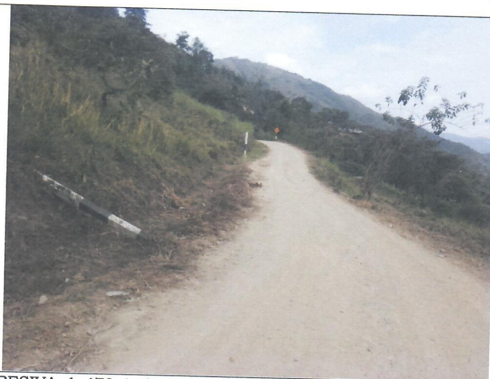
PROGRESIVA: 4+470-4+520. Cuneta obstruida por material de derrumbre y colmatación.
