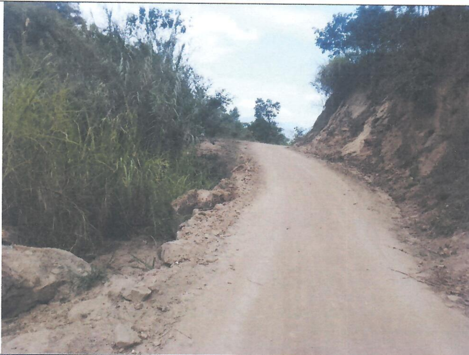
PROGRESIVA: 3+400-3+650. Cuneta erosionada y obstruida por colmatación y material de derrumbre.
