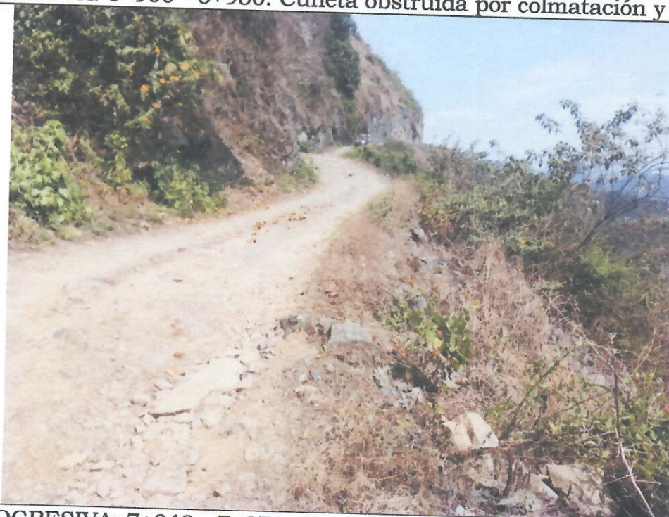
PROGRESIVA: 7+040 - 7+070. Cuneta obstruida por material propio, colmatación y maleza.
