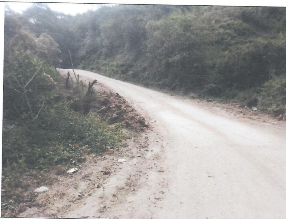
PROGRESIVA: 1+240-1+288. Obstrucción de cuneta por colmatación, material de derrumbe y malezas.
