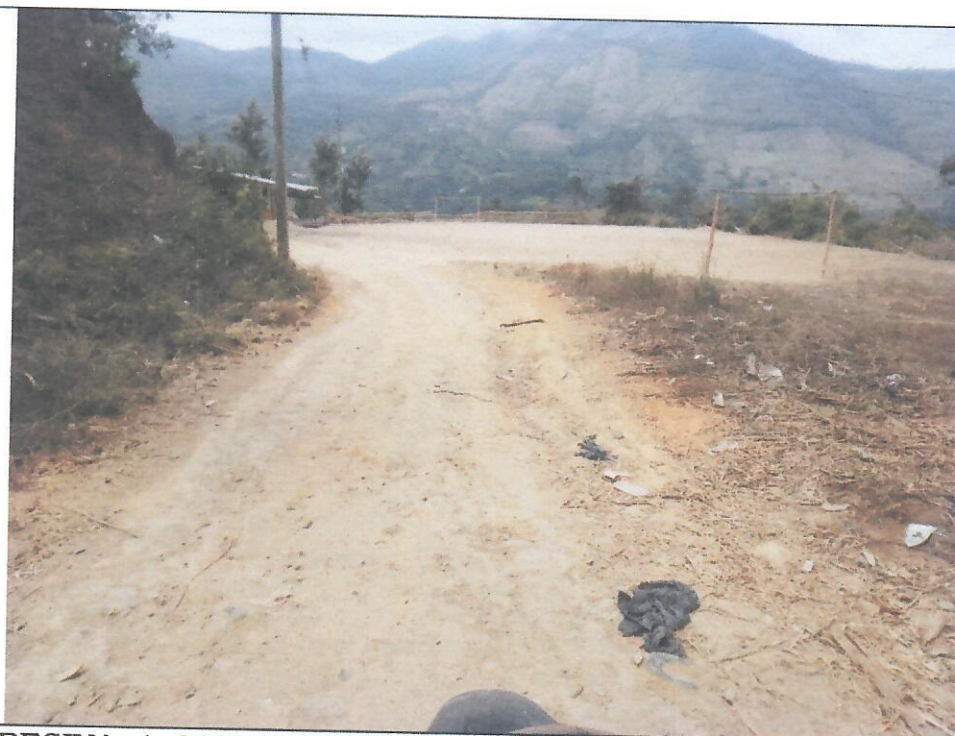
PROGRESIVA: 1+200 - 1+230. Cuneta obstruida por colmatación y maleza.
