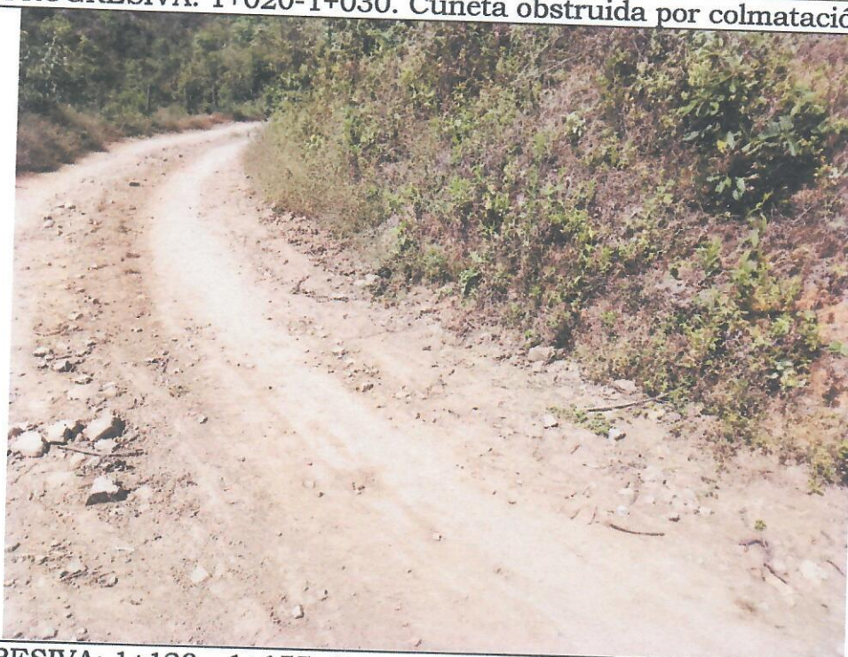
PROGRESIVA: 1+120 - 1+155. Cuneta obstruida por colmatación y material propio.
