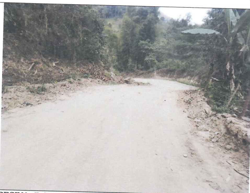
PROGRESIVA: 5+700 - 5+760. Cuneta obstruida por maleza y colmatación.
