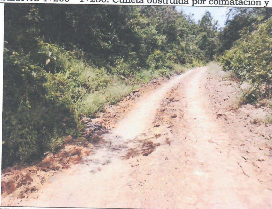
PROGRESIVA: 1+450 - 1+475. Cuneta obstruida por colmatación y material propio.
