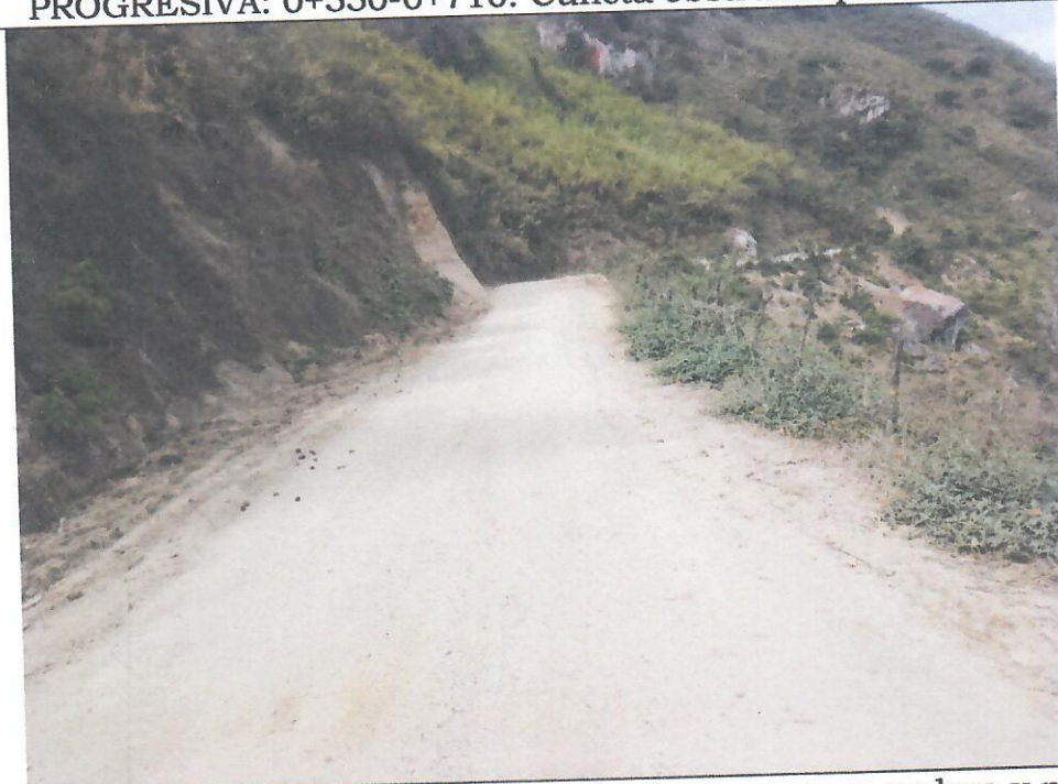
PROGRESIVA: 0+700-0+730. Obstrucción de cuneta por maleza y material de derrumbe.
