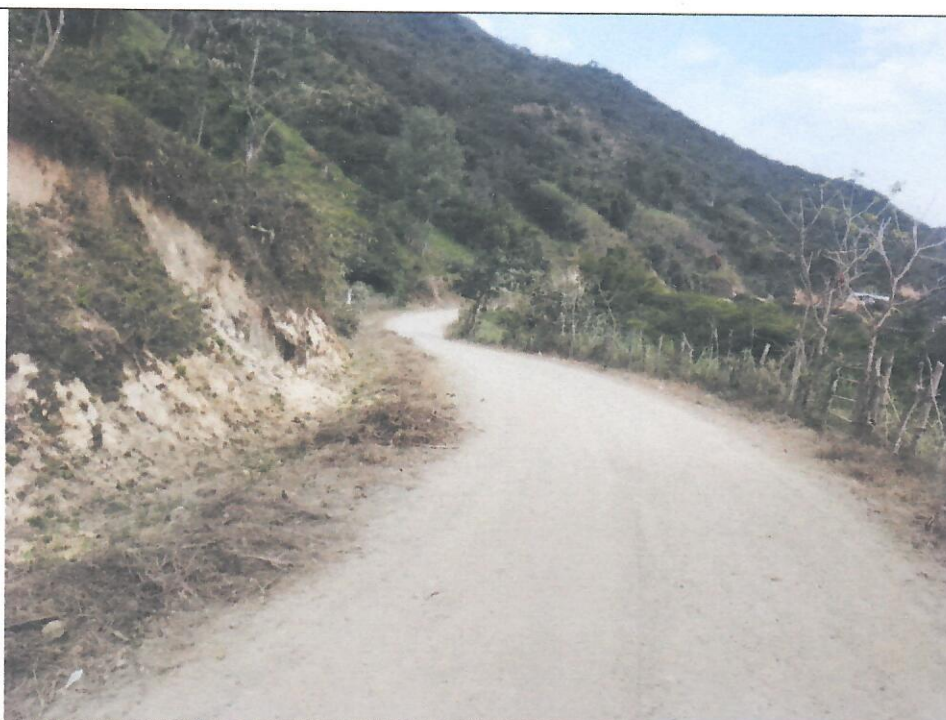
PROGRESIVA: 2+300-2+500. Cuneta obstruida por material de derrumbre y maleza.
