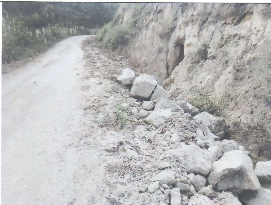
PROGRESIVA: 1+600-1+700. Cuneta obstruida por colmatación y material de derrumbe.
