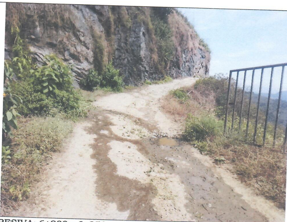
PROGRESIVA: 6+900 - 6+950. Cuneta obstruida por colmatación y maleza.
