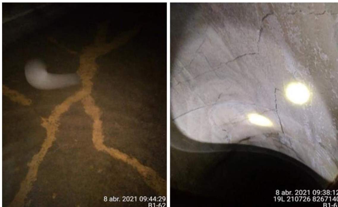
Figura 1.8-1 Grietas radiales y fisuras en la estructura del Túnel 9
