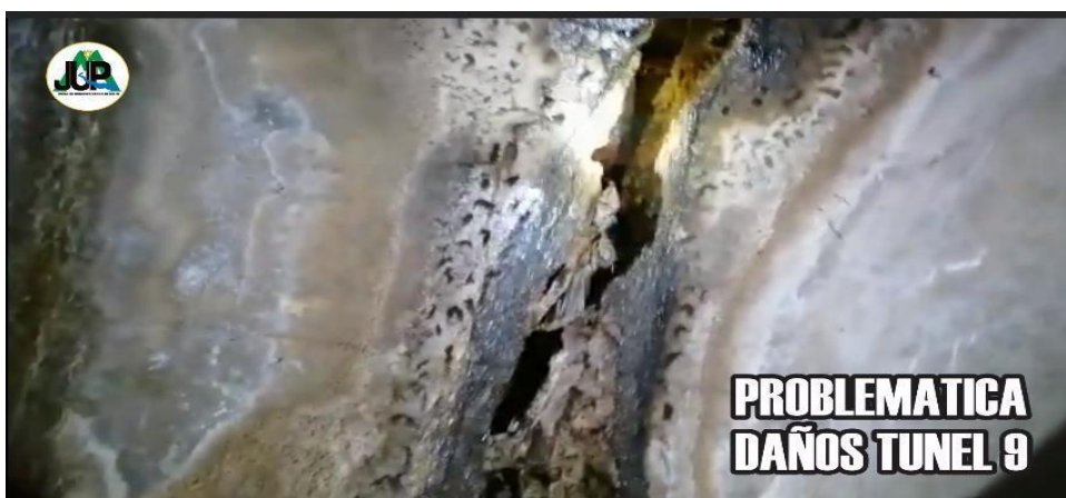
Figura. 1.8-4 Se evidencia que no existe ningún reforzamiento, en la junta del túnel lo que puede producir fugas de agua a posterior. Saturaciones al exterior
