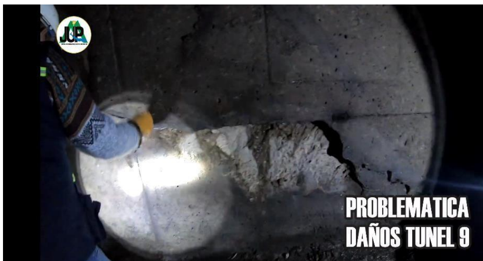
Figura.1.8-2 Desprendimiento en los hastiales del Túnel 9
