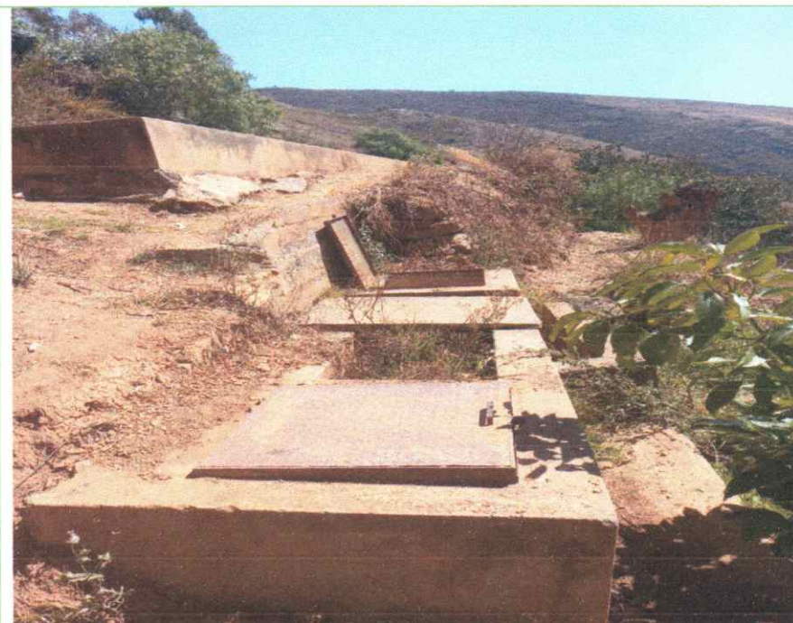
Fotografía N°05: Caja de control en salida de reservorio
