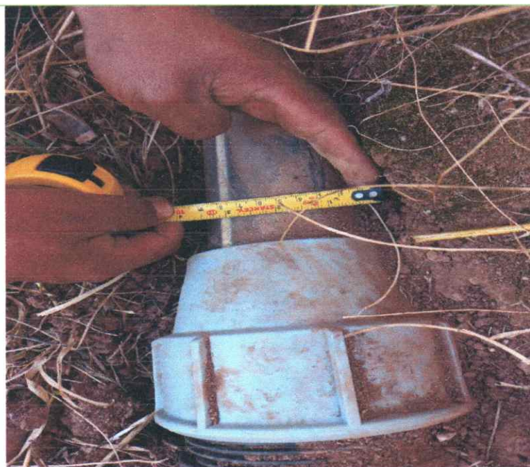
Fotografía N°09: Reducción de manguera 4" a 3"
