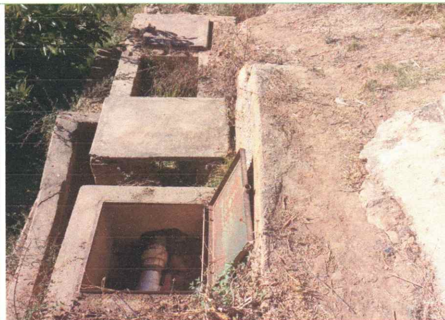
Fotografía N°04: Cajas de control con tapas sanitarias
