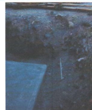
SE OBSERVA SITUACIÓN ACTUAL DE LAS CONEXIONES DOMICILIARIAS, EXPUESTAS AL INTERPERIE Y EN MAL ESTADO.
