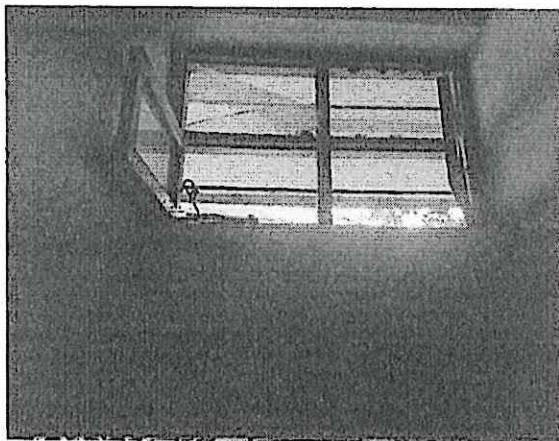
FOTO N°03: LOS AMRCOS DE LAS VENTANAS EN MAL ESTADO
