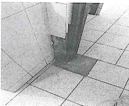
FOTO N°08: PARTE DE PISO MAYOLICA DE DESTRUIDO
