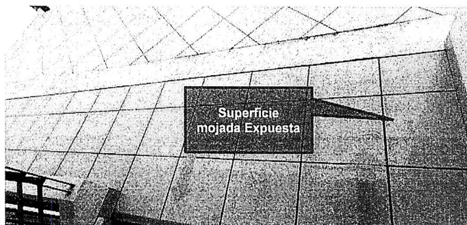
Imagen 11°. El pase de aguade lluvia por los costados de la claraboya principal, humedeciendo el piso por las escaleras y junta de construcción.
