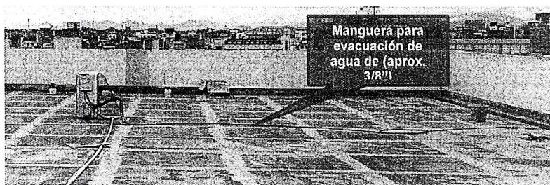
Imagen 17°. Instalaciones temporales de conductores para evacuar el agua proveniente de los equipos de aire acondicionado
