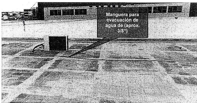
Imagen 16°. Instalaciones temporales de conductores para evacuar el agua proveniente de los equipos de aire acondicionado.
