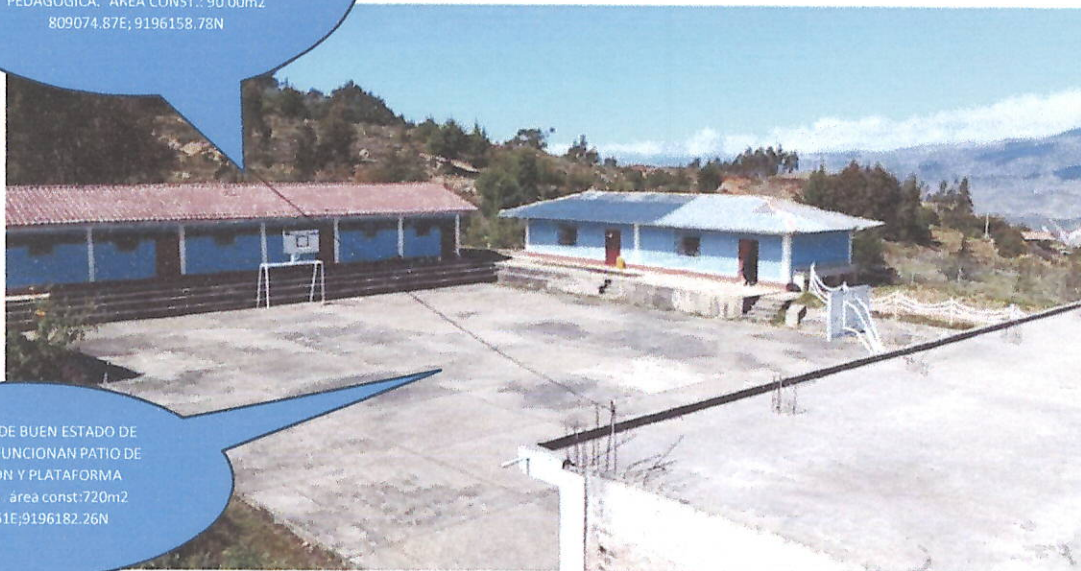
Ilustración 15. MODULO IV: DE BUEN ESTADO DE CONCRETO ARMADO Y LOSA ESTRUCTURA METALICA, FUNCIONAN LOS AMBIENTES DE AULAS DE QUINTO Y SEXTO -AULA DE INOVACION PEDAGOGICA. AREA CONST.: 90.00m2 809074.87E; 9196158.78N - MODULO VI: DE BUEN ESTADO DE CONCRETO ARMADO Y LOSA ALIGERADA, FUNCIONAN LOS AMBIENTES DE AULAS DE TERCER Y CUARTO -AULA TIC. AREA CONST.: 90.00m2 809045.81E; 9196193.26N
