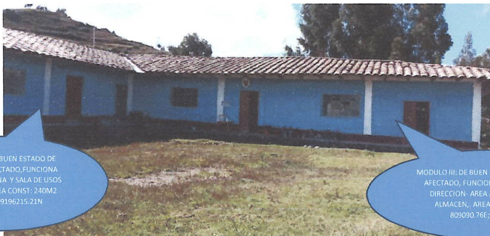
Ilustración 12. MODULO II: DE BUEN ESTADO DE ADOBE, NO AFECTADO, FUNCIONA COMEDOR- COCINA Y SALA DE USOS MULTIPLES. AREA CONST: 240M2 809083.14E;9196215.21N- MODULO III: DE BUEN ESTADO DE ADOBE, NO AFECTADO, FUNCIONAN LOS AMBIENTES DIRECCION- AREA ADMINSTRATIVA Y ALMACEN,. AREA CONS. 140.00m2 809090.76E;9196189.42N
