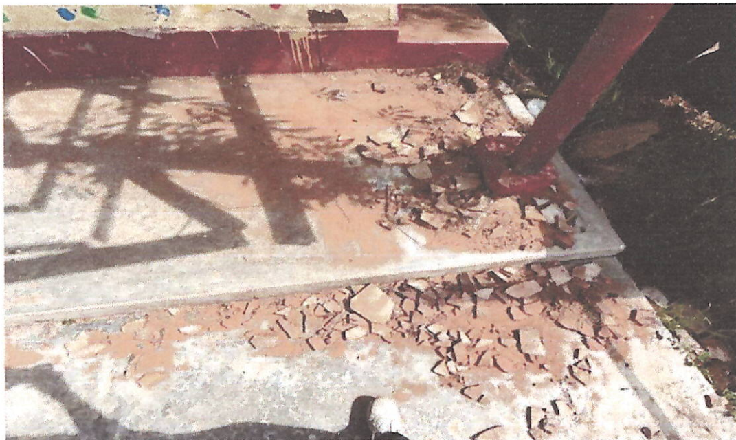
Ilustración 11. Nótese cobertura colapsada del módulo de aula de primer y segundo grado de la I.E. 82086 - LA MANZANILLA, dejando sin servicio a 7 alumnos.
