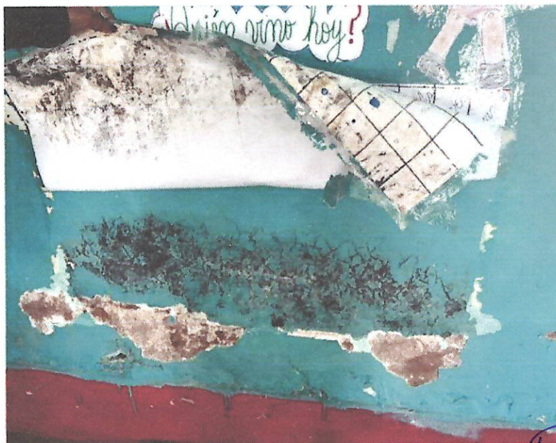
Ilustración 5. Muro interno con grietas por la presencia de inundación por fuertes precipitaciones.
