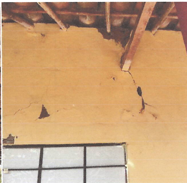
Ilustración 6. Se aprecia muro afectado y por colapsar por las precipitaciones.
