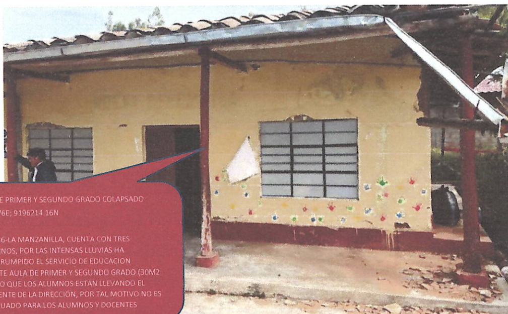
Ilustración 1. SE APRECIA QUE EL MODULO VIII SE ENCUENTRA EN COLAPSO POR INUNDACION DE AGUAS DE LLUVIA, DONDE AFECTO MURO ESTRUCTURAL DE ADOBE Y COBERTURA.
