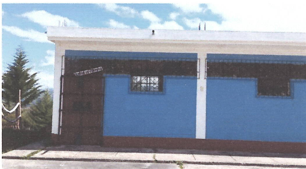
Ilustración 17. MODULO VI: DE BUEN ESTADO DE CONCRETO ARMADO Y LOSA ALIGERADA, FUNCIONAN LOS AMBIENTES DE AULAS DE TERCER Y CUARTO -AULA TIC. AREA CONST.: 90.00m2 809045.81E;9196193.26N
