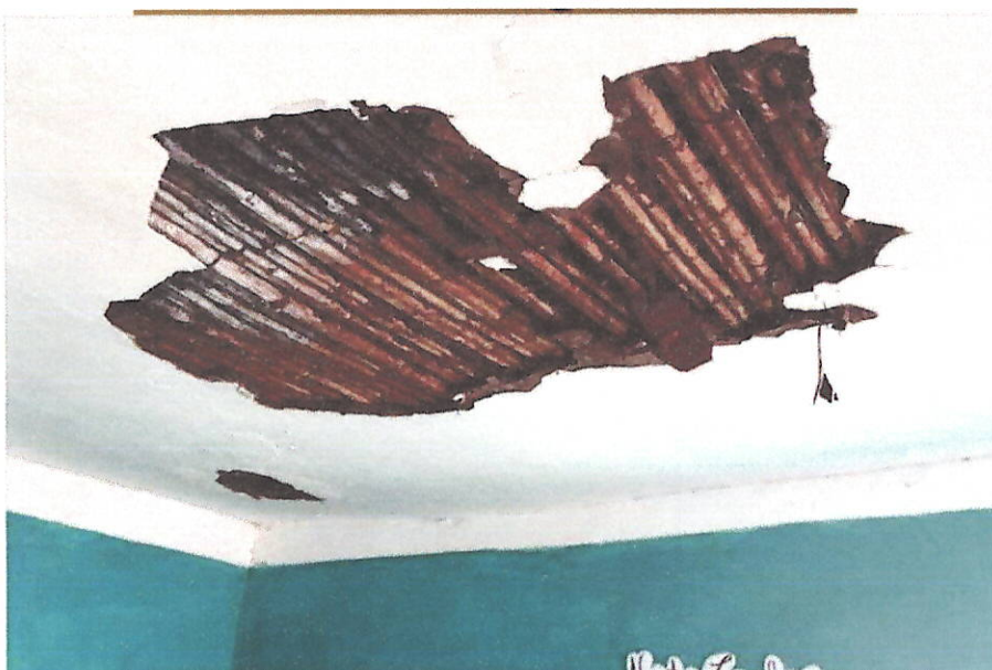
Ilustración 7. Muro estructural con grietas, siendo un peligro para los estudiantes y Ilustración 8. Cielo raso y cobertura de madera colapsada del módulo de aula de primer y segundo grado de la institución educativa la manzanilla.
