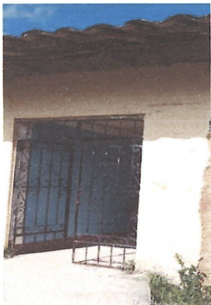
Ilustración 13. MODULO I: DE BUEN ESTADO DE ADOBE, NO AFECTADO, FUNCIONAN EL AMBIENTE DE PORTICO DE ENTRADA -AREA DE INGRESO (área const:36.00m2 )Y CERCO PERIMETRICO EN BUEN ESTADO DE MALLA GALVANIZADA Y ADOBE(220.00 ml). 809066.09E;9196232.20N
