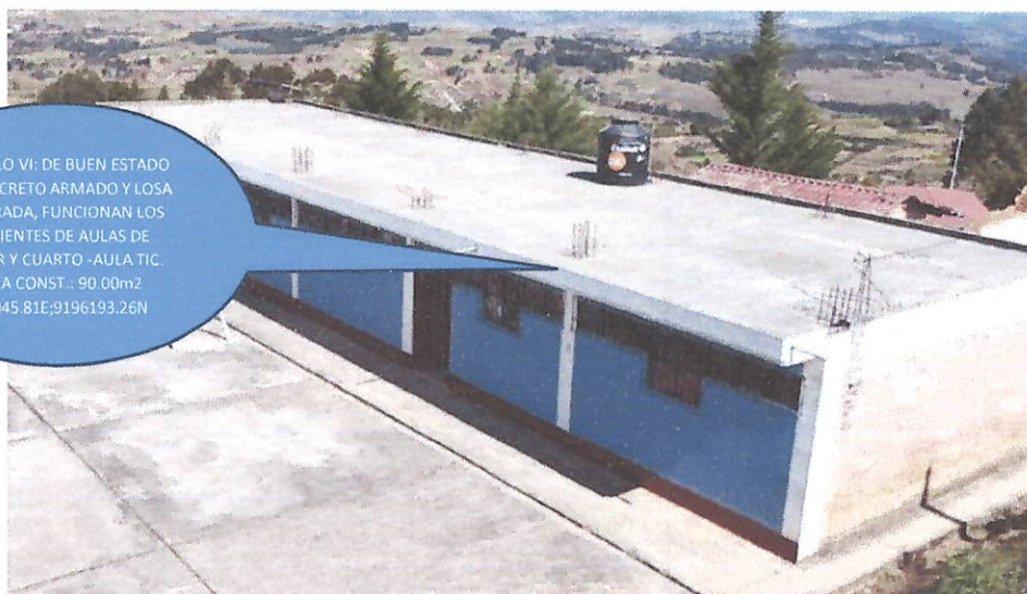
Ilustración 17. MODULO VI: DE BUEN ESTADO DE CONCRETO ARMADO Y LOSA ALIGERADA, FUNCIONAN LOS AMBIENTES DE AULAS DE TERCER Y CUARTO -AULA TIC. AREA CONST.: 90.00m2 809045.81E;9196193.26N
