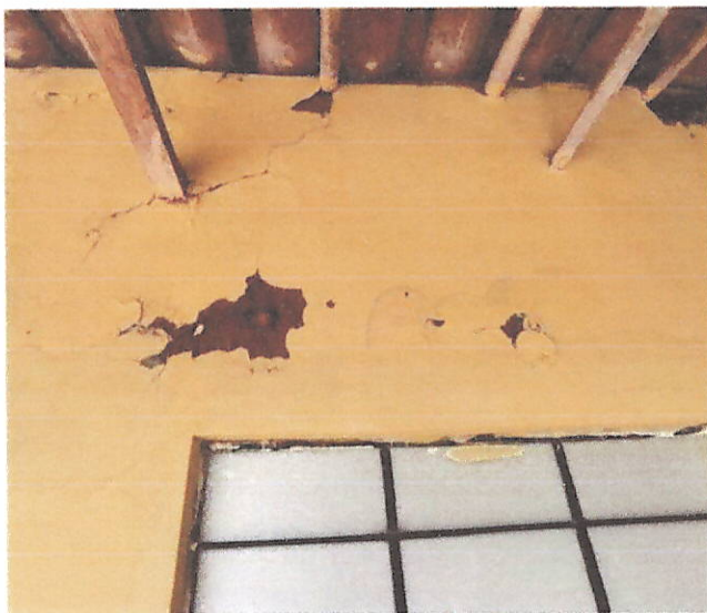
Ilustración 10. Muro exterior de aula con grietas y fisura por asentamiento a causa de la inundación.
