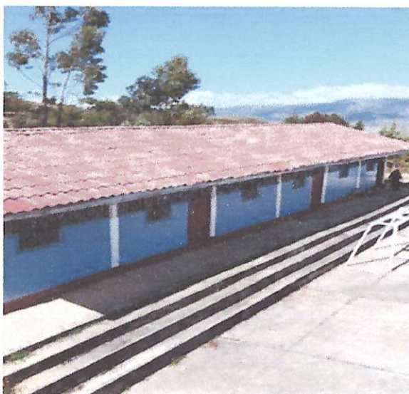
Ilustración 16. MODULO IV: DE BUEN ESTADO DE CONCRETO ARMADO Y LOSA ESTRUCTURA METALICA, FUNCIONAN LOS AMBIENTES DE AULAS DE QUINTO Y SEXTO -AULA DE INOVACION PEDAGOGICA. AREA CONST.: 90.00m2 809074.87E; 9196158.78N
