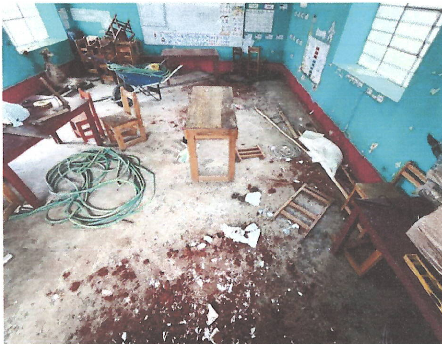
Ilustración 9. Se observa cielo raso y cobertura colapsada dentro del aula de primer y segundo grado de la institución, dejando sin servicio educativo.
