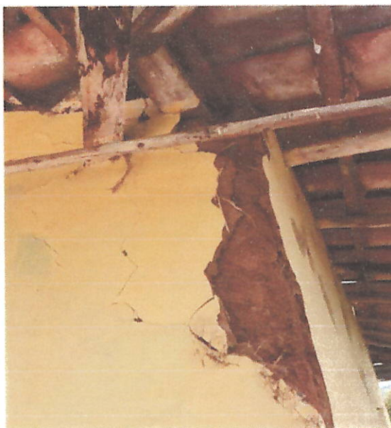
Ilustración 6. Se aprecia muro afectado y por colapsar por las precipitaciones.
