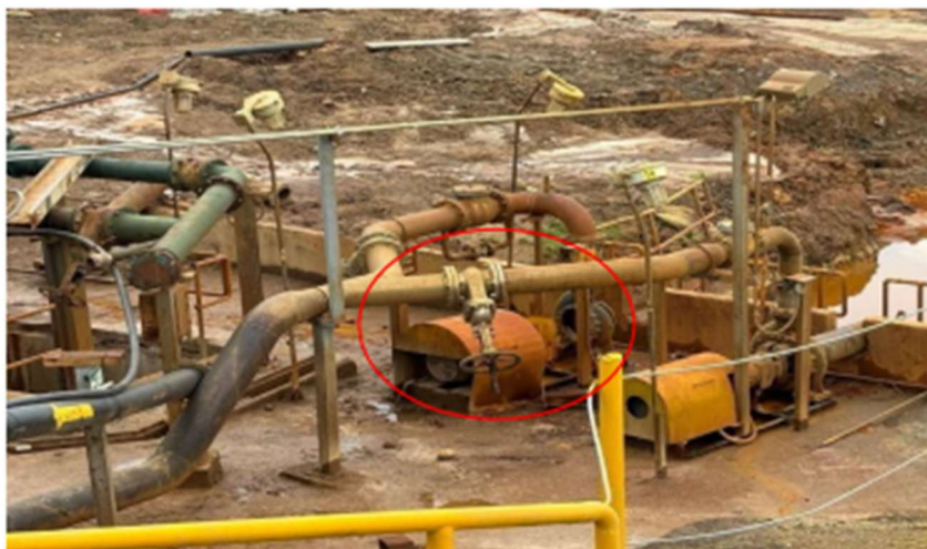
Fig. N°16 En el círculo rojo marca la Y en cual se independizará la línea de 8".
