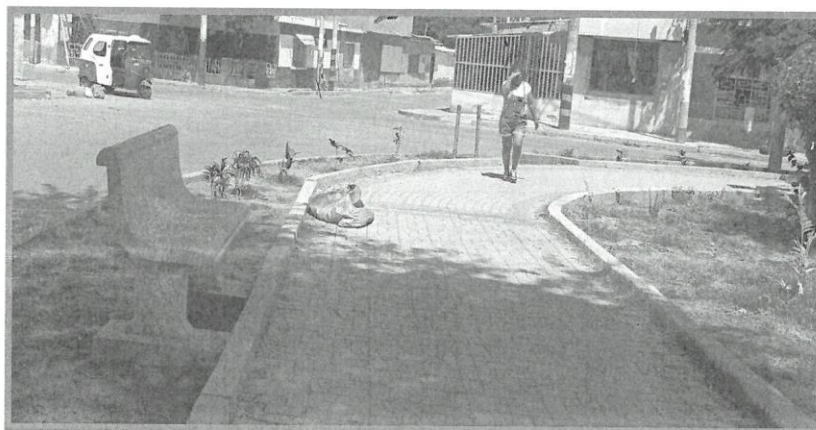
Figura 3: Vista de adoquín de los accesos deteriorado y en mal estado
