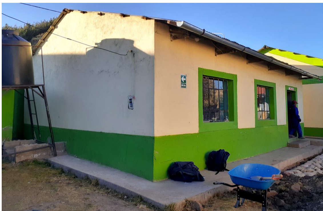
FOTO 21: Imagen corresponde a la infraestructura de la cocina - comedor (Pabellón V). El aula cuenta con vereda de protección de concreto en mal estado de conservación. El sistema constructivo es de adobe, se encuentra en mal estado de conservación, tarrajado con cemento y pintado. Carpintería metálica en puerta y ventanas, se encuentran en regular estado de conservación. El techo es de estructura de madera cerrada con planchas de calamina metálica, a 2 aguas, se encuentra en regular estado de conservación. La infraestructura cuenta con canaleta de evacuación pluvial sin montante. Tiene zócalo sobrepuesto en mal estado y marcos sobrepuestos de cemento en puerta y ventanas.
