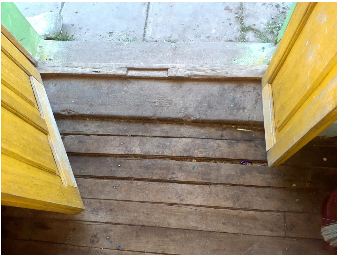
FOTO 8: Imagen corresponde al interior del aula N° 1 (Pabellón I). Los pisos son de madera y se encuentra en mal estado de conservación, presenta desgaste de la madera y se visualiza desprendimiento de material.
