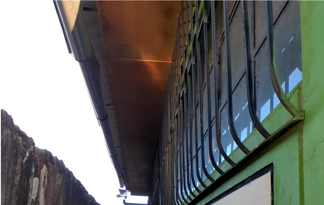
FOTO 12: Imagen corresponde a la fachada posterior de la infraestructura de la dirección y aula N° 2 (Pabellón II). El falso cielo raso de los volados es de triplay, se encuentran en buen estado de conservación.
