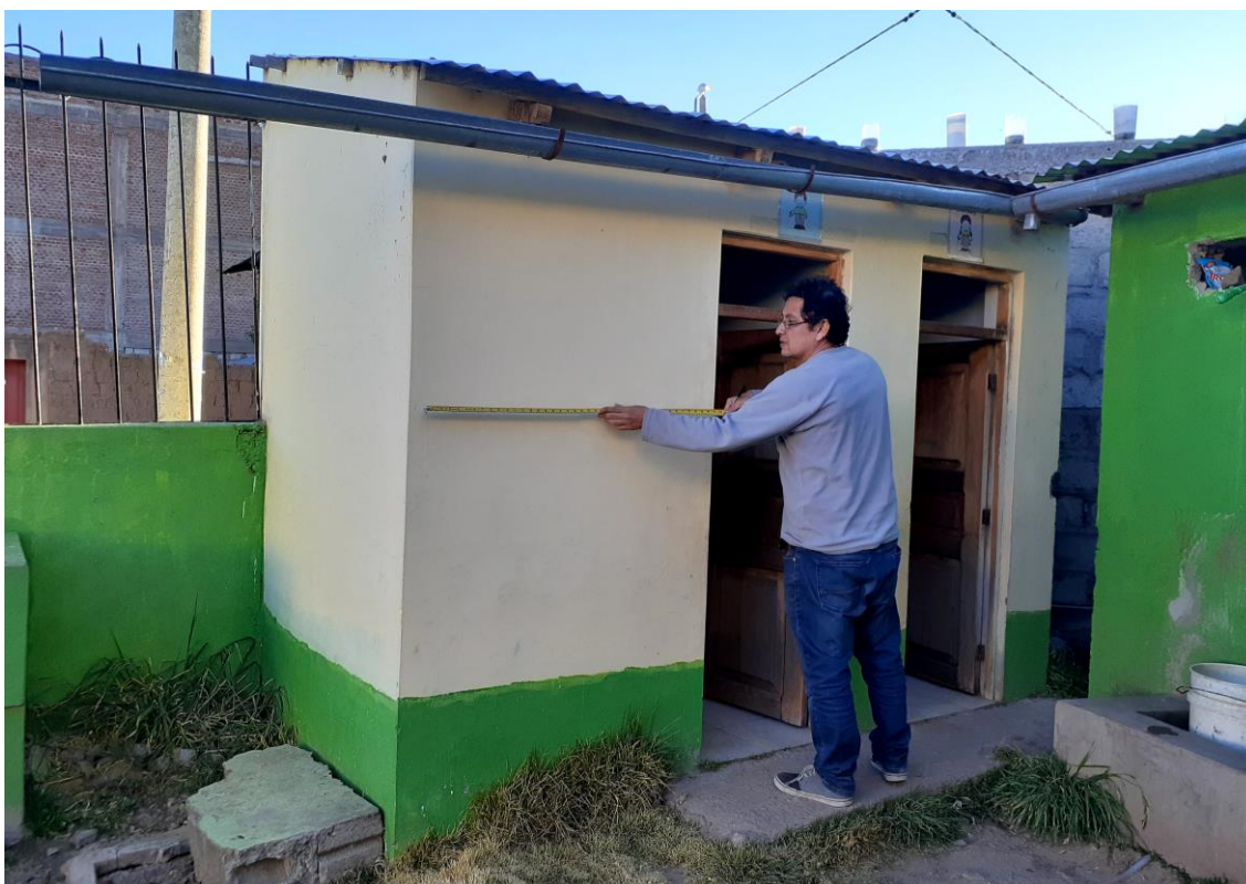
FOTO 31: Imagen corresponde a la infraestructura de las letrinas (Pabellón VII). El sistema constructivo es de albañilería tarrajado con cemento y pintado, se encuentra en buen estado de conservación. El techo es de estructura de madera cerrada con planchas de calamina metálica, se encuentra en regular estado de conservación. La vereda de protección es de cemento frotachado, se encuentra en buen estado de conservación.
