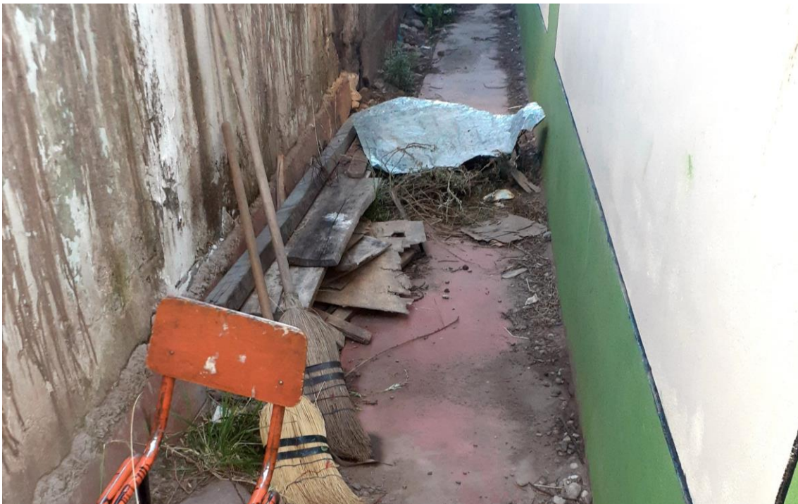
FOTO 13: Imagen corresponde a la fachada posterior de la infraestructura de la dirección y aula N° 2 (Pabellón II). La vereda de protección se encuentra en mal estado de conservación.
