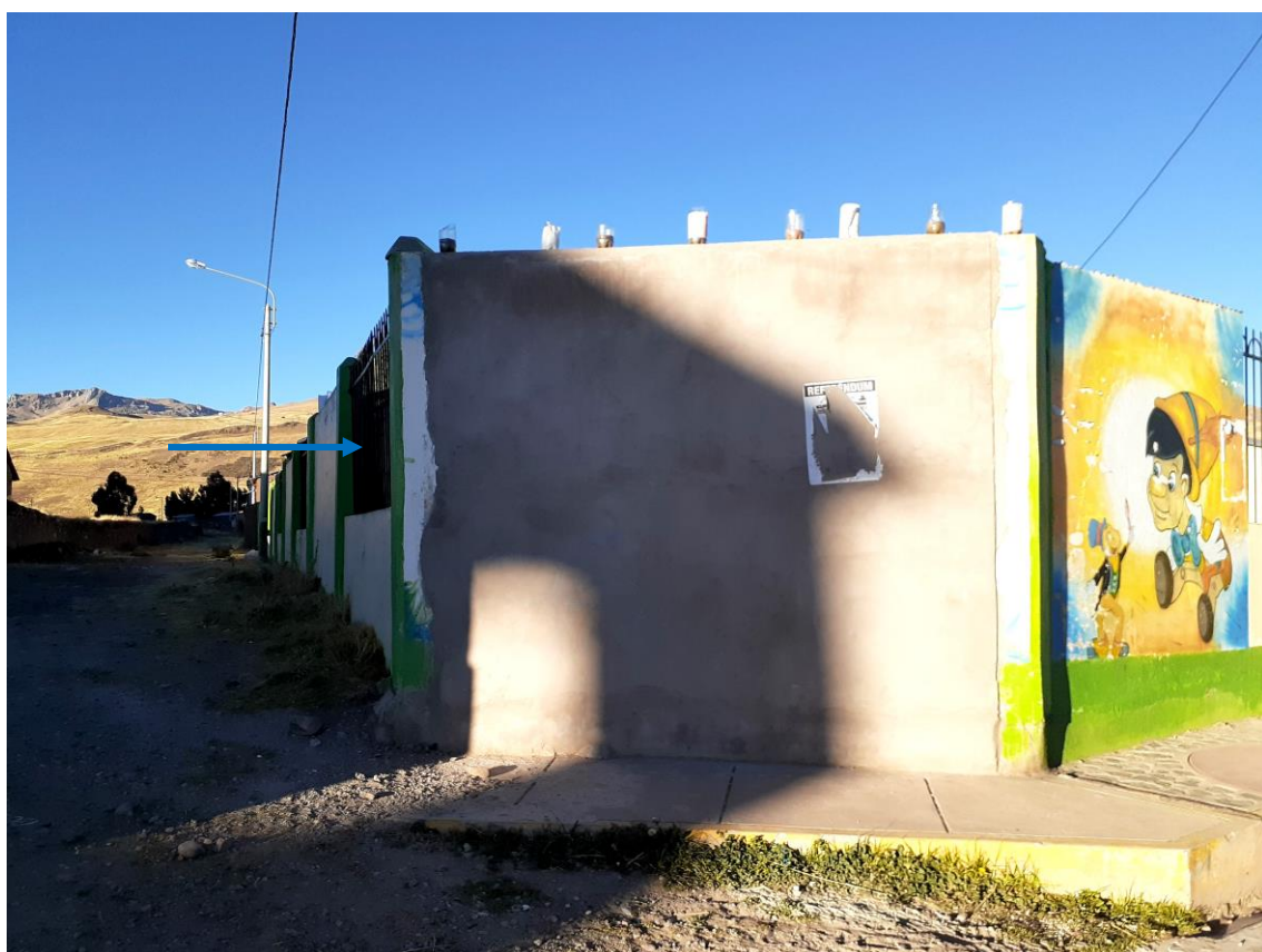
FOTO 3: Imagen del cerco perimétrico. El sistema constructivo es de albañilería, tarrajado y pintado. Se aprecia la reja de protección de fierro negro pintado.
