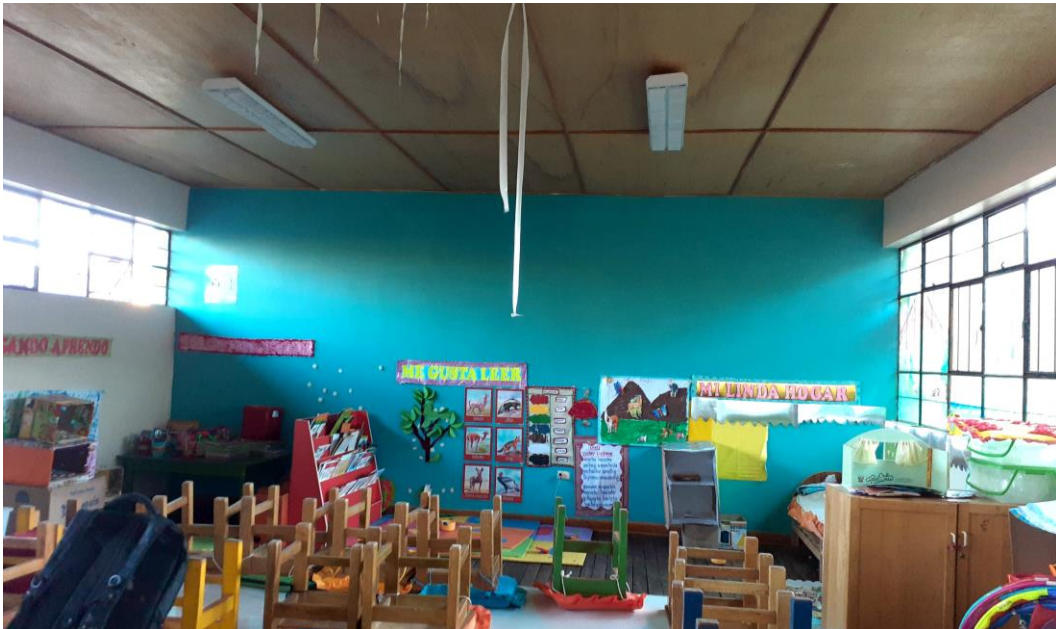
FOTO 19: Imagen corresponde al interior del aula N° 3 (Pabellón IV). Los muros y el acabado se encuentran en buen estado de conservación. El falso cielo raso es de planchas de triplay con listones de madera, el piso y el contra zócalo es de madera y se encuentran en buen estado de conservación.
