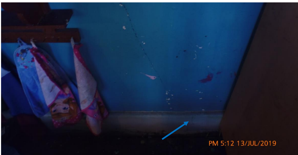
FOTO 9: Imagen corresponde al interior del aula N° 1 (Pabellón I). El contra zócalo es de yeso, se encuentra en mal estado de conservación, presenta grietas y desprendimiento en algunos tramos.
