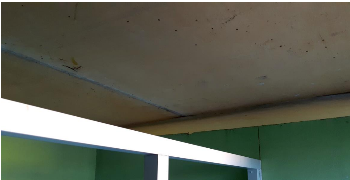
FOTO 30: Imagen corresponde al interior de los SS.HH. (Pabellón VI). El falso cielo raso es de triplay, se encuentra en regular estado de conservación.
