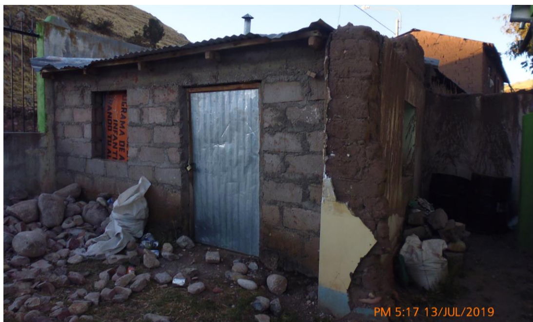
FOTO 17: Imagen corresponde a la infraestructura del depósito (Pabellón III). El depósito no cuenta con vereda de protección. Los muros son de adobe y bloques de cemento, en mal estado de conservación. La puerta es de plancha de calamina metálica. El techo es de estructura de madera cerrada con planchas de calamina metálica, en mal estado de conservación. La infraestructura no cuenta con canaleta de evacuación pluvial.
