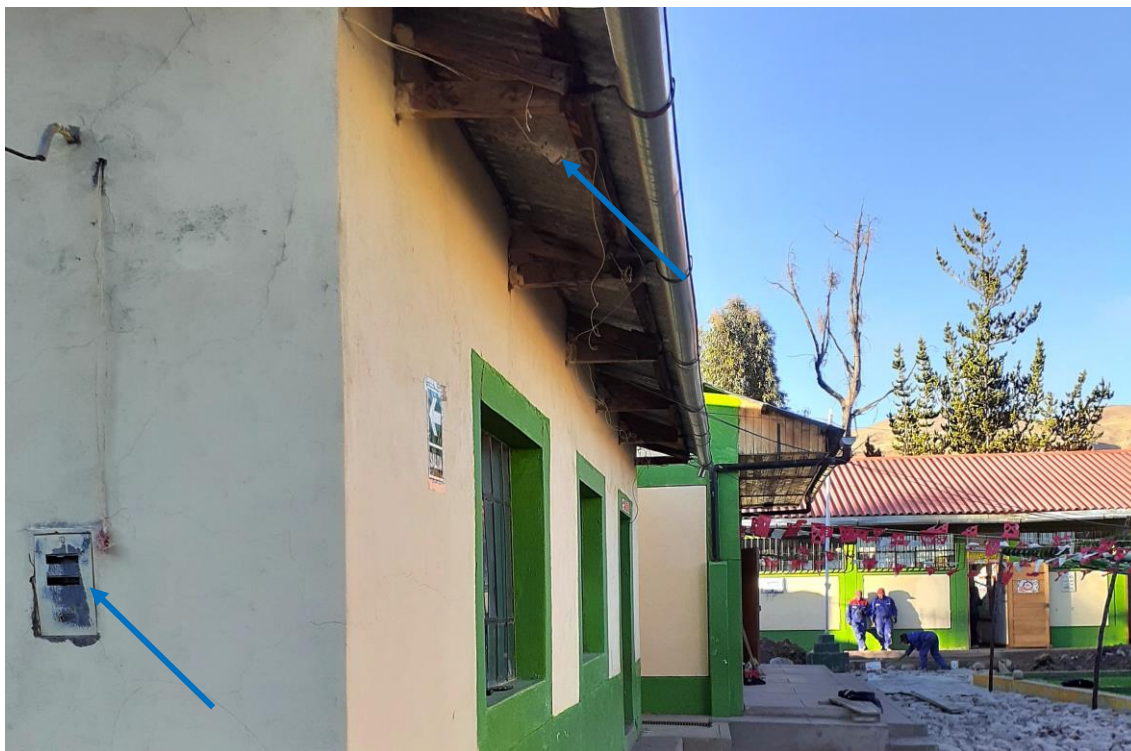
FOTO 22: Imagen corresponde a la infraestructura de la cocina - comedor (Pabellón V). Se puede visualizar el medidor eléctrico del colegio que se conecta a la llave termomagnética general del colegio. El cableado eléctrico es aéreo se encuentra expuesto.
