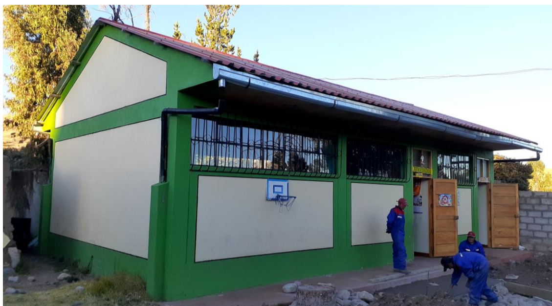
FOTO 11: Imagen corresponde a la infraestructura de la dirección y aula N° 2 (Pabellón II). El aula cuenta con vereda de protección de concreto en mal estado de conservación. Los muros son de albañilería, tarrajado con cemento y pintado, en buen estado de conservación. Carpintería de madera en puertas y carpintería metálica en ventanas, se encuentran en buen estado de conservación. El techo es de estructura de madera cerrada con planchas metálicas tipo canalones a 2 aguas, se encuentra en buen estado de conservación. La infraestructura cuenta con canaleta de evacuación pluvial con montante. Tienen bruña de 1.5 cm de altura.
