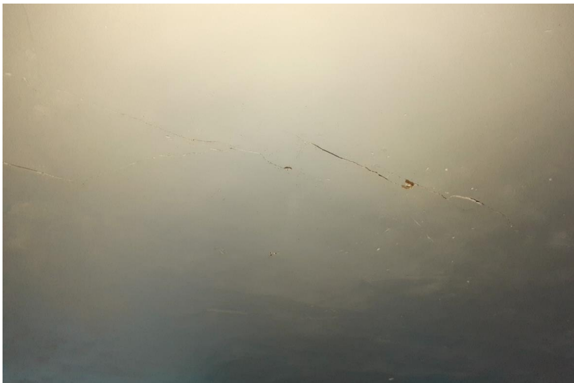
FOTO 26: Imagen corresponde al interior de la infraestructura de la cocina - comedor (Pabellón V). El falso cielo raso es de carrizo con yeso, se encuentra en mal estado de conservación, presenta grietas y desprendimiento de material.
