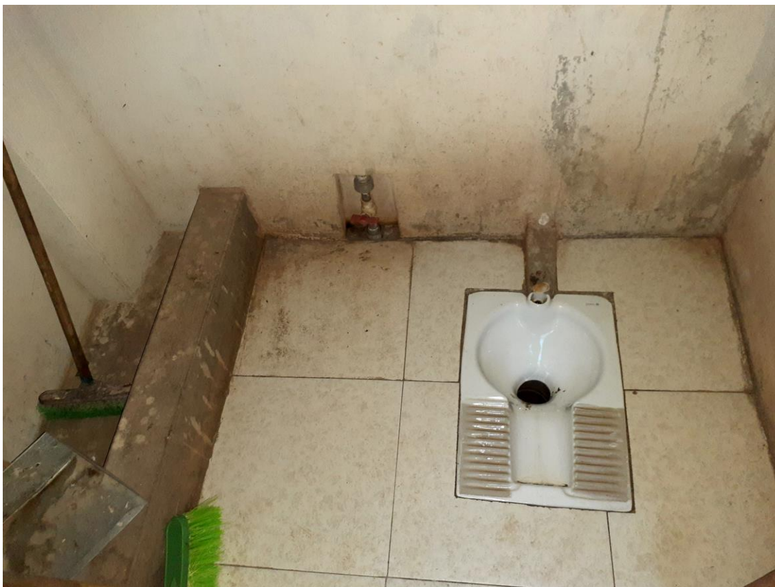
FOTO 32: Imagen corresponde al interior de las letrinas (Pabellón VII). El piso es de cerámico, se encuentra en buen estado de conservación.
