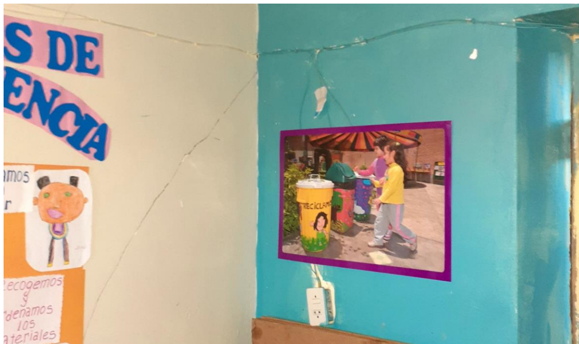
FOTO 10: Imagen corresponde al interior del aula N° 1 (Pabellón I). El cableado y los aparatos eléctricos están en mal estado de conservación, se encuentran expuestos y deteriorados.
