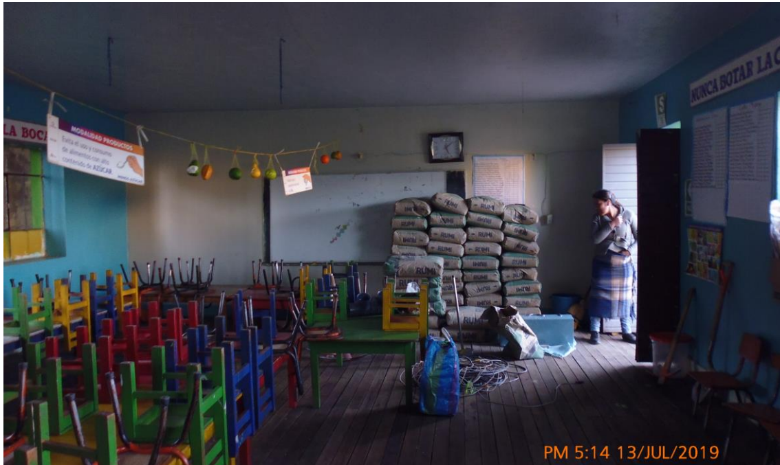
FOTO 24: Imagen corresponde al interior de la infraestructura de la cocina - comedor (Pabellón V). El piso es de madera, se encuentra en regular estado de conservación. El contrazócalo es de yeso y el acabo de los muros se encuentran en regular estado de conservación.
