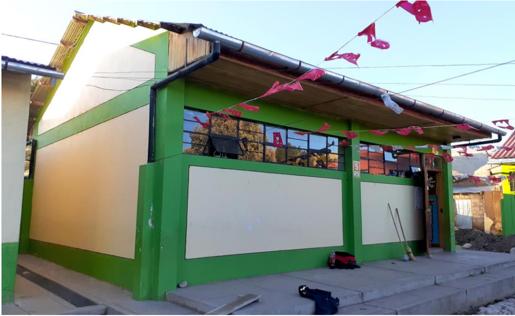
FOTO 18: Imagen corresponde a la infraestructura del aula N° 3 (Pabellón IV). El aula cuenta con vereda de protección de concreto en buen estado de conservación. Los muros son de albañilería, tarrajado con cemento y pintado, en buen estado de conservación. Carpintería de madera en puerta y carpintería metálica en ventanas, se encuentran en buen estado de conservación. El techo es de estructura de madera cerrada con planchas de calamina metálica, a 2 aguas, se encuentra en buen estado de conservación. La infraestructura cuenta con canaleta de evacuación pluvial con montante. Tienen bruña de 1.5 cm de altura.
