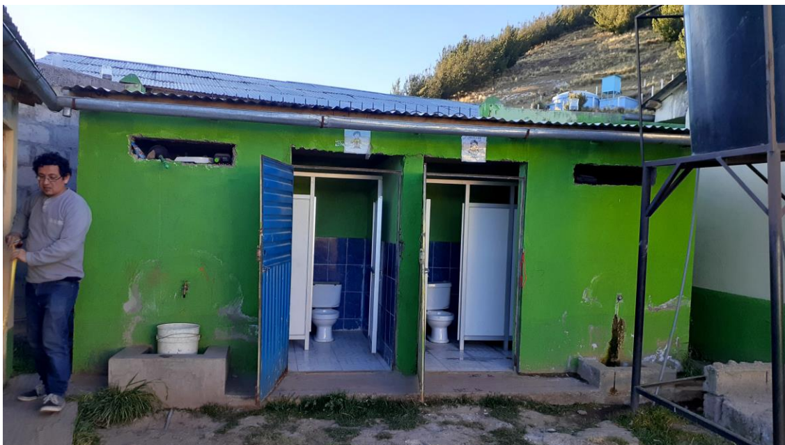
FOTO 28: Imagen corresponde a la infraestructura de los SS.HH. (Pabellón VI). El sistema constructivo es de bloques de cemento tarrajado con cemento y pintado, se encuentra en regular estado de conservación. El techo es de estructura de madera cerrada con planchas de calamina metálica, se encuentra en regular estado de conservación. La vereda de protección es de cemento frotachado, se encuentra en buen estado de conservación.
