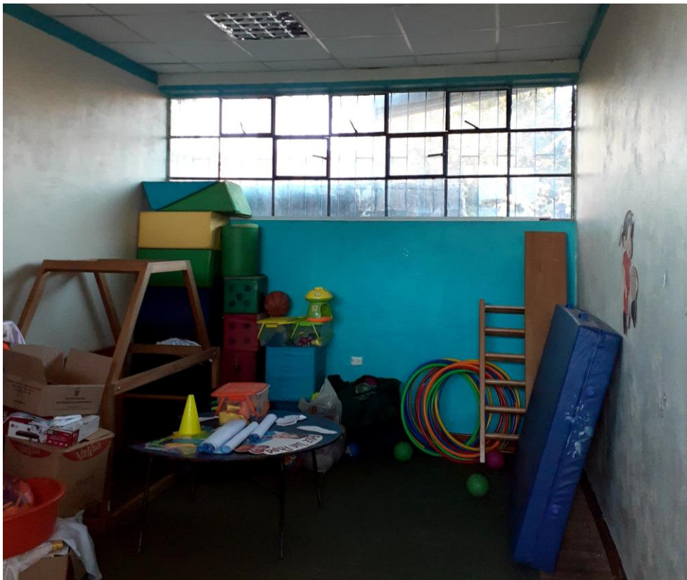
FOTO 14: Imagen corresponde al interior de la dirección (Pabellón II). Los muros y el acabado se encuentran en buen estado de conservación, El falso cielo raso es de baldosas acústicas, el piso y el contra zócalo es de madera y se encuentran en buen estado de conservación.
