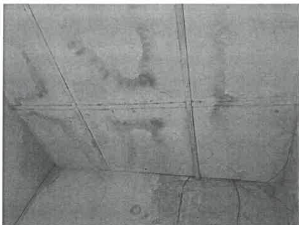
Se puede observar el mal estado del cieloraso(dañado)
