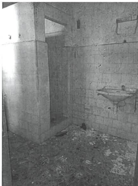
Se puede observar los aparatos sanitarios, en malas condiciones.
