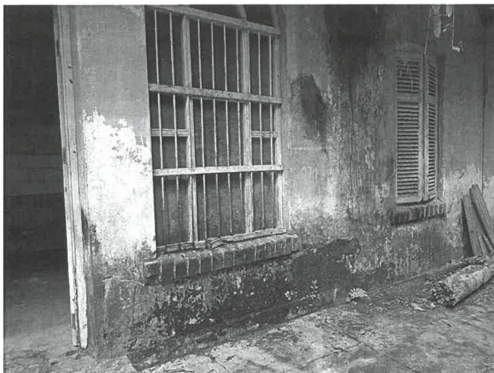
Se puede observa el estado de las puertas y ventanas(fisuradas, polilladas)
