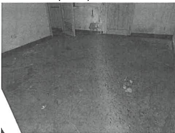
Se puede apreciar el piso y el tarrajeo de los muros en mal estado
