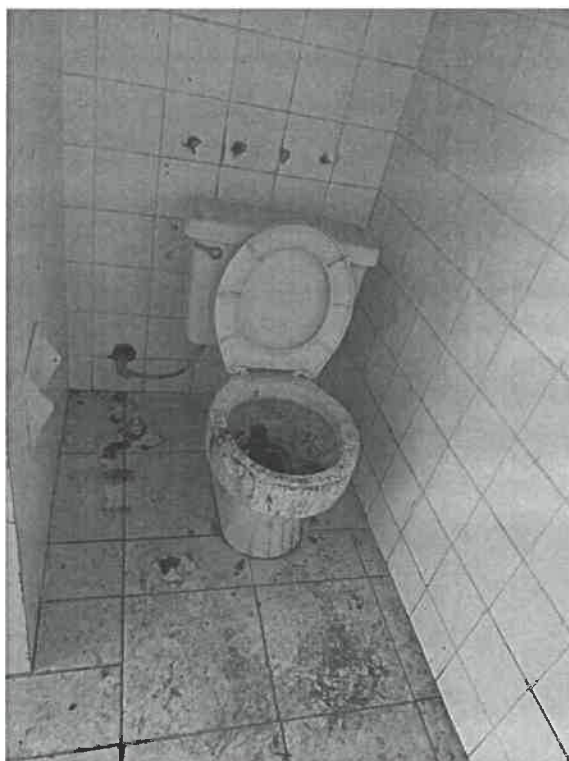
Se puede observar los aparatos sanitarios, en malas condiciones.
