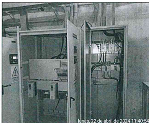
Imagen nro. 4 – tablero de transferencia antiguo e inoperativo a desmontar
