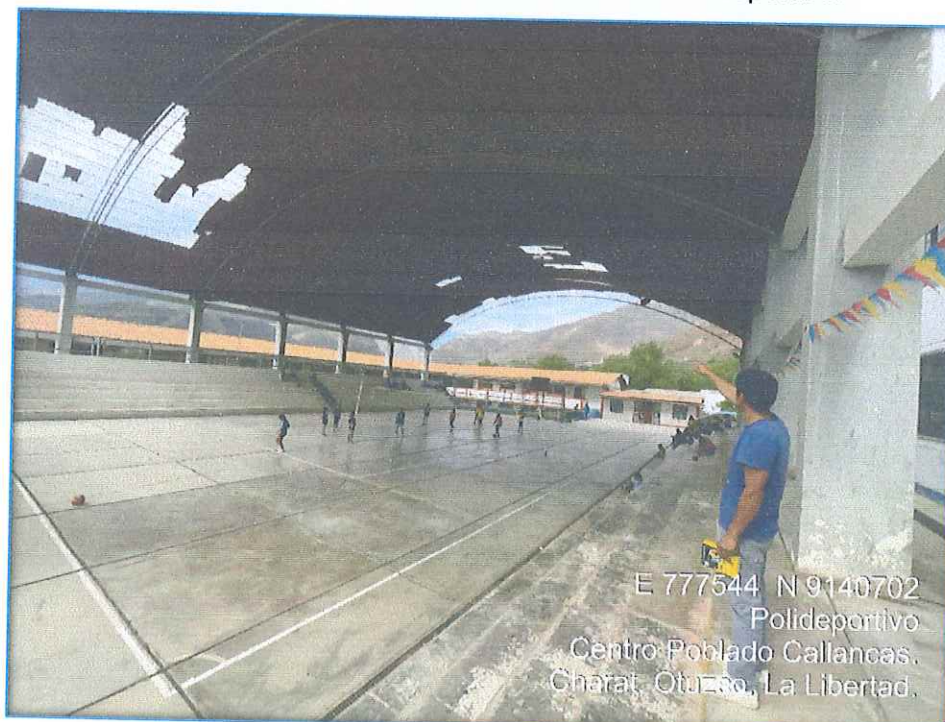
Imagen N°08: Cobertura deteriorada de Polideportivo.
