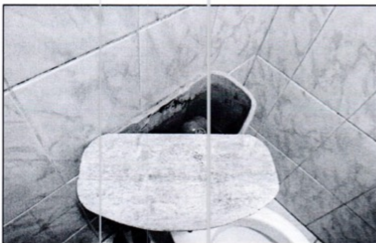
Imagen 4: Aparato sanitario sin accesorios y no funciona correctamente.
