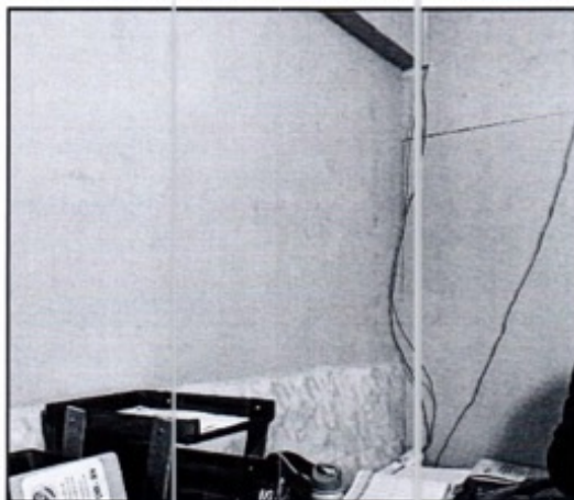
Imagen 6: Tomacorrientes no se encuentran fijados y falta de canalización de cables.
