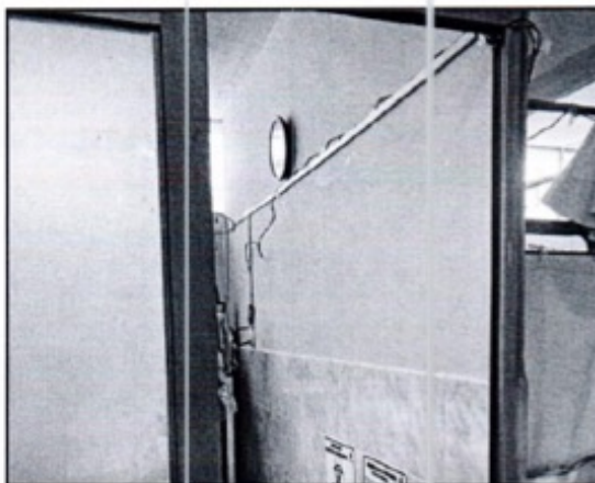
Imagen 5: Presencia de acumulación de cables expuestos, canaletas desprendidas.
