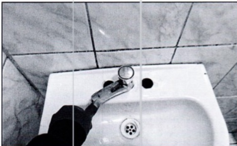
Imagen 3: Aparatos sanitarios deficientes en el SSHH y accesorios presenta filtraciones de agua.
