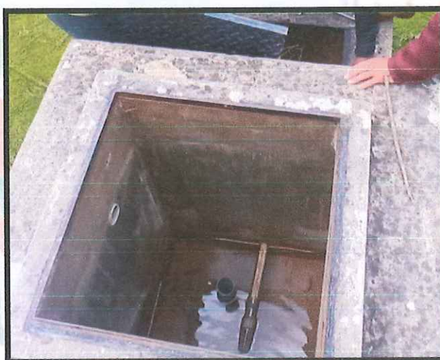
Fotografía N°02: Interior de la Captación de ladera
