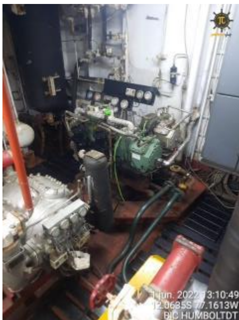
43&44. Compresoras de los sistemas de frio mostrando falta de mantenimiento
