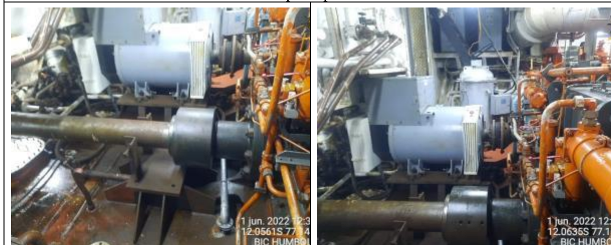
23&24. Caja reductora y salida del eje.
