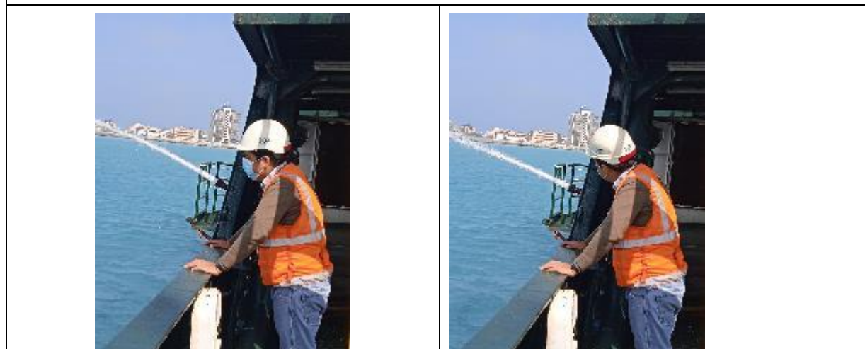
55&56. Prueba del sistema contra incendio
