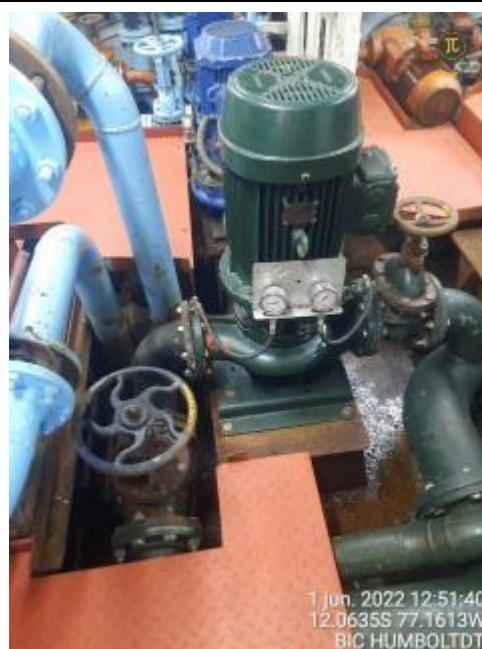
37&38. Manifold y bomba en buenas condiciones
