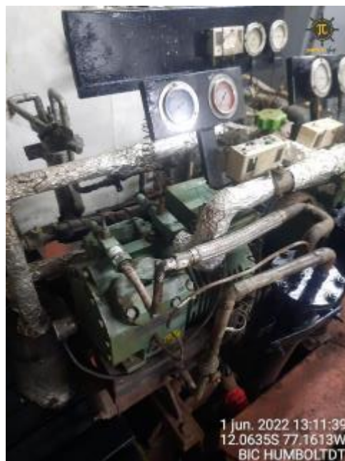
43&44. Compresoras de los sistemas de frio mostrando falta de mantenimiento
