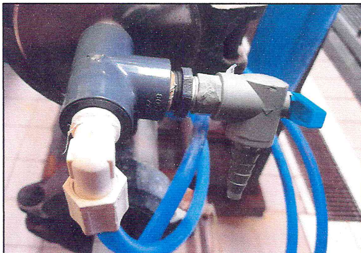
Toma muestra: incluye codo, Tee SAP, bushing y toma muestra azul
