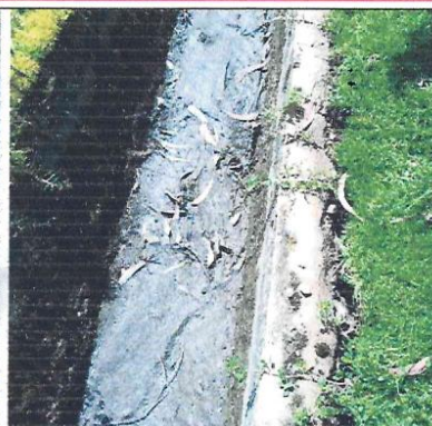
Fotografía N° 20: Colapso de base de canal
