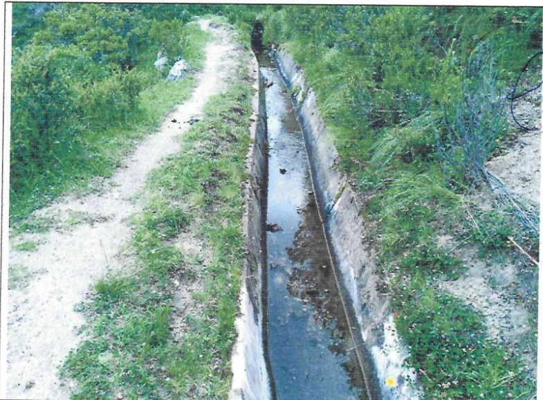
Fotografía N° 03: Vista panorámica de canal existente forma trapezoidal con medidas 0.45*0.60*0.40m
