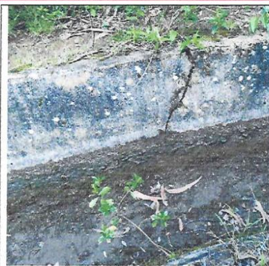
Fotografía N° 19: Fisura en lateral de canal
