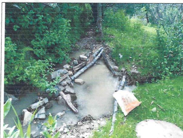
Fotografía N° 28: Desarenador artesanal de tierra en pésimas condiciones
