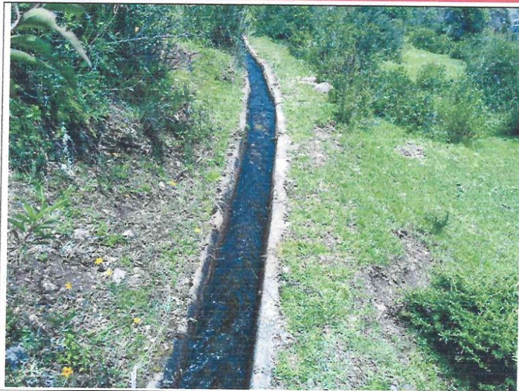
Fotografía N° 14: canal de concreto de forma trapezoidal 0.20x0.20x0.30m.
