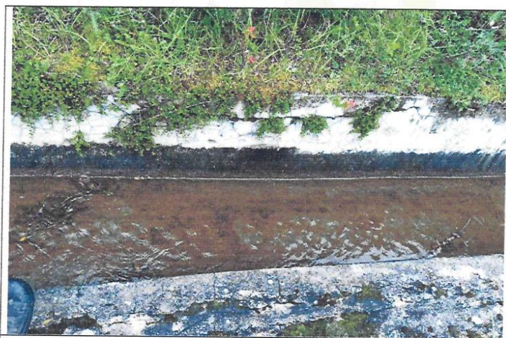
Fotografía N° 05: Canal de concreto en estado deterioro generalizado y invadidas con hierbas
