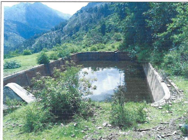
Fotografía N° 15: Reservorio existente cap: 317 m3, su estado operativo
