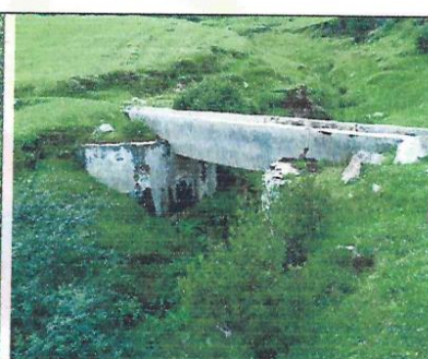
Fotografía N° 11: Cruce aéreo tiene una longitud de 5m
