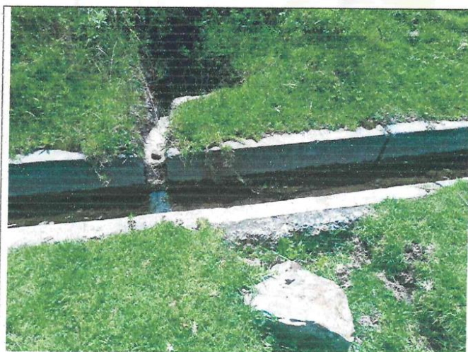
Fotografía N° 26: Se observa cámara de carga al costado de canal, a partir se instala riego por aspersión a iniciativa de las familias.
