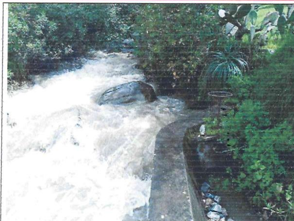
Fotografía N° 27: Bocatoma en río macahuire parte baja su estado operativo y pésimas condiciones
