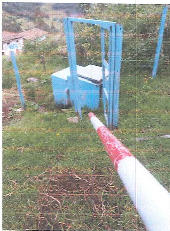
Caja rompe presión en buen estado con tapas con oxidación y paredes en buen estado
