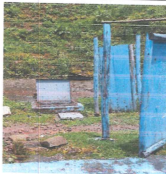
Captación típica, con tapa en buen estado y tubería buen estado, no presenta rotura. Necesita mantenimiento
