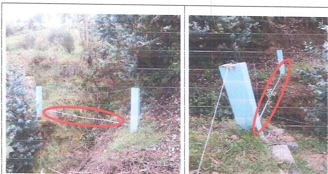
Vista de pase aéreo donde se aprecia la Tubería de PVC, la cual es inadecuada para este tipo de obra, lo cual con el tiempo provoca filtraciones de agua dejando a la población sin agua.
