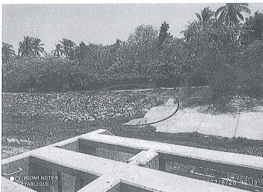
Foto N°06: Zona de reposición con roca y protección con concreto simple F'c=210 \text{ Kg/cm}^2 .
