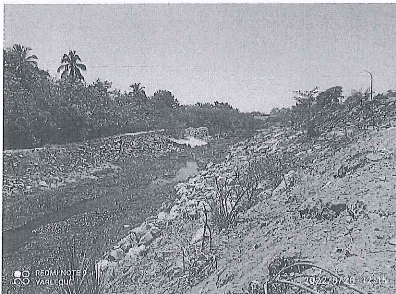
Foto N° 05: Talud derecho del dren ND01 necesitando pronta reposición de enrocado.
