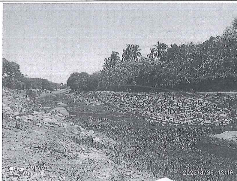
Foto N°04: Talud derecho del Dren ND01 en mal estado.
