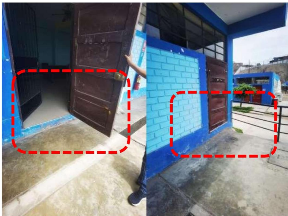
Fotografía N° 03.- Vista de Rampa N°02 y N°03 sin acceso de rampa peatonal hacia laboratorio con ingreso a desnivel, se propone una rampa con descanso.
