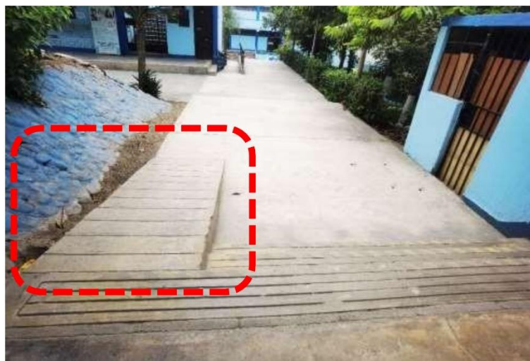
Fotografía N° 01.- Vista de Rampa N°01 cuenta con una rampa que no cumple con la normativa vigente, en cuanto a pendiente, barandas y dimensiones reglamentarias
