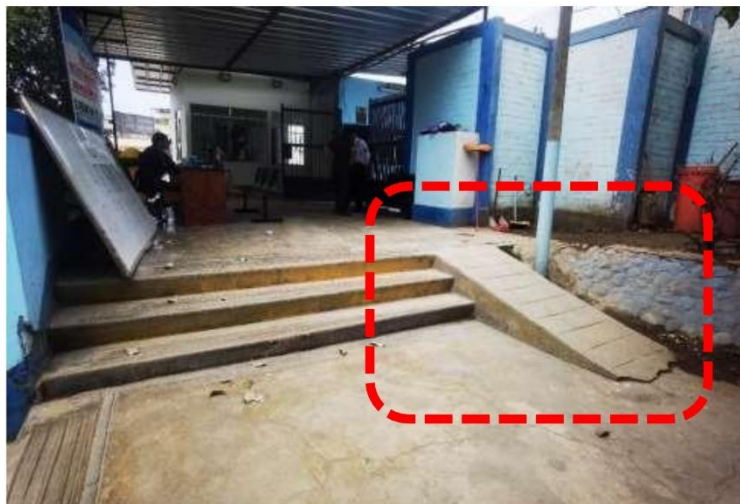
Fotografía N° 01.- Vista de Rampa N°01 cuenta con una rampa que no cumple con la normativa vigente, en cuanto a pendiente, barandas y dimensiones reglamentarias
