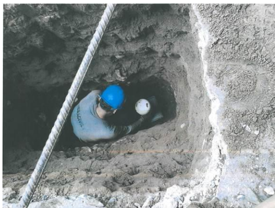
Figura 14 Excavación manual de calicata
