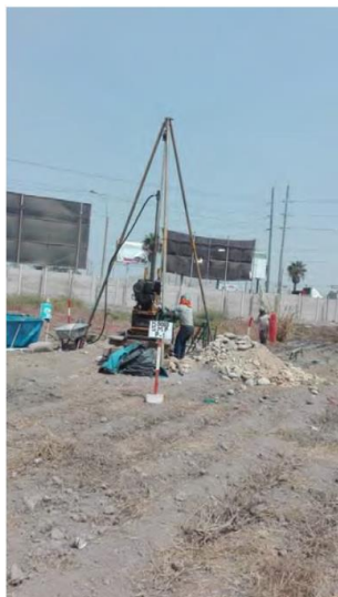
Figura 12 Vista panorámica y cercana de equipos de perforación (Fuente: MyM y ESONDI)
