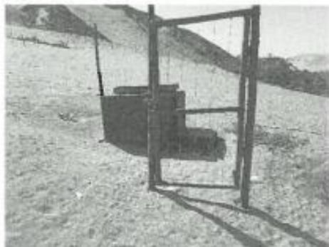
Foto N°3. Caja repartidora de Caudal existente en Casa Blanca de 1.35m x 1.35m x 0.90m altura, será renovado para mayor tamaño por este expediente, aquí culmina la Línea de Conducción CP CASA BLANCA, CP LAS TRANCAS, CP COPARÁ, CP LA JOYA en el pto: E= 514 099 .367, N= 8 345 193 .4708. Aquí inicia la línea de conducción hacia Chauchilla de C.P CHAUCHILLA, C.P PORONA, Y C.P POROMA en : E= 514 087 .0566; N= 8 345 192 .9472
