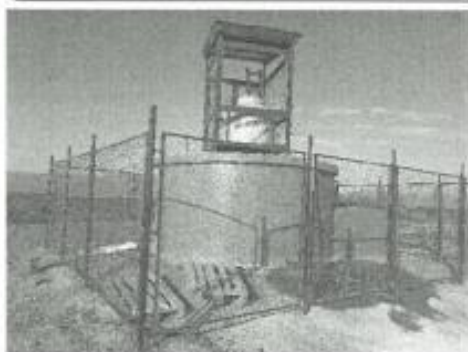
Foto N°5. Reservorio existente en zona de chauchilla es de 15m 3 , será ejecutado otro más al costado de 20m 3 por este expediente, a qui culmina la línea de conducción hacia Chauchilla de C.P CHAUCHILLA, C.P PORONA, Y C.P POROMA en : E= 507 995 4539; N= 8 344 739 .3663
