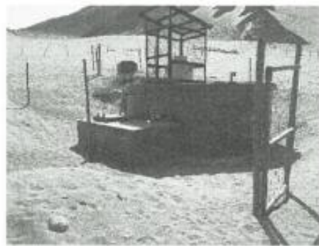
Foto N°4. Reservorio existente en Casa Blanca es de 25m 3 , será ejecutado otro más al costado de 40m 3 por este expediente, el pto del C.G : E= 514 084 .8737 , N= 8 345 182 .8184
