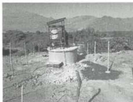
Foto N°2. Reservorio existente de Santa Luisa de 7m 3 , será ejecutado uno más al lado de mayor tamaño de 15m 3 por otro proyecto, aquí llega de la nueva caja repartidora de caudal.
