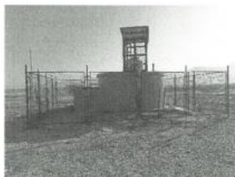
Foto N°5. Reservorio existente en zona de chauchilla es de 15m 3 , será ejecutado otro más al costado de 20m 3 por este expediente, en el pto del C.G : E= 514 084 .8737 , N= 8 345 182 .8184
