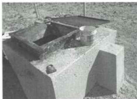
Foto N°1. Caja repartidora de Caudal existente en Santa Luisa de 1.35m x 1.35m x 0.90m altura, será renovado para mayor tamaño por otro proyecto y, de aquí inicia la Línea de Conducción del CP CASA BLANCA, CP LAS TRANCAS, CP COPARÁ, CP LA JOYA en el pto: E= 519 013 .3595; N= 8 344 724 .733
