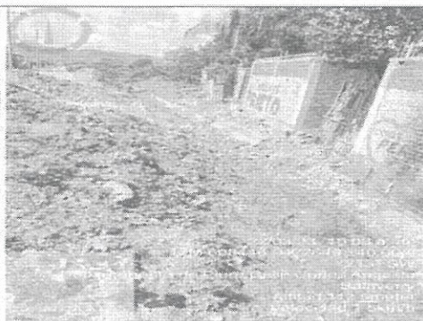
Foto N° 04 Se aprecia que el canal a perdido su cauce debido a la colmatacion de la zona
