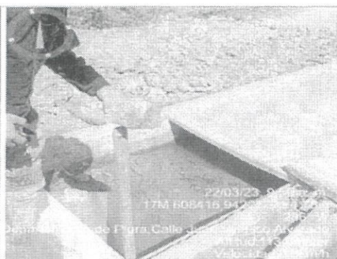
Foto N° 02 En la imagen se aprecia que la caja del canal se encuentra totalmente colmatada de sedimento
