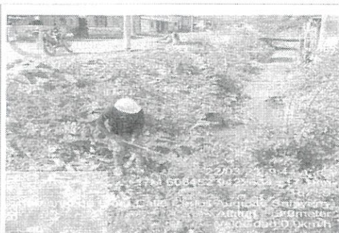
Foto N° 07 Se observa que la caja hidráulica del canal se encuentra totalmente colmatada de sedimentos y maleza producto de las intensas lluvias
