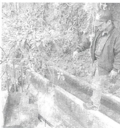
Foto N° 03 Canal colmatado y con falta maleza, requiere descolmatacion y desbroce
