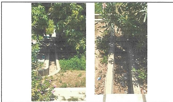
FOTO 05: SE OBSERVA CUNETAS DETERIORO Y COLMATADA DE BASURA, PLANTAS
