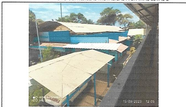
FOTO 02: COBERTURA DE POLICARBONATO EN MAL ESTADO
