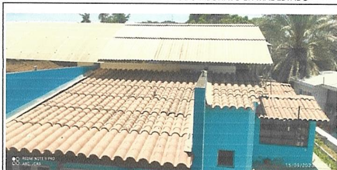
FOTO 02: COBERTURA DE POLICARBONATO EN MAL ESTADO
