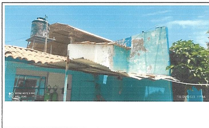
FOTO 04: SE OBSERVA TEJAS ANDINA DETERIORADAS, COBERTURA EN MAL ESTADO
