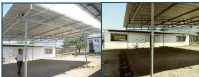
Fotos N° 68-69: En vistas se aprecia patio de formación techado con calaminón. Piso a tierra.
