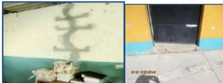
Fotos N° 45-47 : Se aprecia la parte frontal e interior del ambiente acondicionado para almacén con muros rajados, veredas en la parte frontal en mal estado. Dejó de funcionar como aula por el alto riesgo que representa. Se ubica en el pabellón 1
