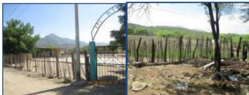
Fotos N° 72-73: En vistas se observa la portada de ingreso y cerco perimétrico rústico construido con palos de hualtaco y varas de overal con alambre de púas el cual no brinda seguridad a la I.E.
